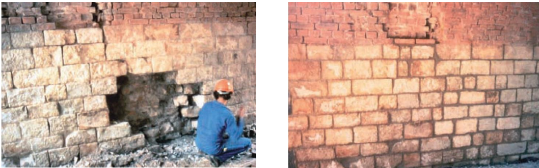
Figure 70 : Remplacement physique de la partie endommagée (Ville de Quebec, 1989)
