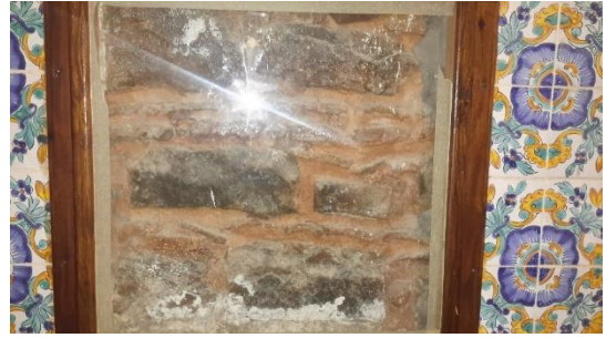
Figure 96 : Les murs porteurs de la mosquée du vieux Ténès (Auteur, 2016)
