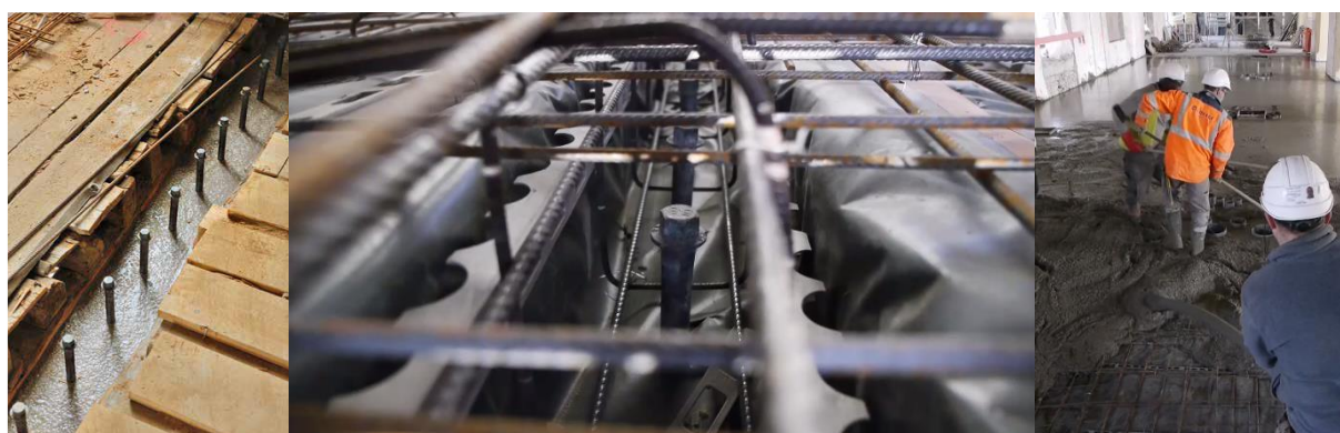
Figure 82 : Planchers connectés (EIFFAGE, Juillet 2017)
