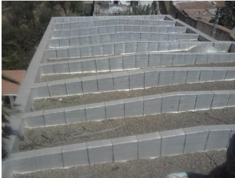
Figure 102 : Toiture de la mosquée du vieux Ténès (Auteur, 2017)
