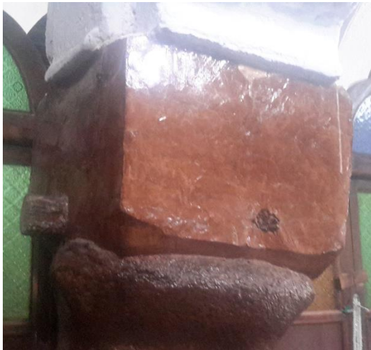
Figure 100: photo actuelle montre les traces des tirants en bois (Auteur, 2017)
