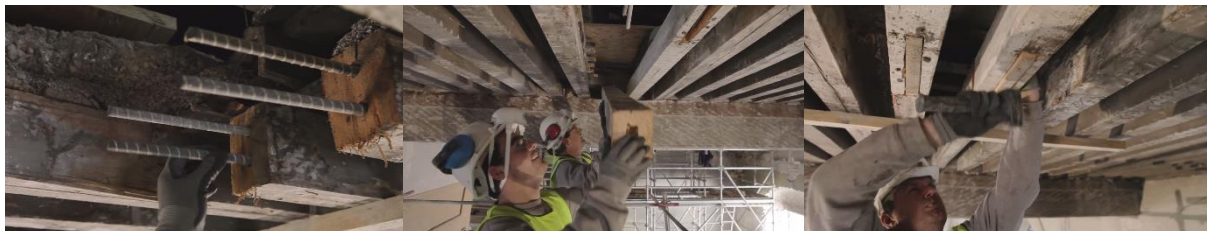
Figure 81 : Technique de prothèse avec PRF (EIFFAGE, Juillet 2017)
