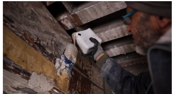
Figure 80 : Technique de prothèse avec PRF (EIFFAGE, Juillet 2017)
