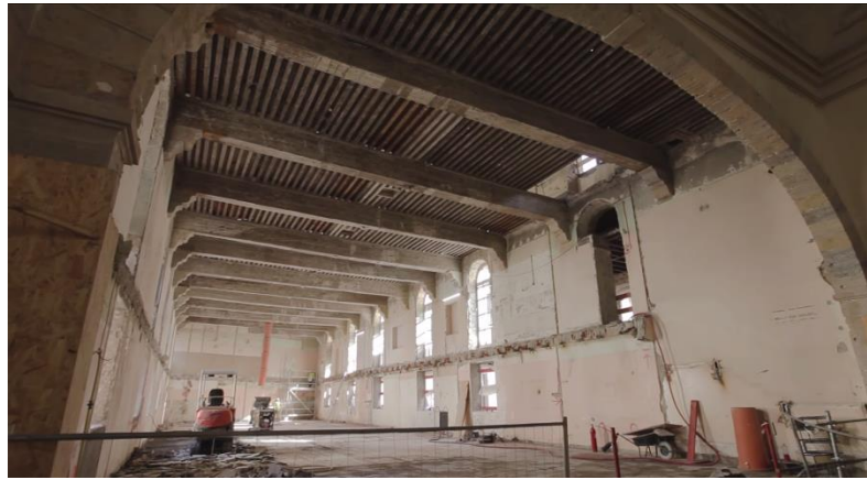
Figure 79 : plafond du grand hotel dieu de lyon (EIFFAGE, Juillet 2017)
