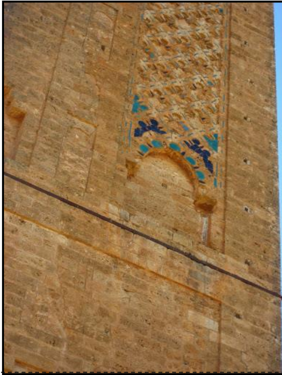
FIGURE 36 : AVANT RESTAURATION DE 2010, ELEVATION LATÉRALE GAUCHE
