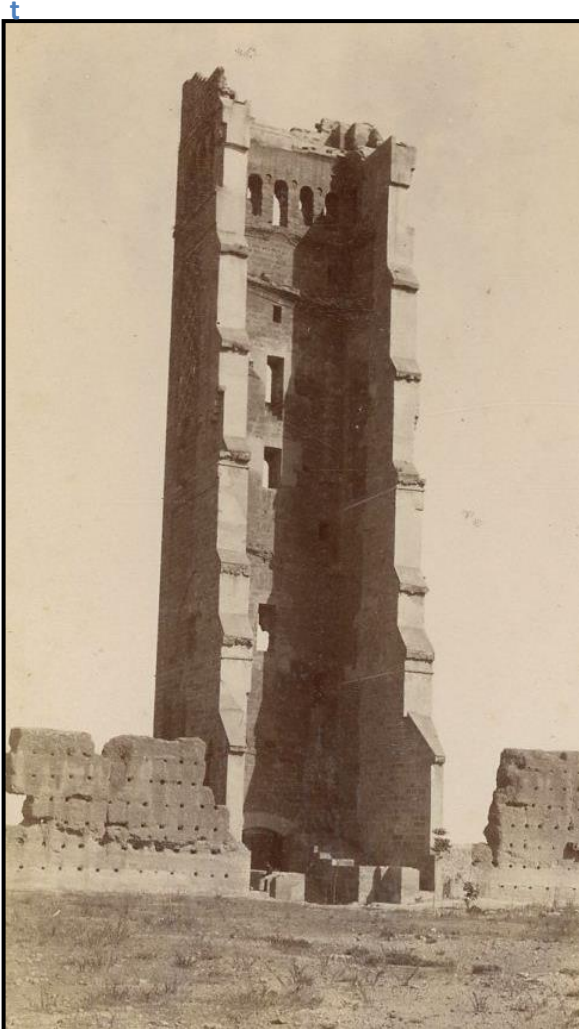
FIGURE 25 : MINARET APRÈS RESTAURATION DE 1877, FACE INTÉRIEUR
