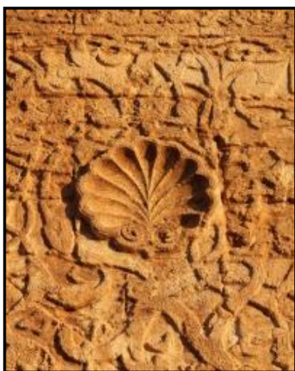
FIGURE 9 : DÉTAIL DU DÉCOR DU PREMIER DÉFONCEMENT DU PORTAIL SOURCE : auteur, aout 2016.
