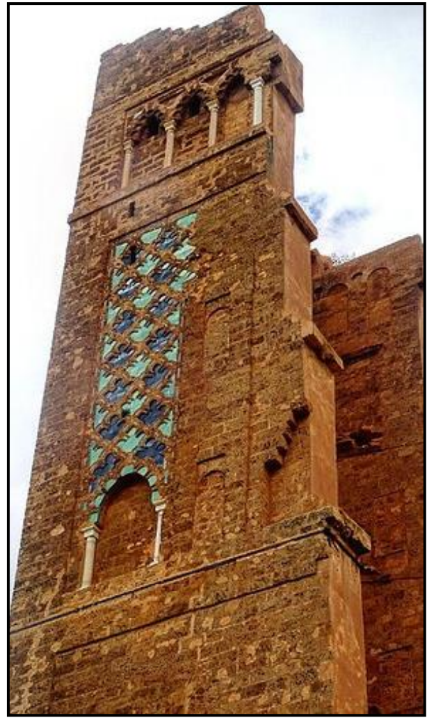
FIGURE 41 : MINARET APRES RESTAURATIO, ELEVATION LATÉRALE DROITE SOURCE : auteur, aout 2016.
