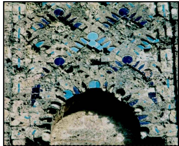
FIGURE 39 : ELEVATION NORD, 1989, DETAIL PARTIE GAUCHE DU PANNEAU
