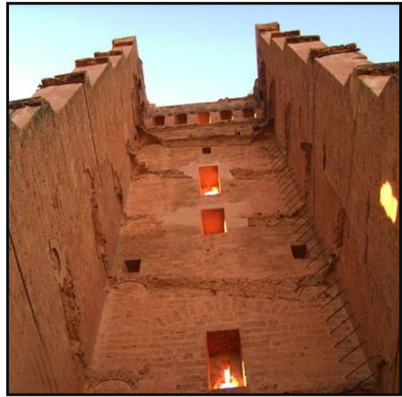
FIGURE 19 : MINARET FACE INTERIEUR SOURCE : auteur , 2016
