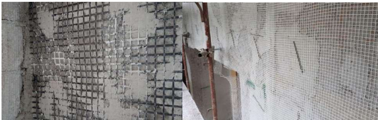
Fig 6.2.2 Application étendue du système FRCM.
