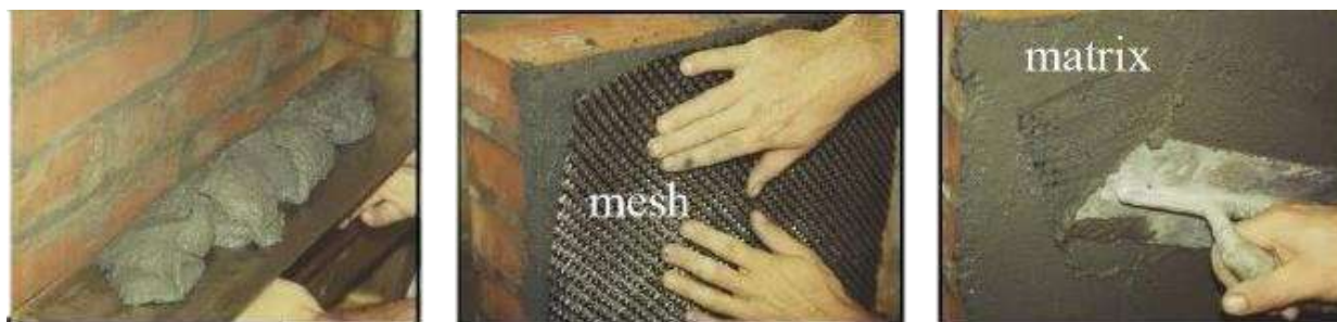
Fig 6.2.8 Application du FRCM sur un mur en maçonnerie (Source : (Nanni, et al., 2016))
