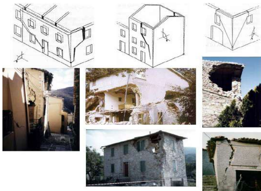
Fig 5.4.12 Schéma du mécanisme de collapse local par rabatement composé (Source : (CNR-ITC, 2007))
