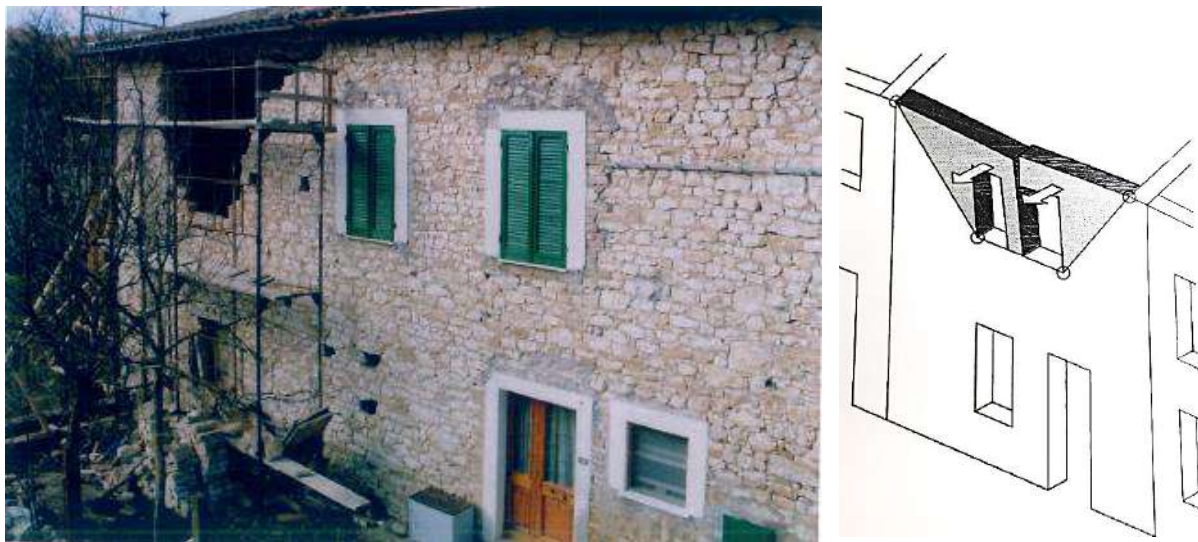
Fig 1.2.9 Exemple d'endommagement par flexion horizontale (source : (Mochi, et al., 2016))
