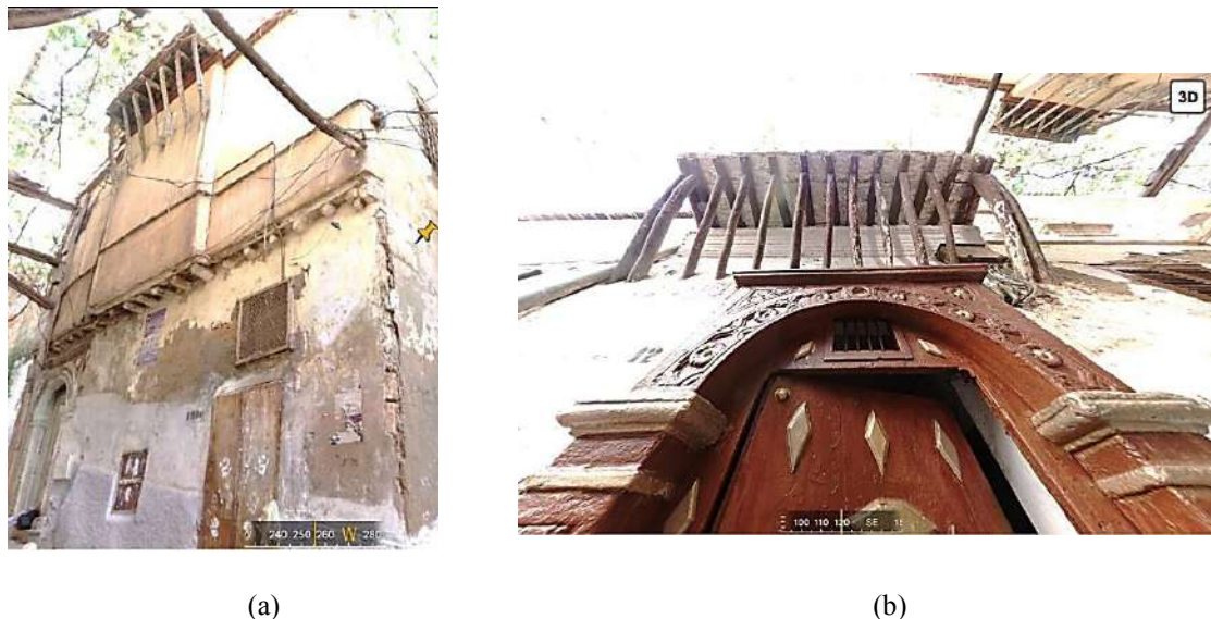
Fig 5.1.4 Détails sur les encorbellements ( K'bou ) (Source : auteur) a) façade principale de la 4 ème maison (agrégat), b) entrée d'une maison adjacente
