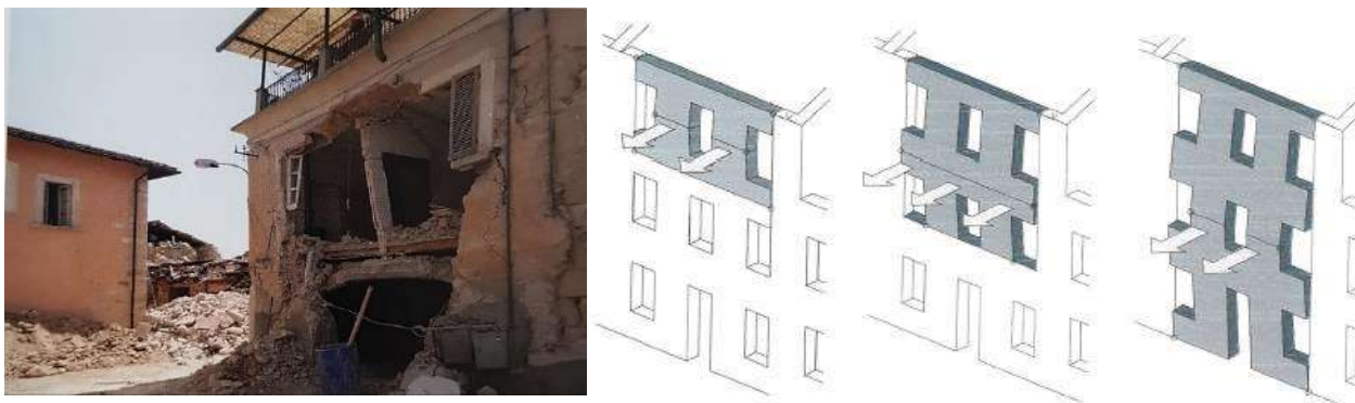
Fig 1.2.10 Exemple d'endommagement par flexion verticale (source : (Mochi, et al., 2016))
