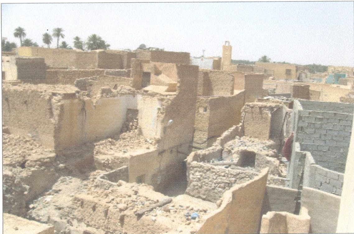
Figure n°32 : L'état rustique de l'habitat Ksourien et la tendance à la construction en parpaing pour le - mieux être -
