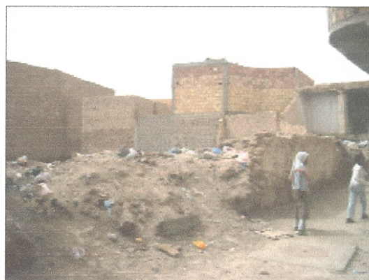
Figure n°59 : La dégradation du patrimoine Ksourien ( Ksar de Ouargla )
