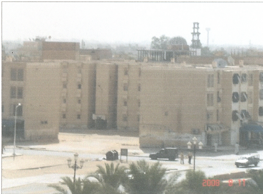
Figure n°51 : L'habitat collectif à Ouargla (324 logements)
