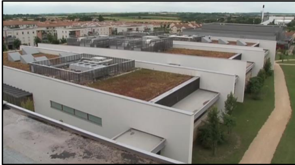
Fig. I.20. Toitures terrasses végétalisées de Lycée Kyoto.
