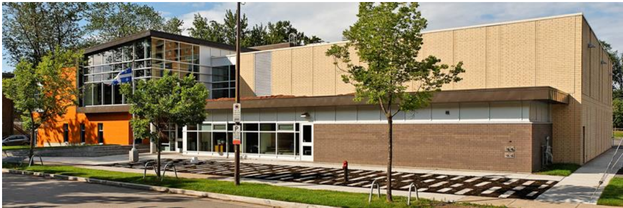
Figure I.24. Vue générale de l'école primaire de la Grande-Hermine. Source : https://www.cscapitale.qc.ca/ecole/ecole-de-la-grande-hermine/
