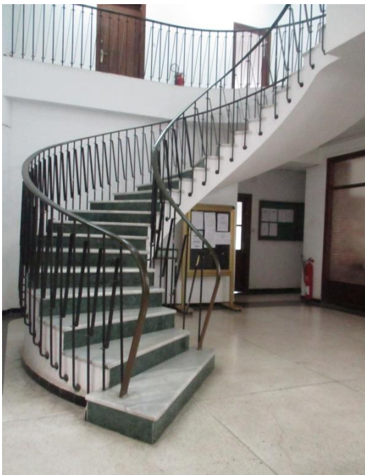
Figure 42 (Gauche) : Escalier balancé intérieur, revêtu de marbre, pièce d'art du bâtiment
