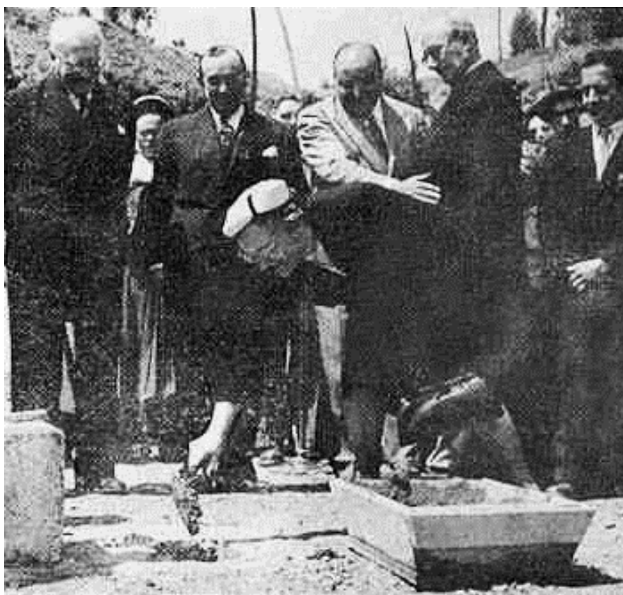
Figure 10 : Photo d'archive de la pose de la première pierre à l'inauguration de l'ouverture du chantier de l'édifice de la Bibliothèque Nationale - 20 avril 1954.
