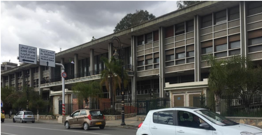
Figure 27 : Photo de l'aspect actuel de l'ex-BNA, témoin du mouvement moderne à Alger
