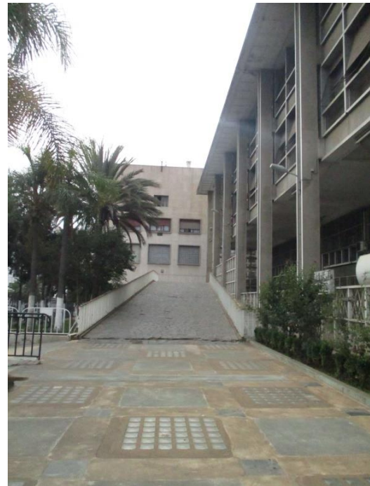
Figure 43 ( Droite ) : Parvis d'entrée à l'ex-BNA, traitement du sol différent et jeu de volumes au sein de l'édifice permettant la création de différentes ambiances, vues et vécues
