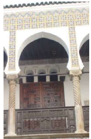
Figure44: Ordre architectonique du niveau supérieur patio Dar Mustapha Pacha, photo : auteur.
