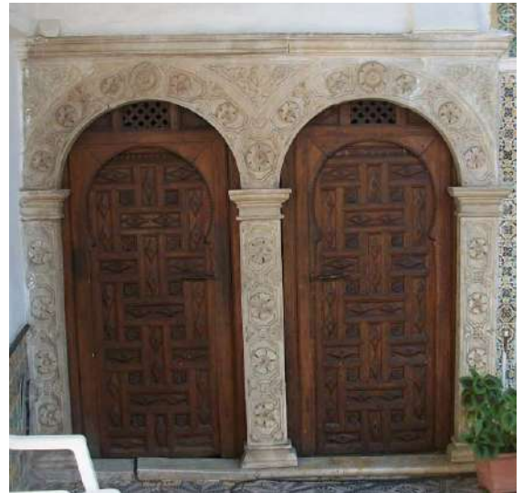
Figure 71 : chambranle des deux portes jumelées de la galerie supérieure, photo : auteur.
