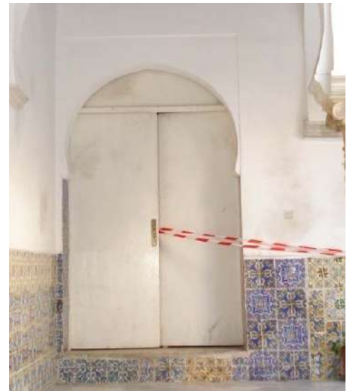
Figure 39 : Porte sur la paroi sud-est de la galerie inférieure différente de toutes les portes du palais, certainement d'époque coloniale. Photo : auteur.
