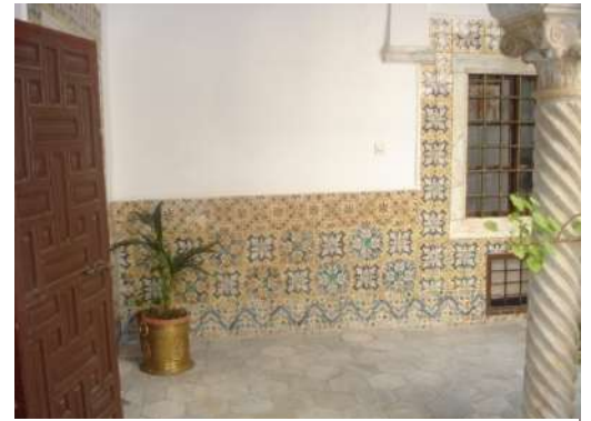
Figure 38 : Soubassement paroi nord-est de la galerie inferieure. Photo : auteur.
