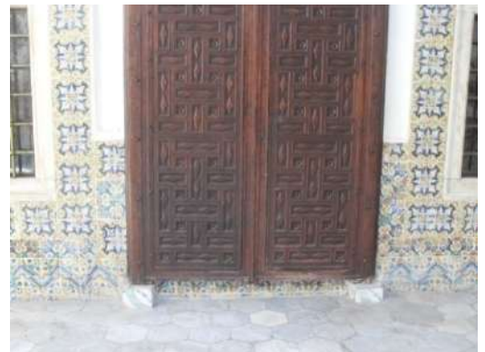
Figure 48 : Porte à deux vantaux s'ouvrant sur le patio, photo : hauteur.
