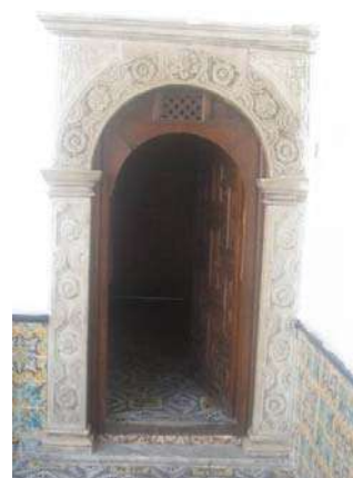
Figure 15 Chambranle de porte, photo : auteur.
