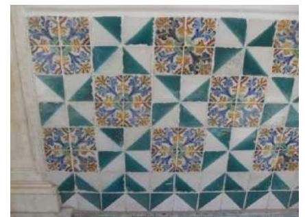
Figure 6: soubassement galerie supérieure dar Mustapha Pacha, photo : auteur.
