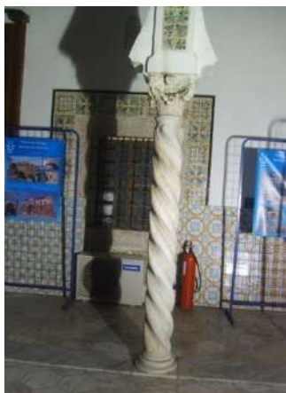
Figure14 : Colonne RDC, Dar Aziza, photo : auteur.
