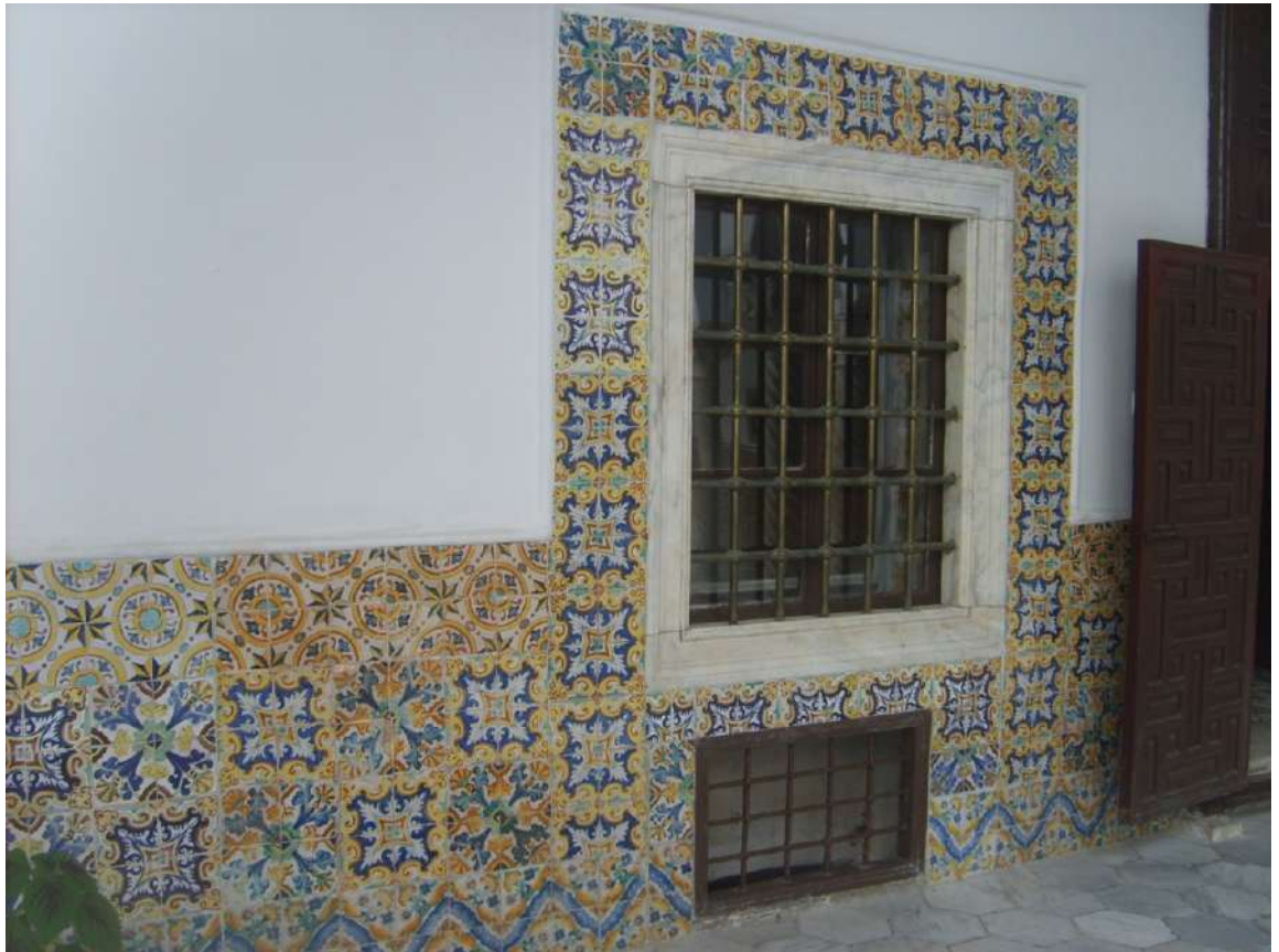
Paroi de la galerie du rez-de-chaussée. Photo auteur, année 2010.
