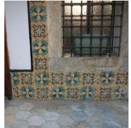
Figure 59 : Soubassement (galerie inférieure) composé de quatre rangées de carreaux, photo : auteur
