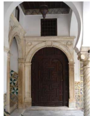
Figure 46 : Chambranle de la porte d'entrée au patio, Dar Mustapha Pacha, photo : auteur.
