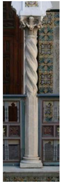
Figure 65: Colonne à fût bi-morphe étage, photo : auteur.
