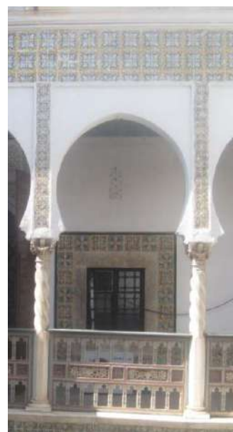
Figure 67 : Ordre architectonique, niveau supérieur. Photo auteur.
