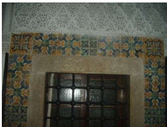
Figure 63: Encadrement d'une fenêtre de la pièce, sous la double galerie, photo : auteur.
