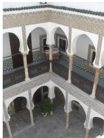
Figure 26 : Vue du patio de dar Mustapha Pacha. Photos auteur.
