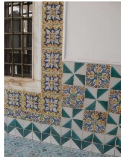
Figure 36 : Encadrement de fenêtre composé du même modèle que celui du rez-de-chaussée, galerie supérieure, photo : auteur.
