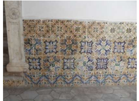
Figure 33: Soubassement de la galerie du RDC de dar Mustapha pacha, photo : auteur.
