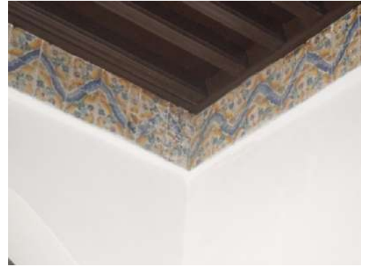
Figure 31: Frise au niveau de la galerie du RDC, photo : auteur.
