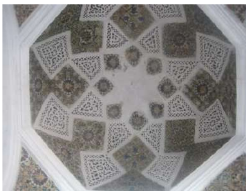
Figure 74: Coupole décorée de carreaux de faïence et de stuc, photo : auteur
