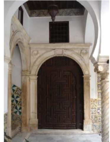
Figure 49 : Porte d'entrée au patio, photo : hauteur.
