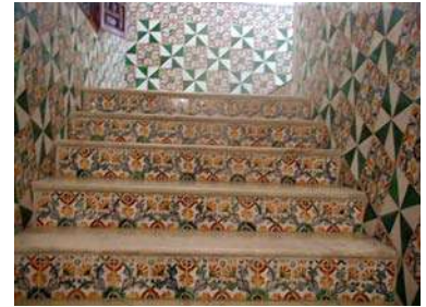
Figure8 : Les carreaux de faïence sur les murs et les contres- marches, Dar Mustapha Pacha, photo auteur.
