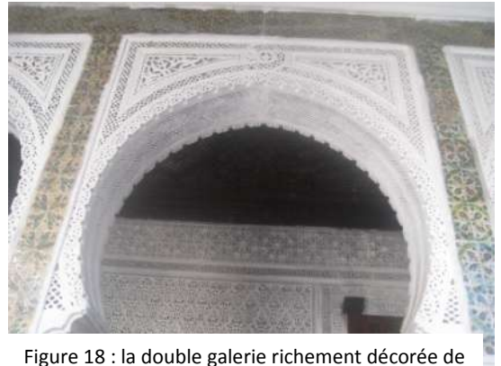
Figure 18 : la double galerie richement décorée de plâtre. Photo : auteur.
