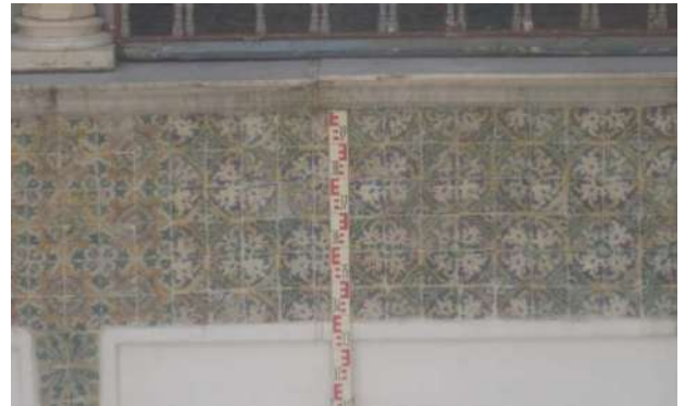
Figure 54 : Frise du rez-de-chaussée, composée de six rangées de carreaux de faïence, photo : auteur.
