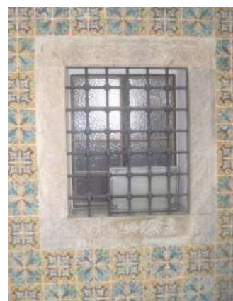
Figure 68 : Fenêtre sur la paroi de la galerie du RDC, photo : auteur.
