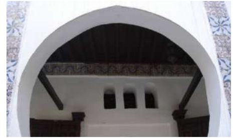
Figure 50 : petites ouvertures au dessus d'une porte, photo : hauteur.
