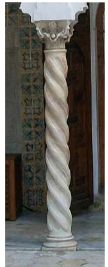
Figure 64 : Colonne à fût torsadé RDC, photo : auteur.
