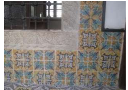
Figure 60: Soubassement (galerie supérieure) composé de six rangées de carreaux, photo.
