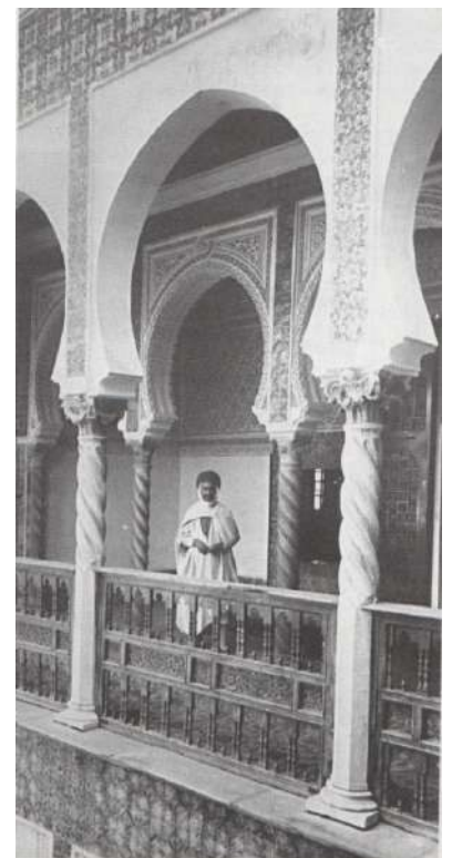
Figure 52: Vue sur la double galerie supérieure, photo : ouvrage GOLVIN.L, p.33.
