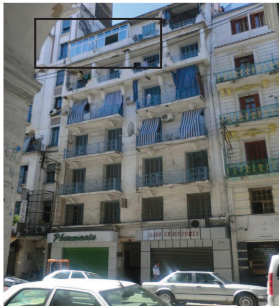
Figure 1 Immeuble d'habitation sur la rue Abane Ramdane a Alger Centre
