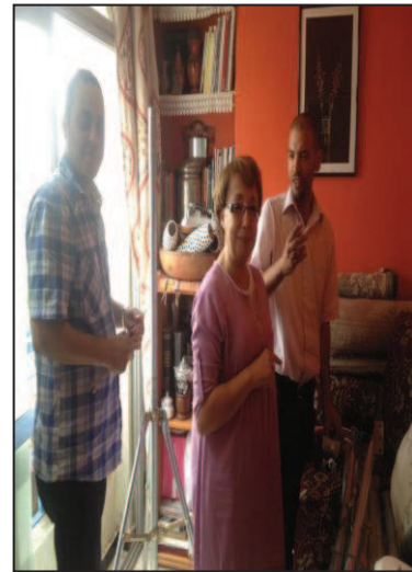
Figure 14 Installation de la station dans le balcon N°1
