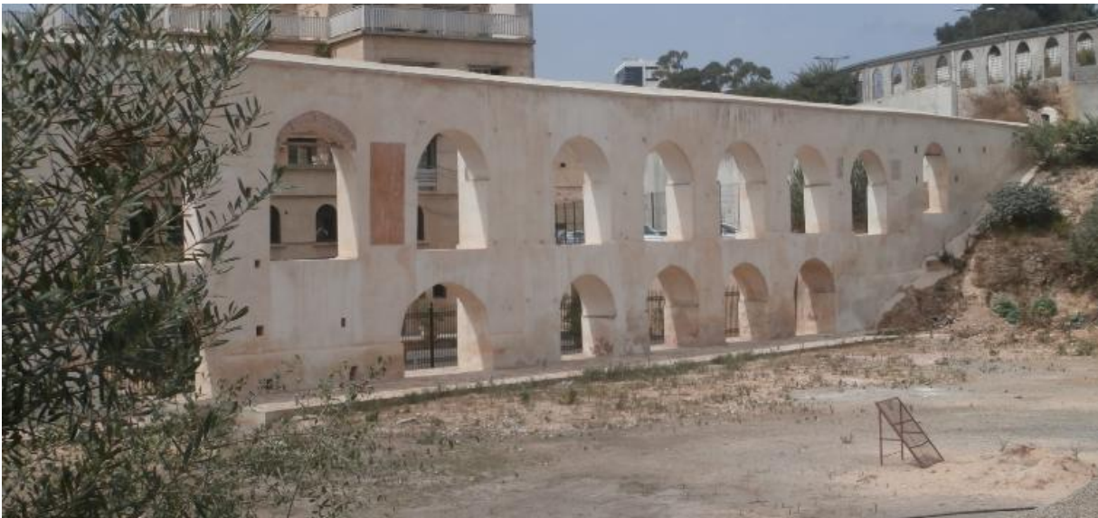
Photo 17: Arcades en plein cintre dans le tronçon aval photo prise par l'auteur aout 2015
