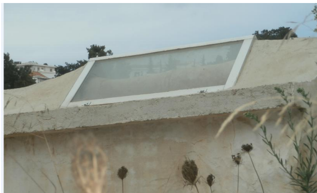
Photo23: La fenêtre archéologique au sommet donne une vus sur les conduites de l'aqueduc. photo prise par l'auteur aout 2015
