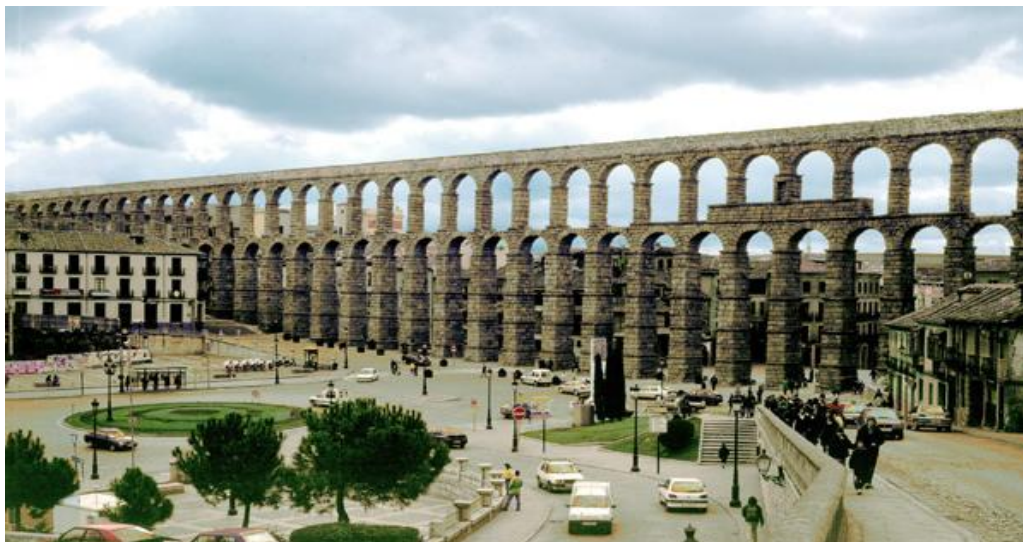
Photo 2: Aqueduc de Ségovie, Espagne source: Google image consulter juillet 2015
