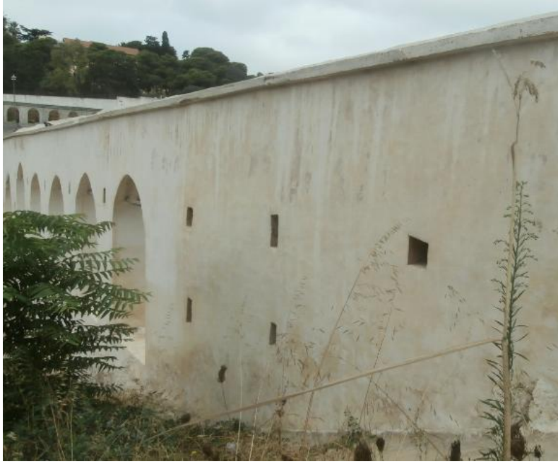
Photo 18: Les trous de boulins ouverts d'une forme de solives en bois photo prise par l'auteur aout 2015
