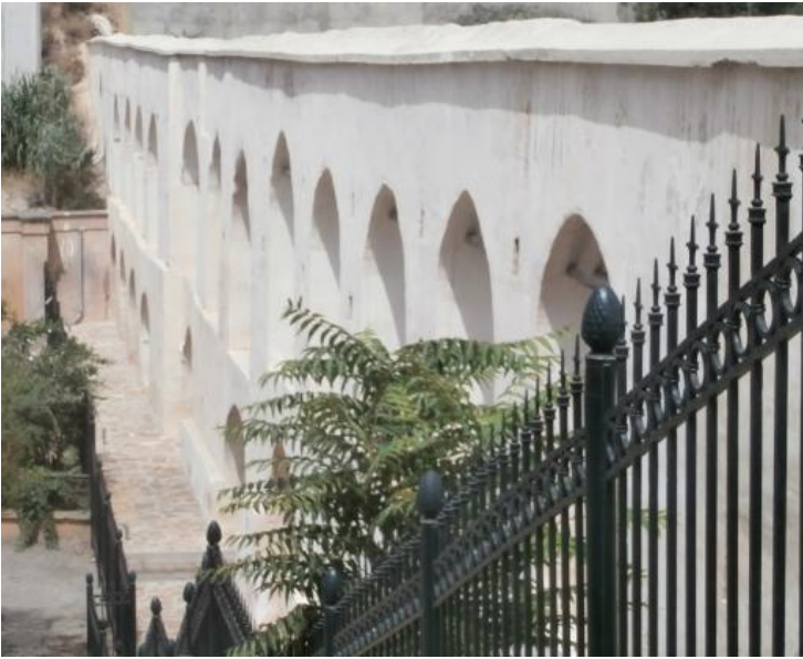
Photo15: Arcades en Ogives en niveau des deux premiers tronçons: Amont et central photo prise par l'auteur aout 2015
