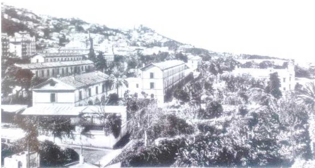
Figure III- 2 : vue générale de l'hôpital Maillot (période coloniale) A droite la demeure du Dey (pavillon des officiers) A gauche les bâtiments de l'hôpital avec la chapelle
