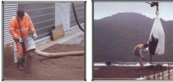
Figure I- 7 : A gauche : Soufflage du substrat à l'état meuble. A Droite : Répartition manuelle du substrat meuble
