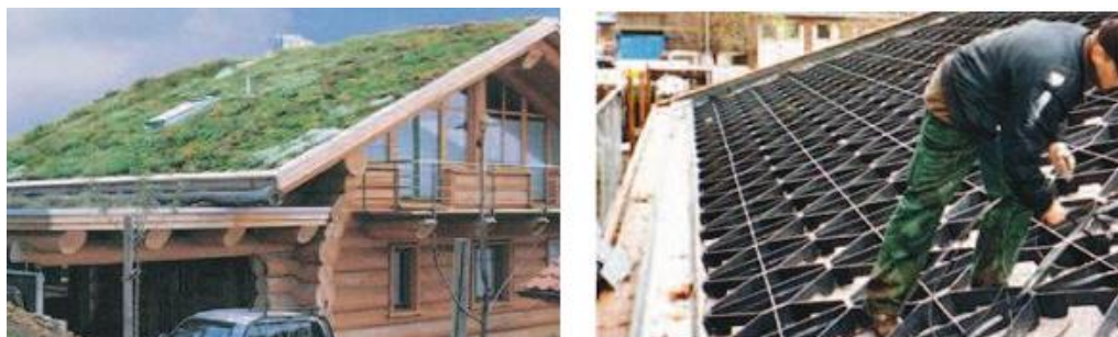
Figure II- 2 : Système de retenue GEORASTER d'Ecovegetal pour pente (jusqu'à 60%)
