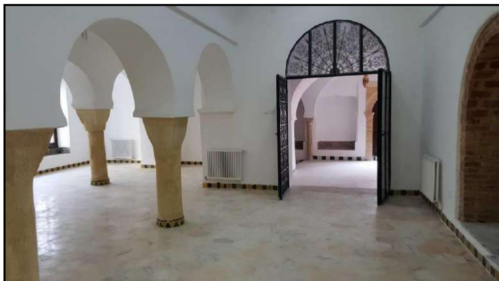
Illustration n°93 : Djenane Raïs-Hamidou , la salle des magasins restituée après les travaux de restauration.
