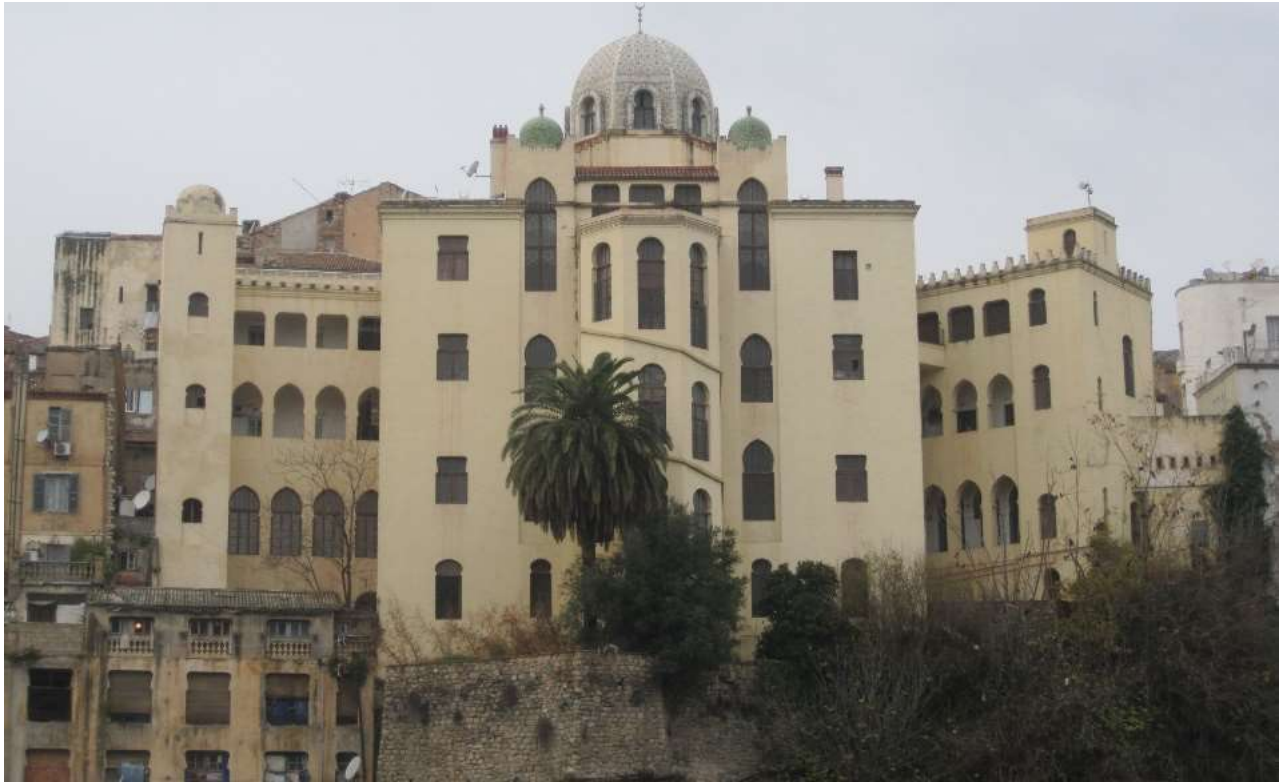
Fig. 186 – Façade postérieure, médersa de Constantine Source : L'Auteur (2013)
