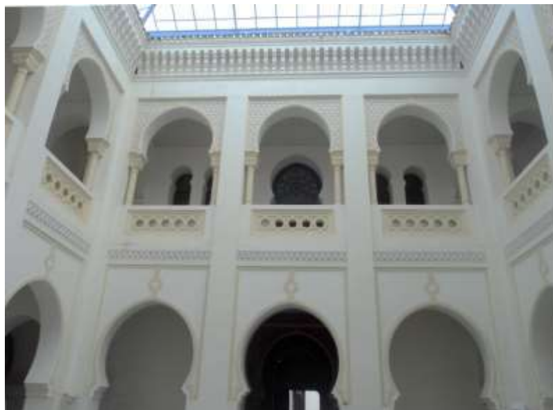
Fig. 159 – Le vestibule de la médersa de Tlemcen Fig. 160 – Vue sur les portiques d'arcades intérieures Source : l'Auteur (2013)
