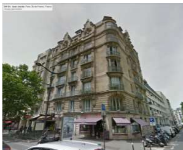
Fig. 78 – Le 60 et 159 avenue Jean Jaurès, Paris, Architecte : Henri Petit
