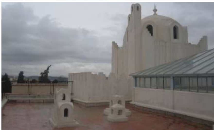
Fig. 156 – La terrasse accessible, médersa de Tlemcen, Architecte : Henri Petit Source : L'Auteur (2013)
