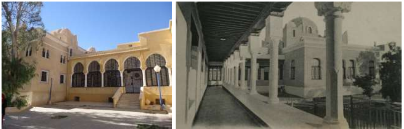
Fig. 111 – Vue des faces postérieures, Casino de Biskra, 1892, Architecte : Albert Ballu Source : l'Auteur (2013) & www.delcampe.net
