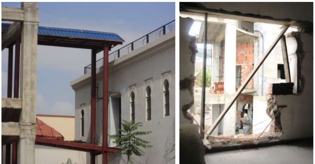
Fig. 173 – Nouvelle extension du musée, sa passerelle de liaison et le percement à l'étage Source : L'Auteur (2013 & 2014)
