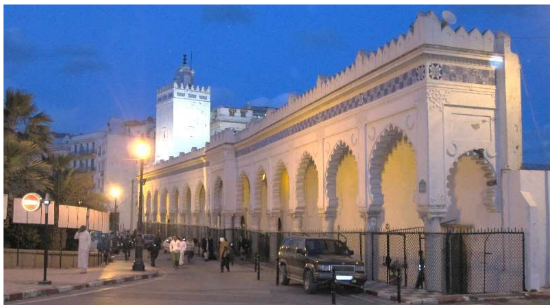
Fig. 29 – La galerie d'arcades polylobées, Djamaâ El-Kabir d'Alger, 1098 Source : l'Auteur (2012).
