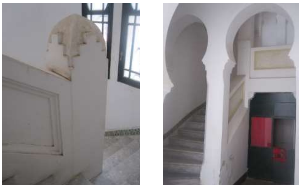
Fig. 163 – L'escalier de la médersa de Tlemcen Source : L'Auteur (2013)
