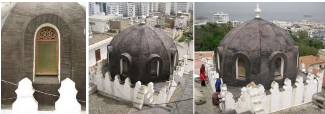
Fig. 134 – Lucarne et extrados des coupoles d'angles de la médersa Thaalibia d'Alger Source : soteco-dz.com
