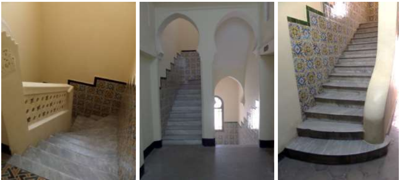
Fig. 142 – Cage d'escalier, médersa Thaalibia d'Alger Source : L'Auteur (2014)
