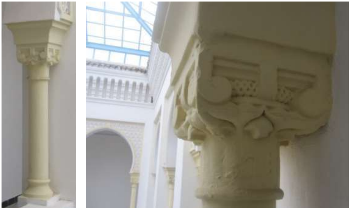
Fig. 169 – Chapiteau des colonnes de la médersa de Tlemcen Source : L'Auteur (2013)
