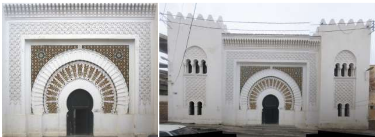
Fig. 157 – Photos montages de la façade principale, médersa de Tlemcen Source : L'Auteur (2013)
