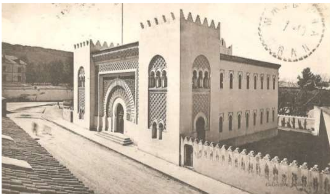
Fig. 154 – Vue extérieure, médersa de Tlemcen, Architecte : Henri Petit Source : www.delcampe.net (1906)
