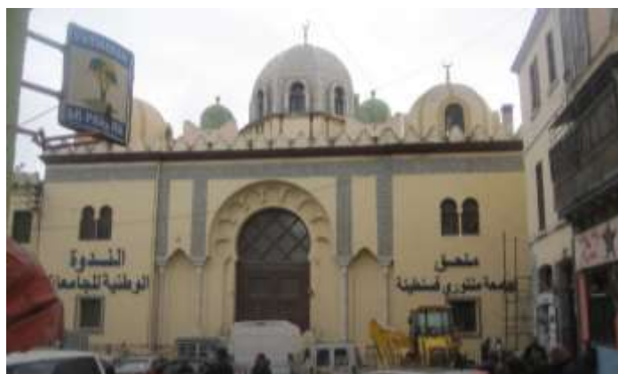
Fig. 185 – Façade Principale, médersa de Constantine Source : L'Auteur (2013)
