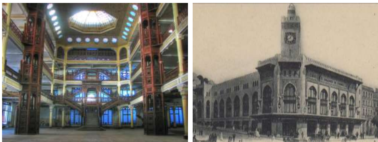
Fig. 76 – Photos intérieure et extérieure du MAMA, ex Galerie de France, 1914, Architecte : Henri Petit Source : www.mama-dz.com/media/images/static/historique1.jpg www.a136.idata.over-blog.com/498x425/0/51/13/38/vitrines/Galeries-de-France-Alger.jpg
