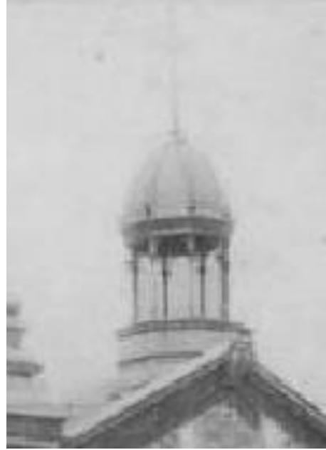
Fig63 : lanterneau, Source : google image
