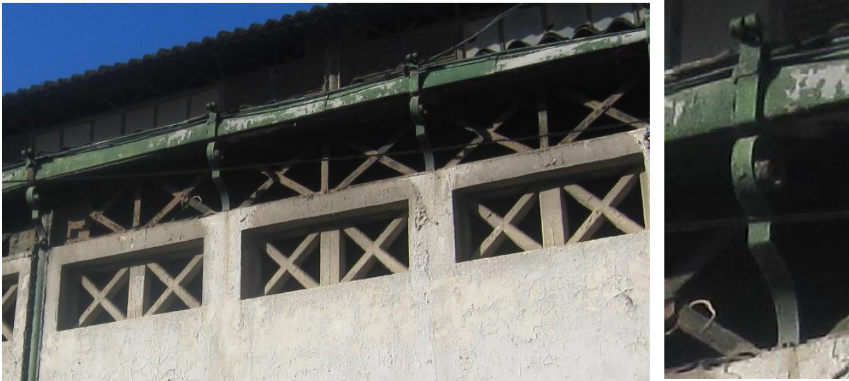
Fig 86 : Console permettant le support de la gouttière ; Source : auteur : 20/03/2017
