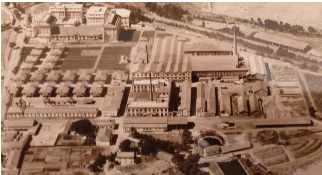
Fig33 : vue aérienne des usines Altairac ; Source : google image
