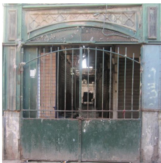
Fig62 : détail des frises losangées, Source : google image (modifiée par l'auteur).
