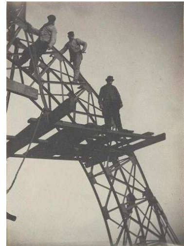
Fig24 : La Tour Eiffel. Trois ouvriers sur l'échafaudage d'une poutre en arc ; Source : Pinterest.
