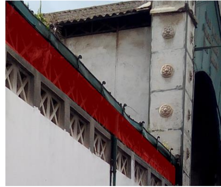
Fig84 : contreventement périphérique originel ;
