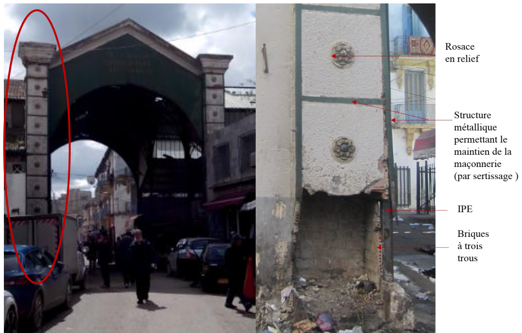
Fig52 : constitution des faux piliers ; Source : l'auteur ; prise : 12/03/2016
