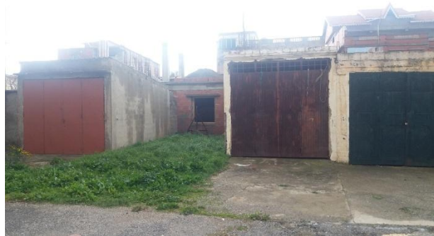
Figure 84: Clôture sud, Construction d'un mur en béton, accompagné d'un ensemble de garages marquant les limites avec les villas avoisinantes (Source : auteur)
