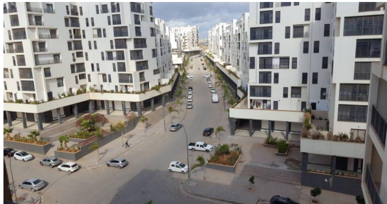
Figure 52 : Aperçu sur l'intérieur de la résidence
