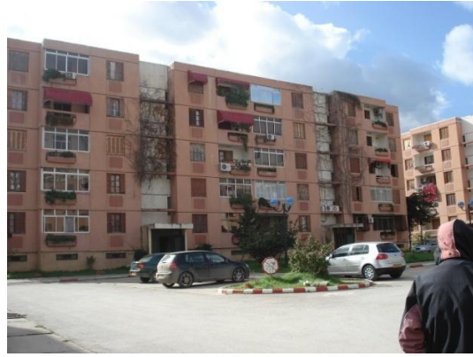
Figure 49 : Vue sur l'espace central de la résidence Mimosa, Annaba
