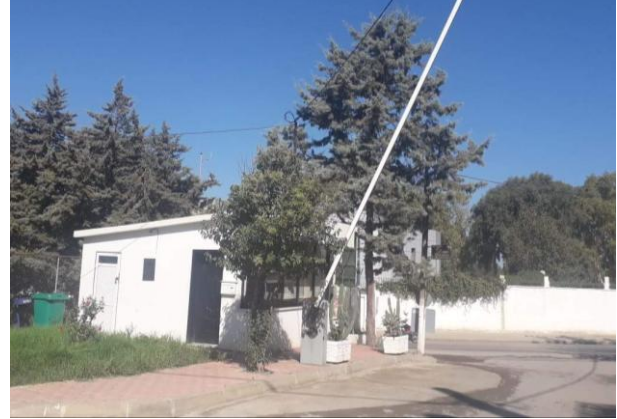
Figure 75: Vue de l'intérieur sur le Poste de garde avec une barrière de type passage à niveau (Source : auteur)
