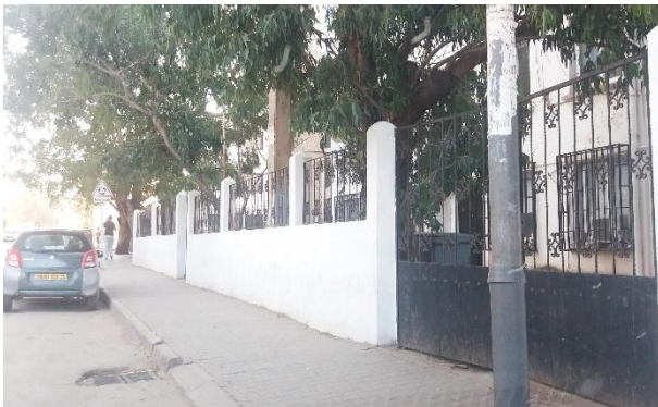
Figure 4 : Clôture de la résidence La bonne fontaine, Cheraga, Alger (Source : Auteur)
