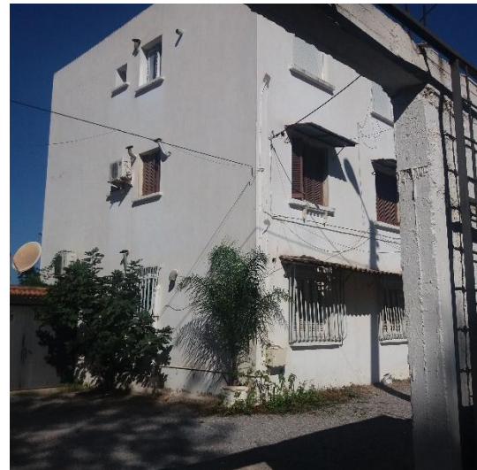
Figure 70: Vue sur l'un des deux immeubles de la résidence Cherradi (Source : auteur)
