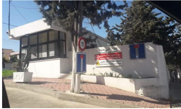
Figure 56: Poste de garde + caméra de surveillance à l'entrée de la résidence Radhi H'mida, Cheraga, Alger (Source : Auteur)
