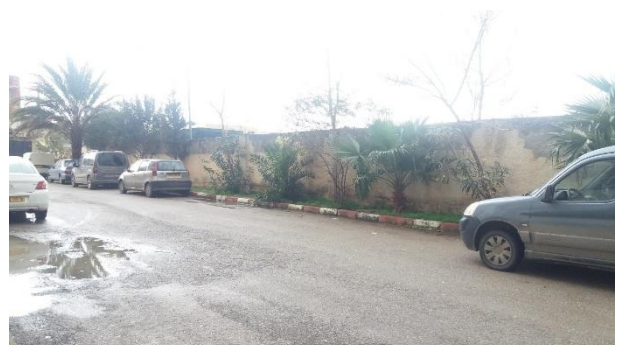
Figure 82: Clôture ouest, la Cité Nouvelle Bordj El Bahri (Le mur en béton qui a surgie par la suite) (Source : auteur)
