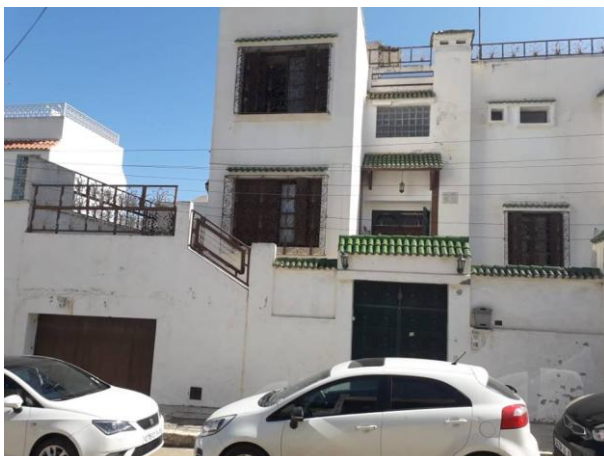
Figure 65: Villa type 02 de la résidence Rahdi H'mida (Source : auteur)
