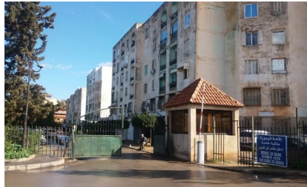
Figure 5 : la Clôture de la résidence les Mimosas ( poste de garde avec portail à l'entrée), Staouali, Alger (Source : Auteur)
