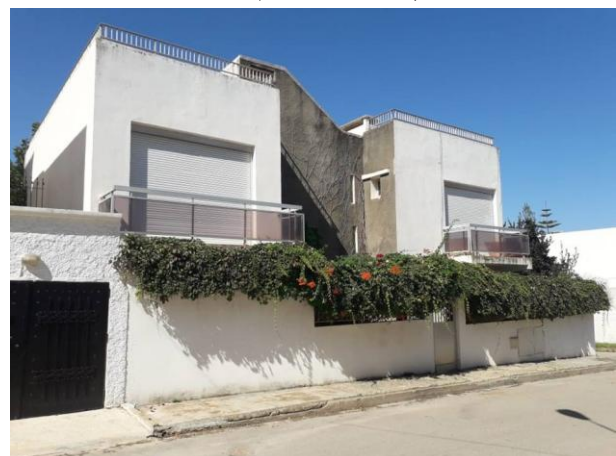
Figure 66: Villa type 03 de la résidence Rahdi H'mida (Source : auteur)
