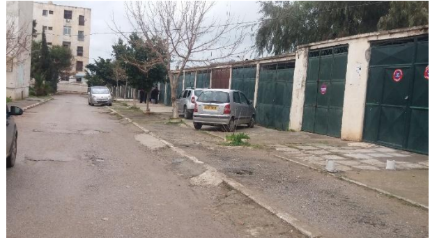
Figure 80: Clôture nord, par l'établissement de garages, la Cité Nouvelle Bordj El Bahri (Source : auteur)
