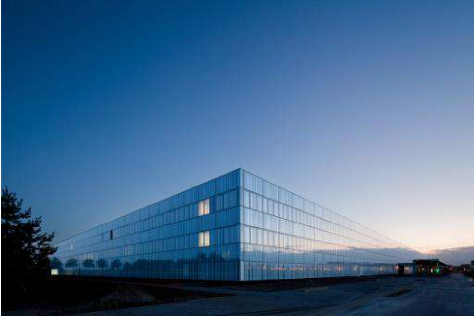
Figure 25 : Centre hospitalier de Marne-la-Vallée.
