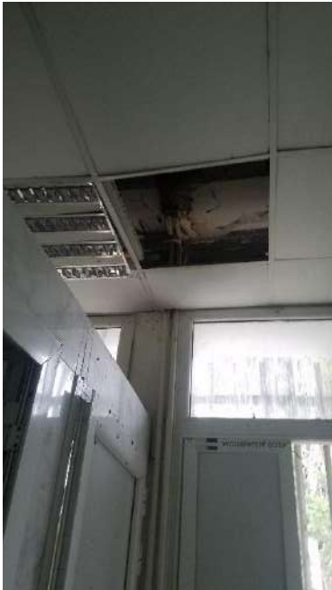
Figure 71 : Vue sur le faux plafond au niveau des sanitaire Source : Auteur (prise le 07/01/2020)
