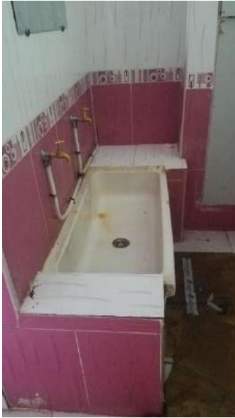
Figure 75 : Photo du sanitaire du service Source : Auteur (prise le 07-01-2020)
