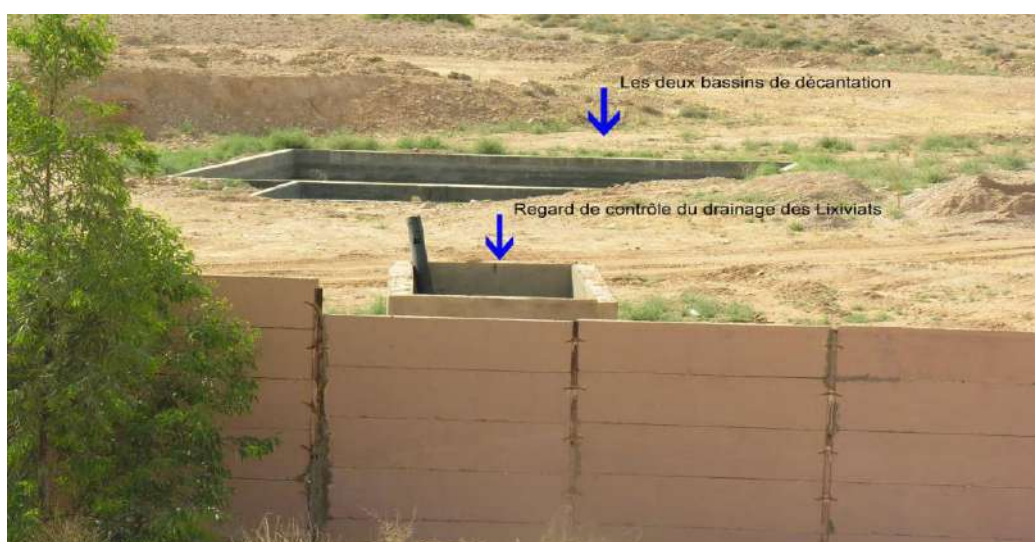
Figure 40 : Regard de contrôle du drainage des lixiviats et les deux bassins de décantation CET d'El.Outaya
