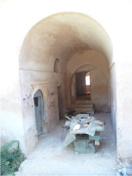
Figure 36 : Entrée n°1, porche d'entrée (espace F.S.021)
