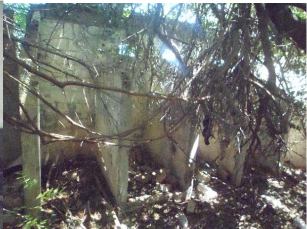
Figure 81: Sanitaire de la mosquée
