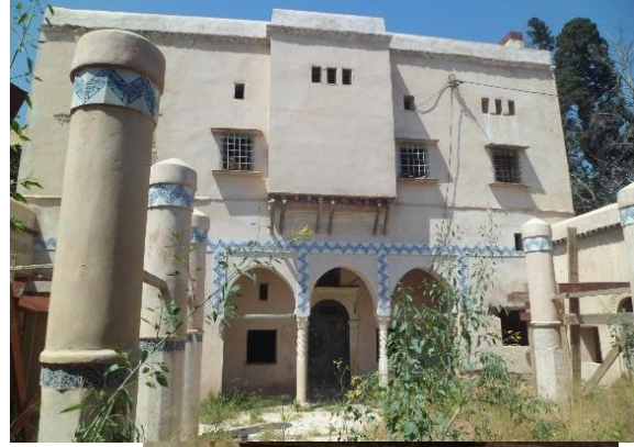
Figure 43: Villa A, façade intérieur NORD, kbou sur encorbellement
