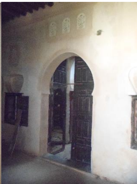
Figure 49: Porte d'entrée à une pièce depuis le patio, avec arc brisé surmontée de trois claustras et avec des niches de part et d'autre.
