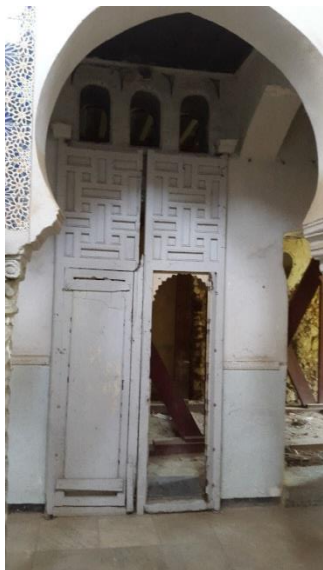
Figure 75: Porte pour les pies de services au-dessous des escaliers
