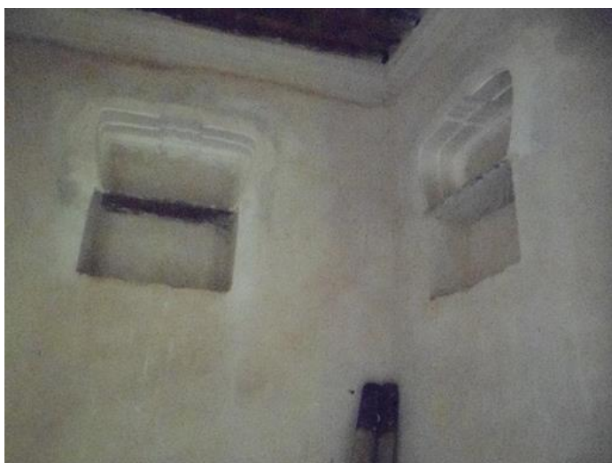
Figure 50: Des niches hautes dans une pièce d'habitation
