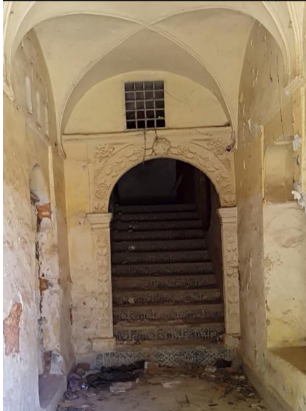
Figure 66: Escalier principal de la villa B (I.S.001) précédé par une squifa sou voute croisée (G.S.001)
