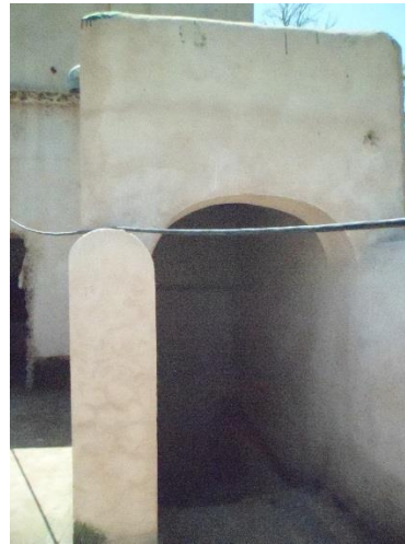
Figure 53: Accès vers la 1ère terrasse accessible (T.O.002)
