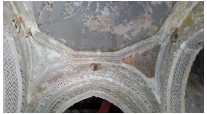
Figure 72: Coupole à huit pans à pendentif (trompe) repose sur des arcades
