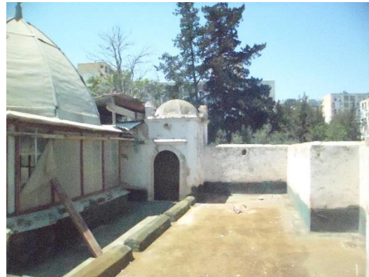
Figure 55: la terrasse accessible de la villa A, (T.S.001)
