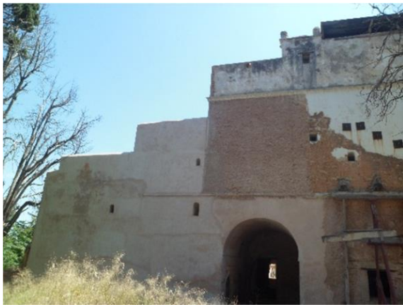
Figure 34: Entrée n°1, façade Sud
