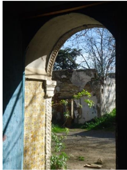
Figure 64: Porte d'entrée (accès n°33)
