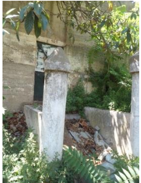
Figure 20: Accès piéton à villas Mahieddine (Est)
