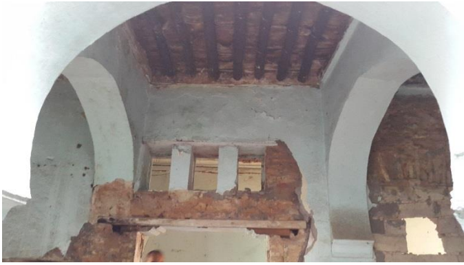
Figure 71: Villa C, plafond en rondins, porte surmenée de 3 petites ouvertures
