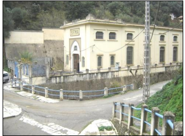
Figure 37 : Le bâtiment du S.F.M.A de l'extérieur
