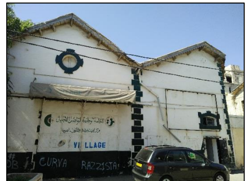
Figure 89 : traitement d'angle et de toiture du bloc 2 côté nord Source : Auteur
