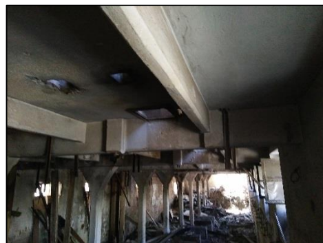
Figure 99 : vue sur l'entre sol du bloc 1 Source : Auteur
