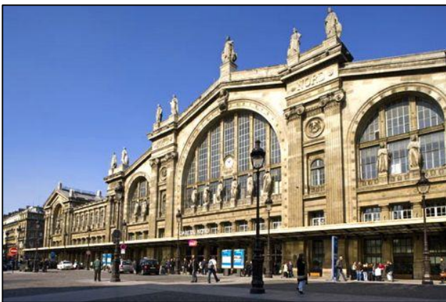
Figure 5 : gare du Nord, Paris Source : http://www.plaza-opera-paris.com/plusinfos/hotel-proche-gare-du-nord.html
