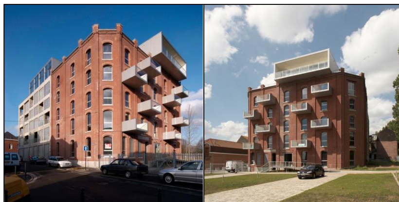
Figure 20 : réhabilitation de l'ancienne minoterie Tank de Roubaix en logement
