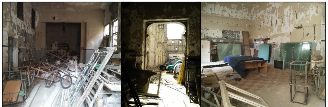
Figure 135 : vues à l'intérieur de la partie usine du bloc 8 Source : Auteur
