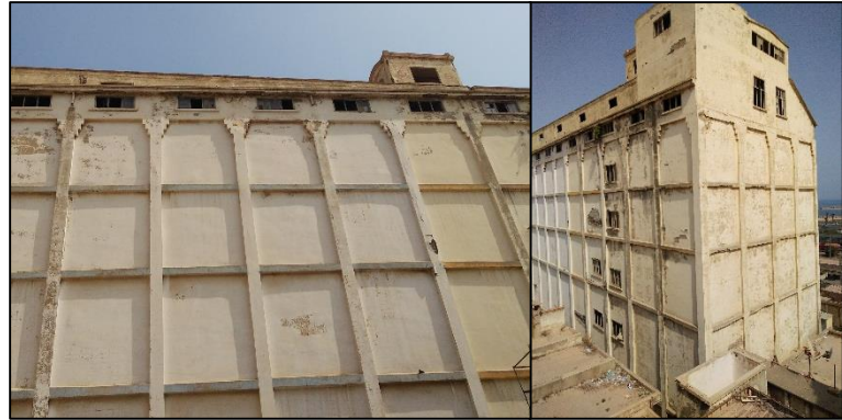
Figure 93 : traitement des façades du bloc 9 Source : Auteur
