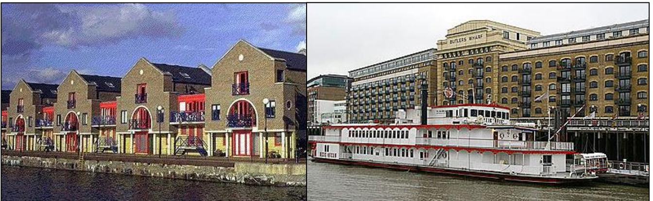
Figure 16 : réhabilitation des Royal Docks de Londres en logements
