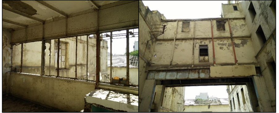
Figure 103 : passerelles reliant le bloc 1 au bloc 4 Source : Auteur
