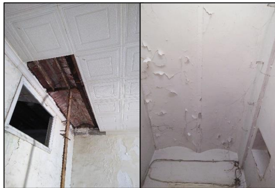
Figure 143 : planchers à voutains au niveau du bâtiment des impôts
