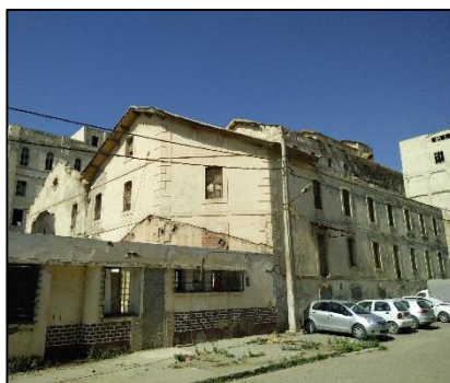
Figure 81 : état externe du bloc 4 côté nord
