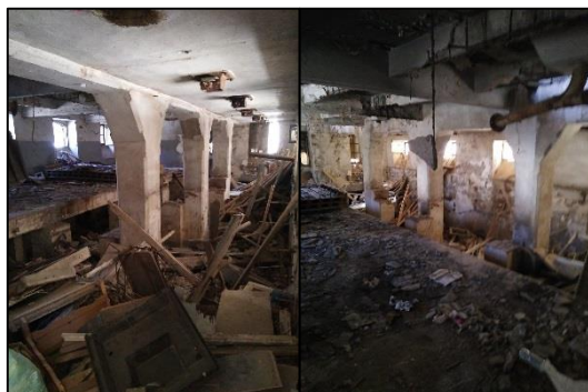
Figure 98 : vue sur le RDC du bloc 1 Source : Auteur
