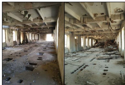
Figure 101 : anciennes salle des machines du bloc 1 Source : Auteur
