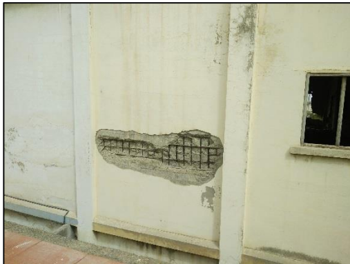
Figure 84 : structure en béton armé
