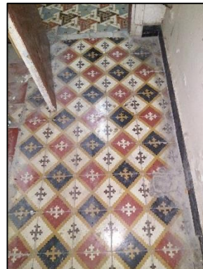
Figure 159 : revêtement à base de losanges Source : Auteur
