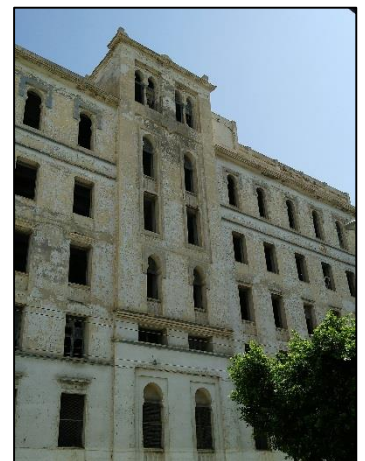
Figure 107 : façade sud de la minoterie Source : Auteur
