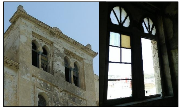
Figure 110 : ouvertures jumelées au niveau du couronnement du corps central Source : Auteur
