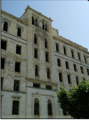
Figure 123 : ouverture de la façade sud du bloc 1 Source : Auteur
