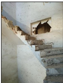
Figure 97 : cage d'escalier bloc 1 Source : Auteur
