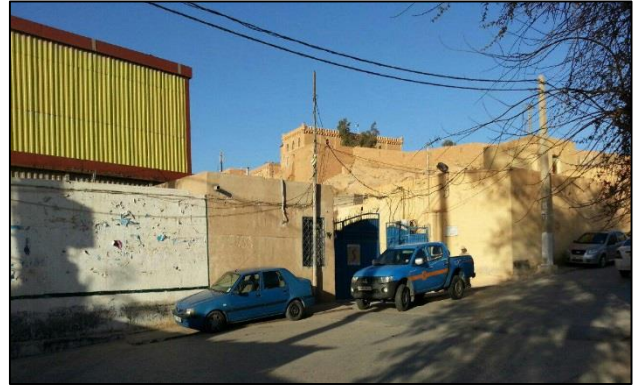
Figure 30 : vue extérieure sur la centrale Diesel de Laghouat Source : Auteur
