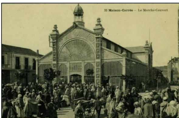
Figure 51 : le marché couvert de maison carrée en 1919
