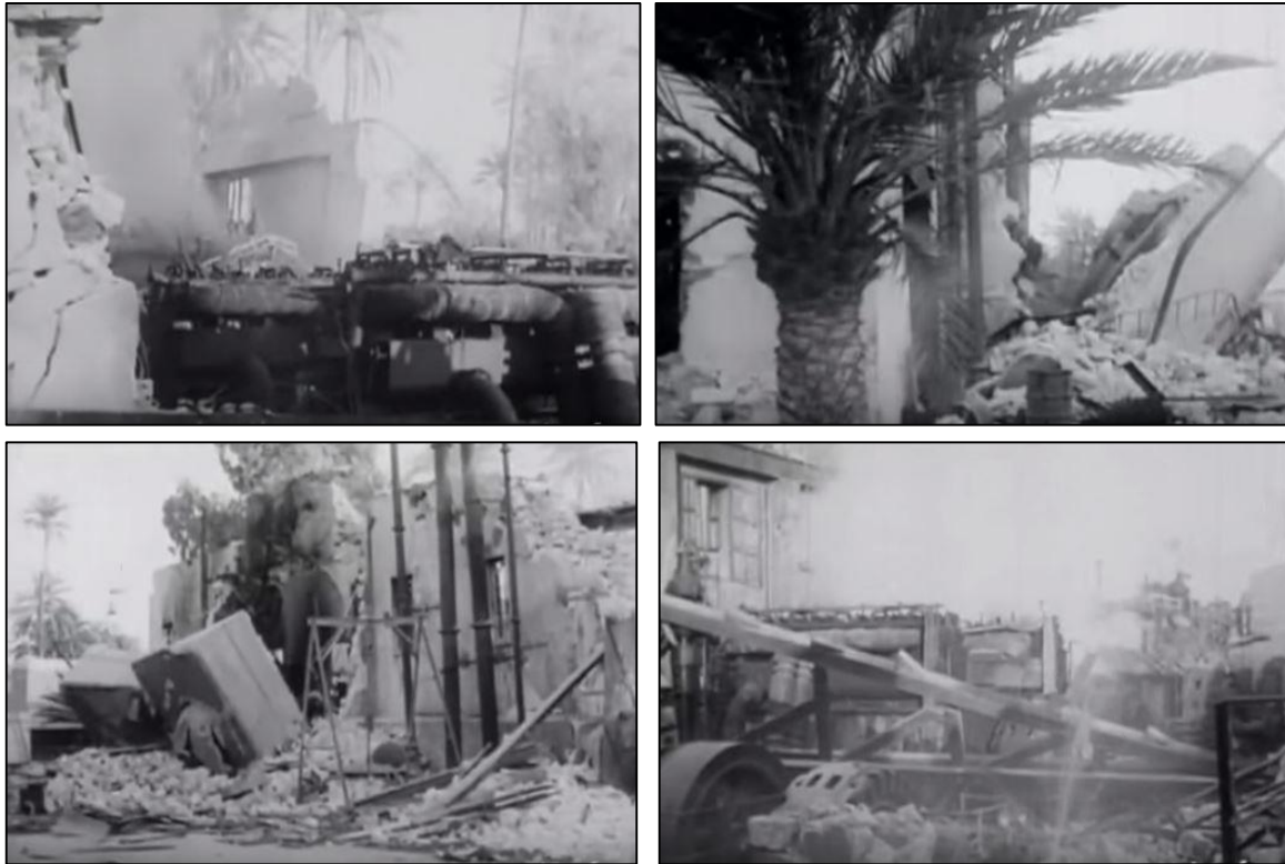
Figure 29 : état de la centrale après l'attaque de l'ALN en 1957
