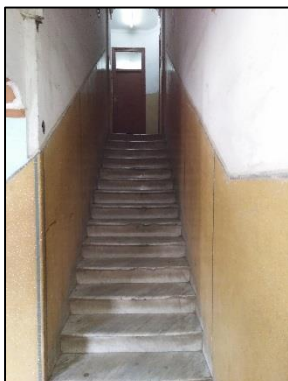
Figure 132 : cage d'escalier de la partie 2 Source : Auteur
