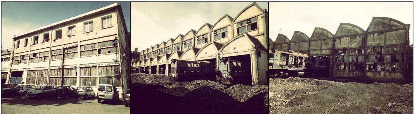
Figure 50 : état actuel des ateliers
