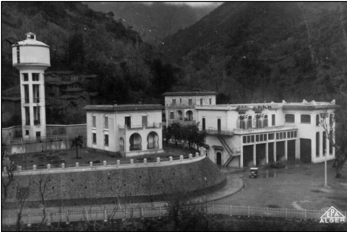
Figure 36 : Vue d'ensemble sur les habitations de la centrale, le poste de distribution et le château d'eau.
