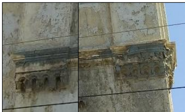
Figure 127 : traitement de façade en muqarnas Source : Auteur
