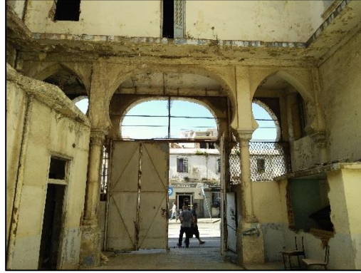
Figure 124 : traitement du porche d'entrée, vue de l'intérieur Source : Auteur
