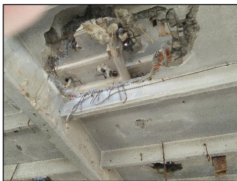
Figure 118 : plancher nervuré Source : Auteur
