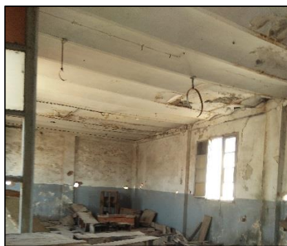
Figure 119 : plancher a voûtain Source : Auteur
