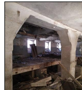
Figure 117 : point porteur du RDC Source : Auteur
