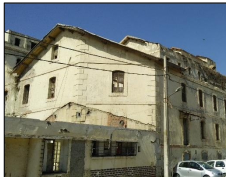
Figure 88 : traitement d'angle au niveau du bloc 4 côté nord Source : Auteur
