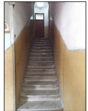
Figure 144 : escaliers du bloc 8
