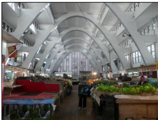
Figure 56 : vue intérieur sur la structure en béton du marché de Michelet
