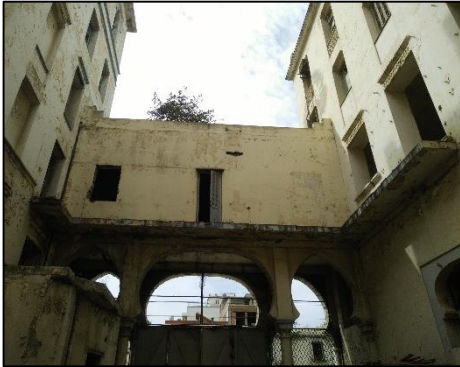
Figure 102 : passerelle reliant le bloc 1 au bloc 8 Source : Auteur
