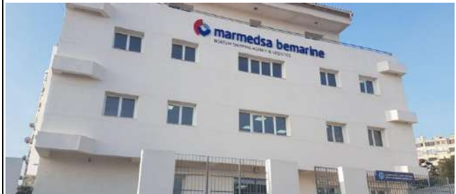
(b) Nouveaux bureaux d'une entreprise à Alger, construits en 2017. Absence des critères esthétiques sur la façade. Monotonie et pauvreté en éléments et en relations. Source : https://www.noatum.com/fr/marmedsa-bemarkine-nueva-oficina-argel/
