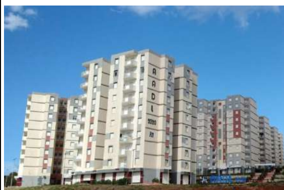
(e) Cité des logements AADL achevée en 2020. La construction en masse abolit la recherche esthétique. Source : https://www.radioalgerie.dz/ consulté le 28/11/2020
