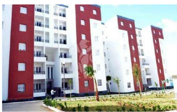
(f) Cité des logements AADL achevée en 2020. La façade est composée d'un étage qui se répète du RDC jusqu'à la terrasse. La couleur n'est pas suffisante pour palier la monotonie. Source : https://www.aps.dz/ , consulté le : 26/11/2020
