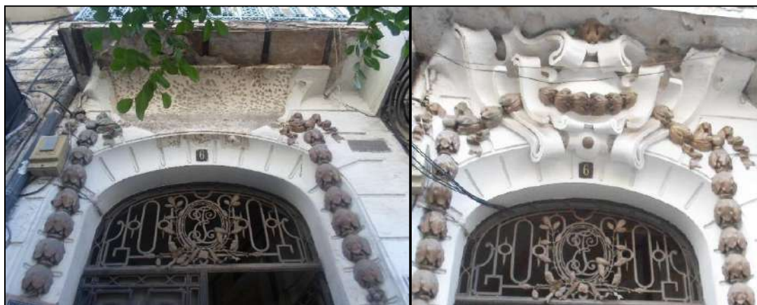
Fig. VIII.6. Ornement perdu, esthétique tronquée. Photos du portail de l'immeuble N°06 prises le 25-10-2017 (à gauche) et le 13-10-2012 (à droite). Source : l'auteure.
