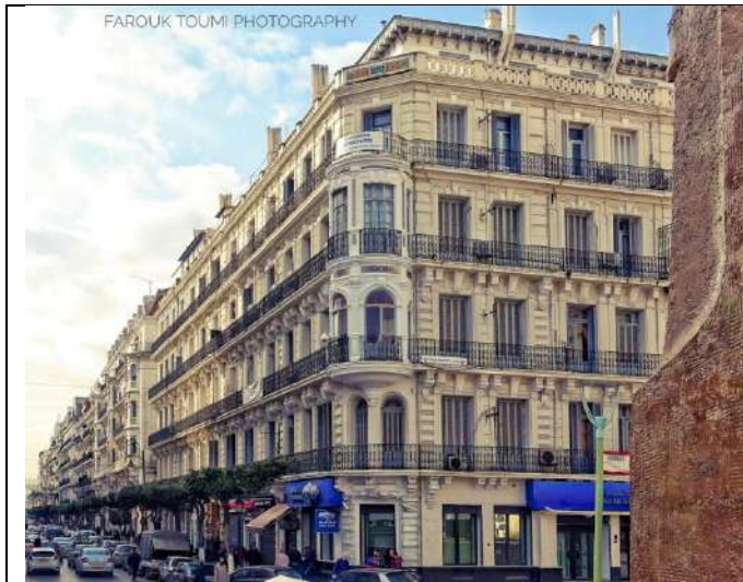
(e) Vue sur l'immeuble N°37 à partir de la place Émir Abdelkader. Source : Farouk Toumi Photography, 2020
