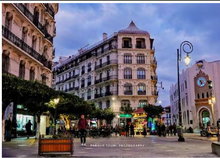
(a) Vue sur la limite sud de la rue Ben M'hidi. L'immeuble N°64 vue de la place de la Grande Poste. Source : Farouk Toumi Photography, 2020
