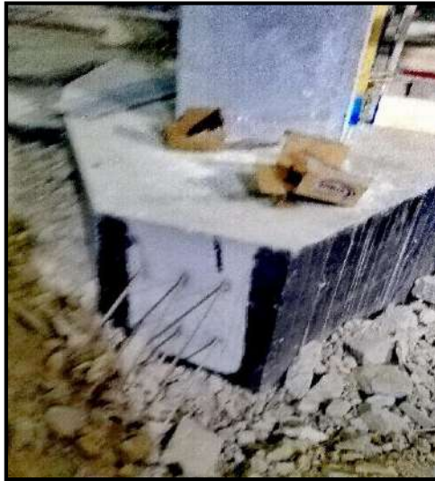
Figure 21 : Aciers en attente pour la réalisation d'une longrine Source : Auteur
