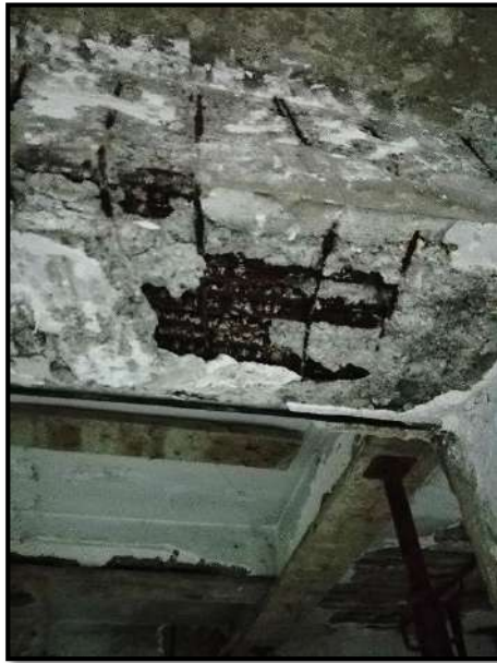
Figure 28 : Exemple du ferrailage d'une poutre au 3 ème étage Source : Auteur
