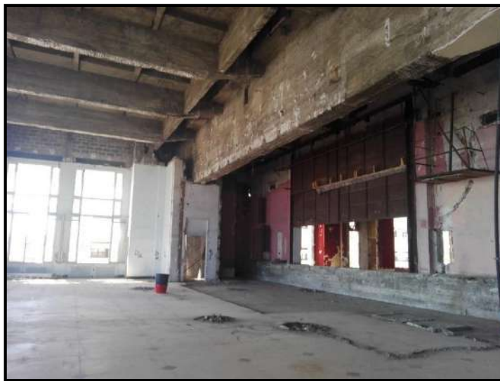
Figure 29 : Retombée d'une poutre au 1 er étage Source : Auteur
