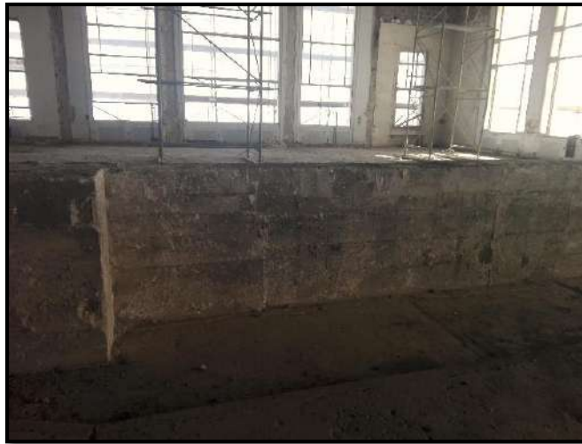
Figure 26 : La poutre renversée de la salle d'El Mouggar
