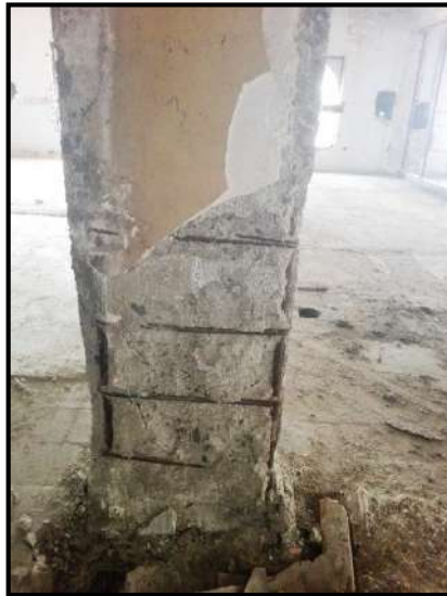
Figure 25 : Espacement des cadres dans un poteau du 1 er étage Source : Auteur
