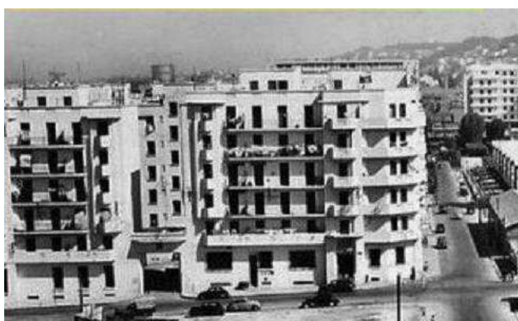
Figure 90: Le groupe HBM G1 : vue sur entrée 8
