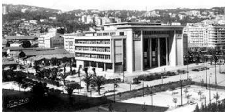
Figure 86 : Le foyer civique 3
