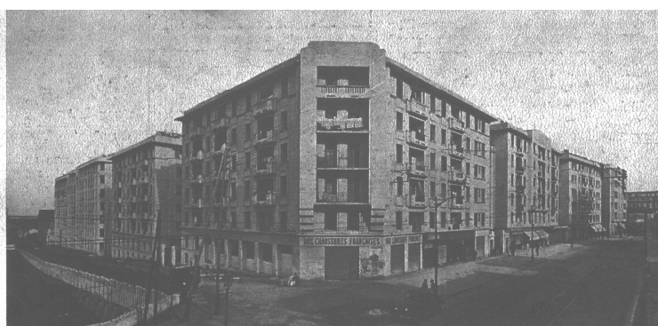
Figure 57: La cité HBM du Ruisseau vue d'ensemble 15
