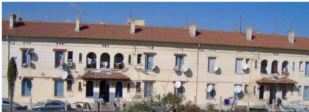
Figure 60: Vue d'ensemble des accès aux logements (photo auteur)
