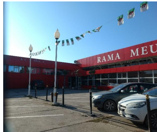
Figure 53: Vue extérieure de la GSS Rama Meuble
