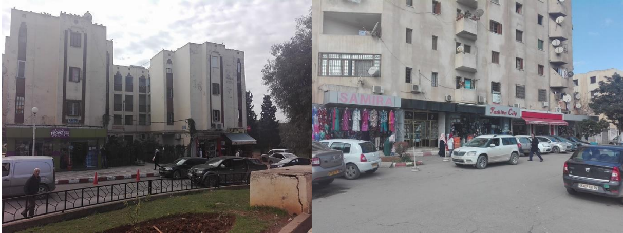
Figure 47: Linéaire commercial au centre-ville d'El-Mohammadia : quartier de cinq maisons
