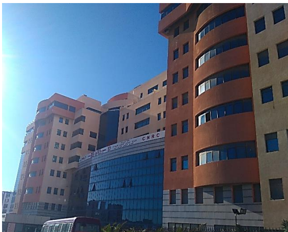
Figure 50: Le centre commercial et d'affaires Mohammadia mall vu depuis le CNRC
