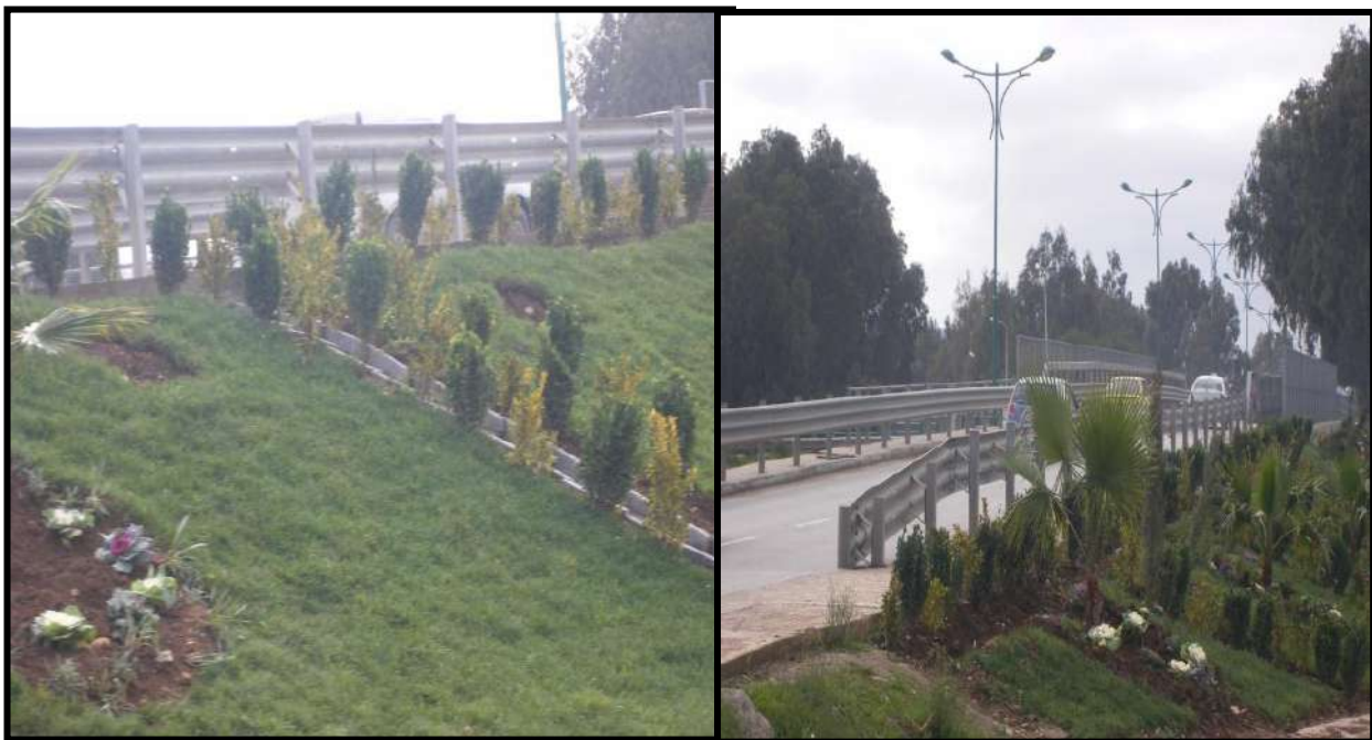
Figure N° 156 : l'embellissement du passage du tracé du tramway
