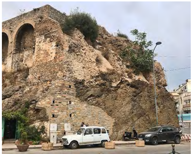
Fig.19- Vestige du mur de rempart de 1830, sur son «socle taillé». (Auteur)
