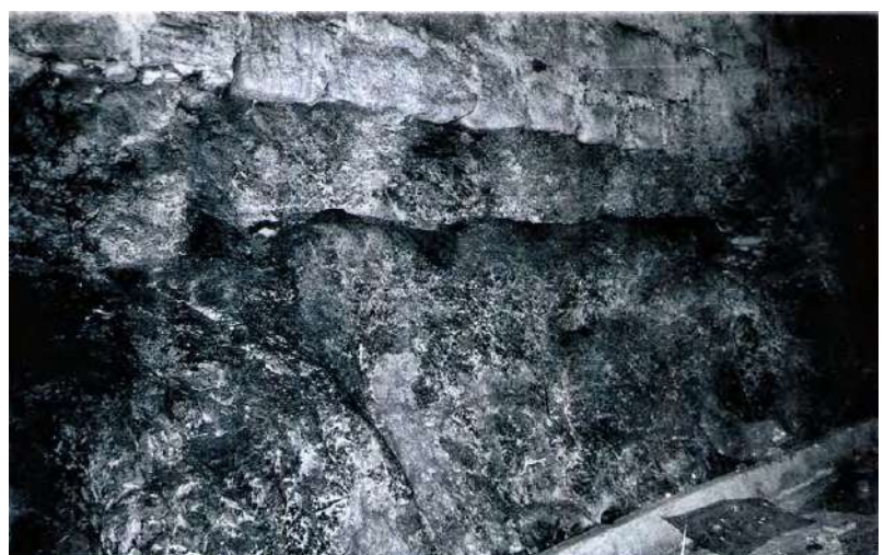
Fig.111- Le mur de rempart et le «grand rocher brun». (Chergui 2011:44)
