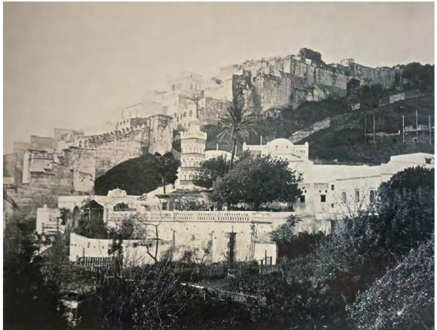
Fig.39- Le mausolée de Sidi Abderrahmane au pied du mur de rempart Nord de 1930. (Paul Marès, ca 1860)
