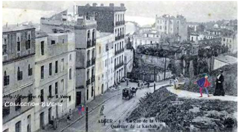
Fig.20- Vue en surplomb du boulevard de la Victoire et du bastion de Bab el-Djedid. ( http://alger-roi.fr )
