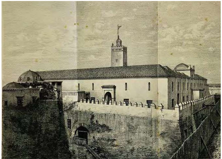
Fig.183- Le passage derrière l'actuelle Grande Mosquée. («La Grande Mosquée», in. Devoulx 1875(19):522-523)
