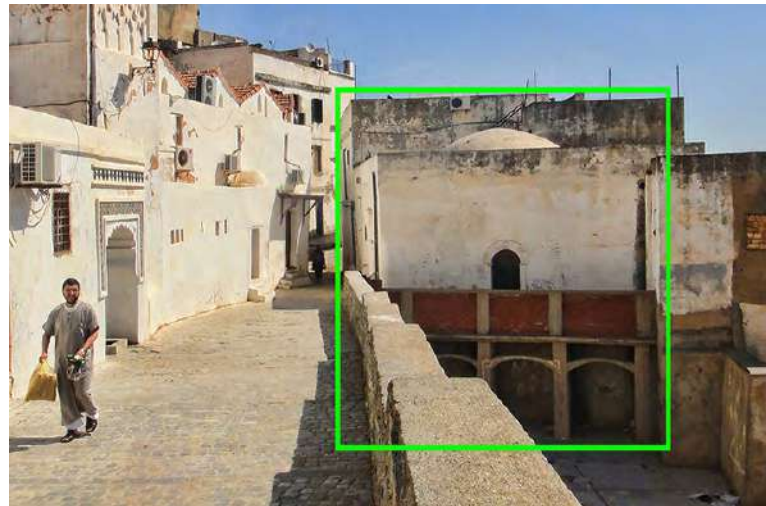
Fig.122- L'impasse-passerelle du hammam de Sidi Ramdhane. (Auteur)
