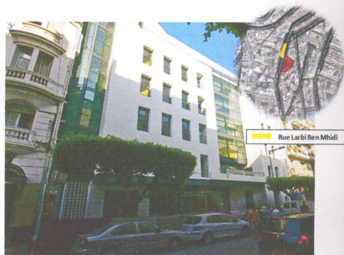
Figure 32 : Centre culturel « L'historial » vue extérieure et accessibilité Source : Prise personnelle
