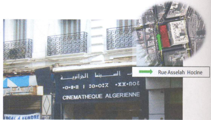
Figure 28 : Cinémathèque Algérienne vue extérieure et accessibilité
