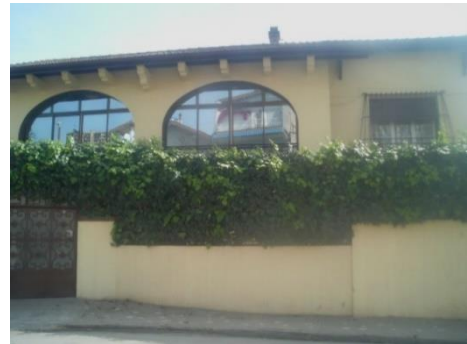
Figure 31 : maisons individuelle, type villa R+1, (source : auteur)
