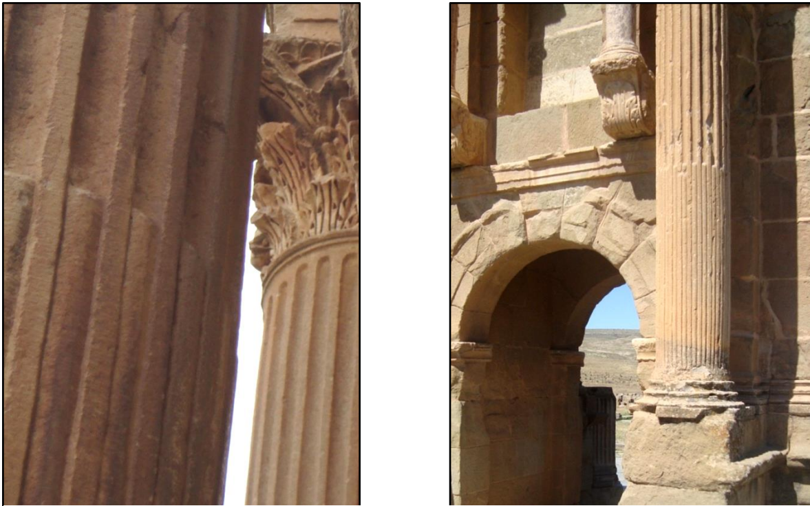
Figure 77: recours à l'augmentation du nombre de cannelures dans la partie basse des colonnes afin de corriger l'effet de bombement de celles-ci.
