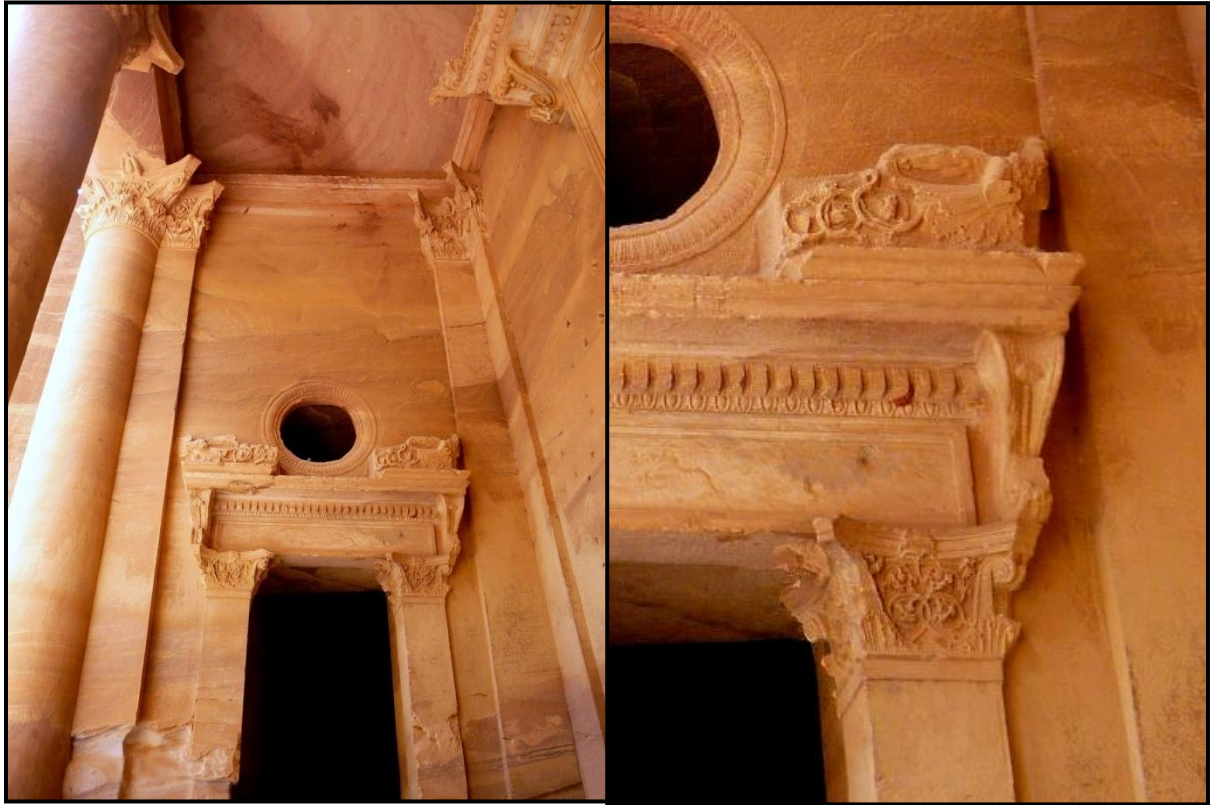
Figure 60: Consoles supportant une corniche, porte latérale du Khazneh à Petra, Jordanie. Source: http://www.sabyplanete.com/article-32869152.html
