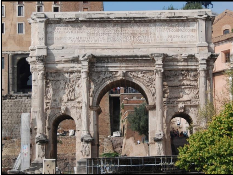
Figure 8: Arc de Sévère à Rome. Source : http://www.claude.dupras.com/photos7.htm [Consulté le 12 Novembre 2015].
