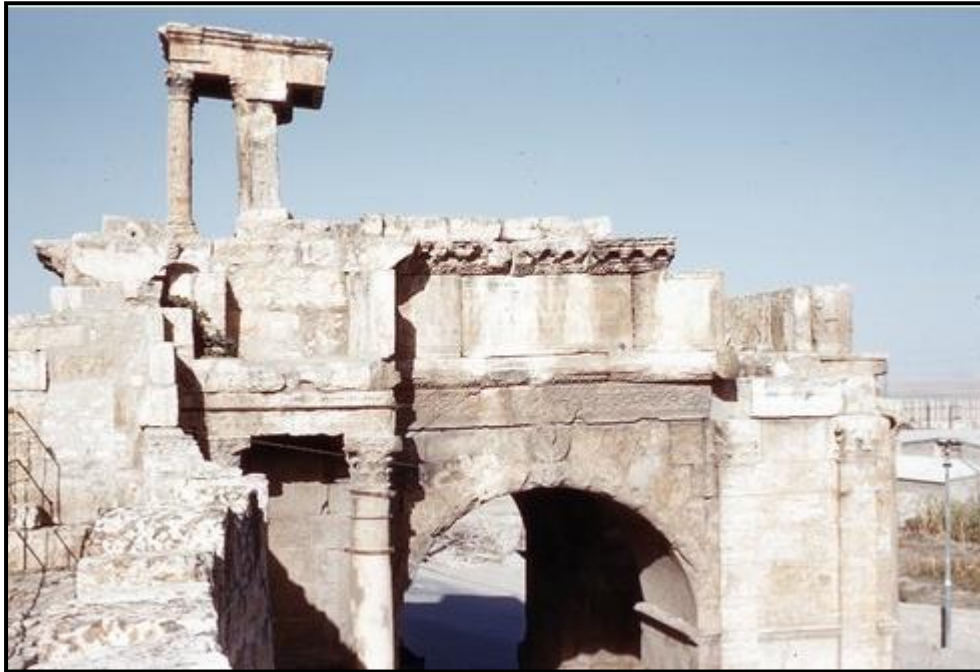
Figure 61: édicule, arc de Caracalla à Tébessa.
