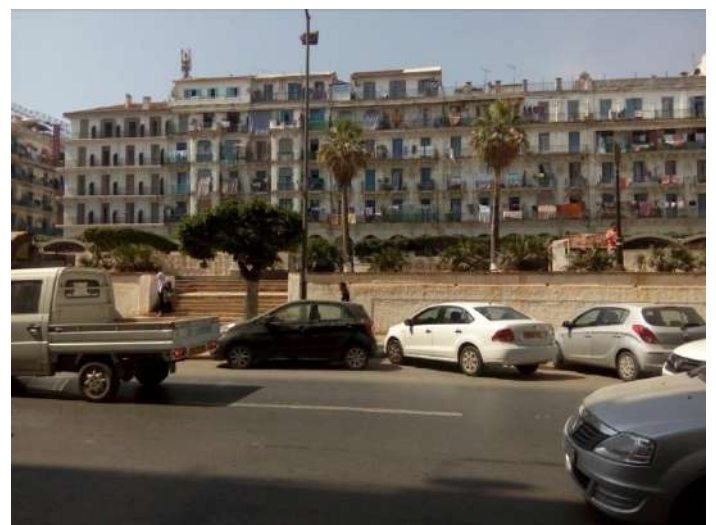
Typologie architecturale néoclassiquetype immeuble de rapport du 19 ème siècle, de la place Stambouli
