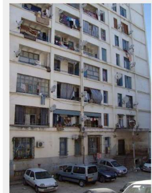
Fig. 119 Vue sur le bâtiment N°08. Dégradations liées à l'aspect extérieur des bâtiments. Sr : auteur
