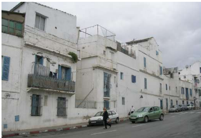
Fig. (87.).Vue la typologie du bâti sur la rampe AREZKI LOUNI
