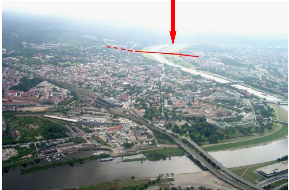
Fig. (07) : Vue sur le tracé du projet du nouveau pont perturbant le paysage urbain du côté Est de la ville .Sr : http ://.culturevisuelle.org/territoire/483
