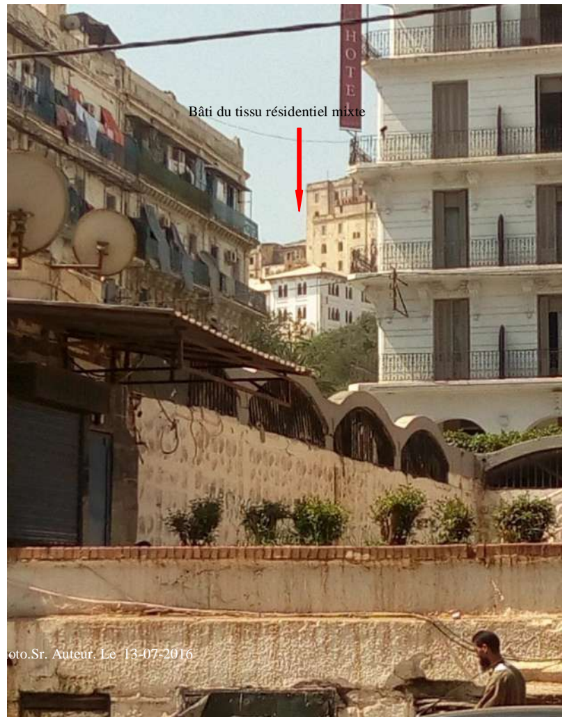
Fig. (108). PERSPECTIVE VISUELLE V12 : Place Stambouli (Nelson). * Type de perspective : De moyen intérêt .
