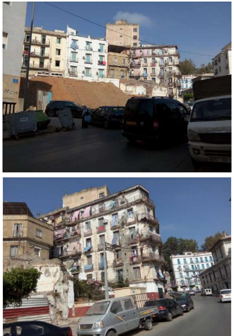
Fig. (122) Etat de dégradation avancée du cadre bâti dans la zone sud-ouest Quartier Bellili. Sr : auteur
