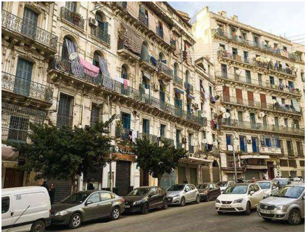
Fig. (123) Cadre bâti en bonne état de conservation dans la zone sud-ouest. Vue sur la Rue Abane Remdane Sr : auteur
