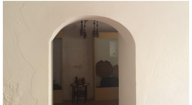
Figure 36 : photo de l'arc d'une entrée d'un local /source : l'auteur
