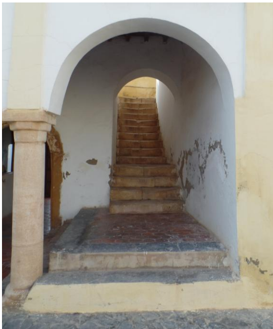
Figure 31 : photo de l'escalier du fort, source : auteur
