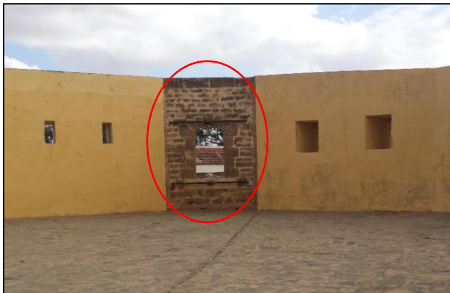
Figure 73 : ouverture d'origine de la terrasse /source Auteur
