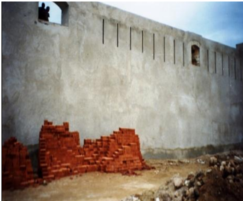
Figure 65 : 7 photo de Séchage de l'enduit du mur extérieur photo prise par le bureau d'étude ARTEC
