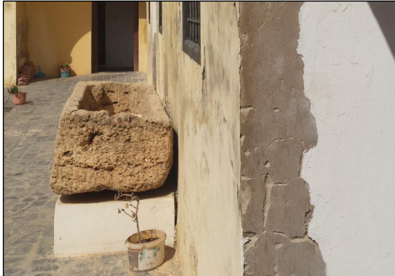
Figure 69 : mur intérieur tapissé par le ciment source : Auteur
