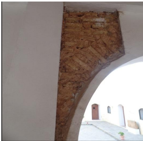
Figure 75 : appareillage des pierres de l'époque ottomane /source : Auteur
