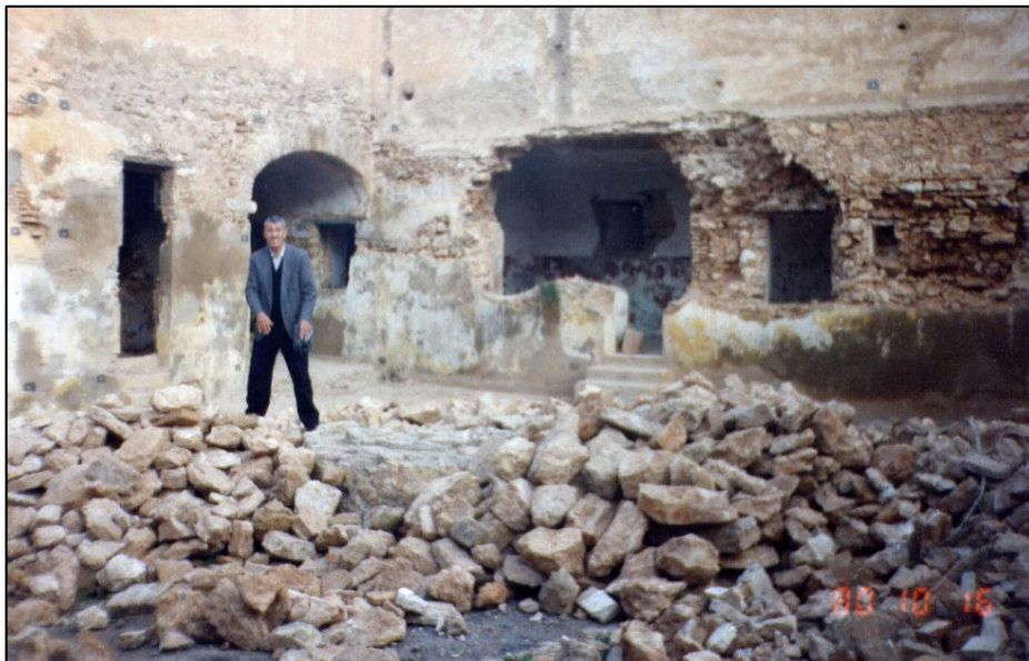
Figure 56 : Dépose et séchage de pierre pour réutilisation / source : photo prise par le bureau d'étude ARTEC
