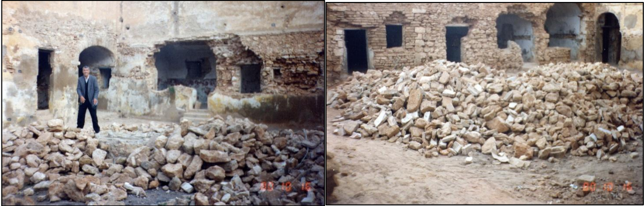
Figure 53 : photos de l'état initial de l'intérieur du fort, mur intérieur détruit Source : Photo prise par le bureau d'étude ARTEC
