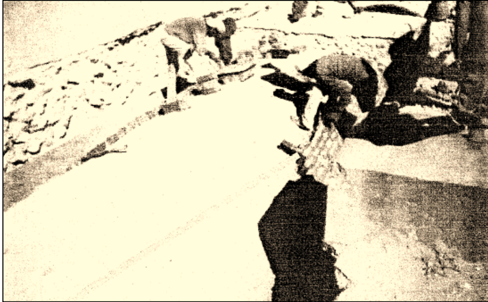
Figure 60 : couverture de la voute avec de la brique pleine, photo prise par le bureau d'étude ARTEC
