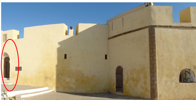
Figure 25 : L'entrée principale du fort source : l'auteur
