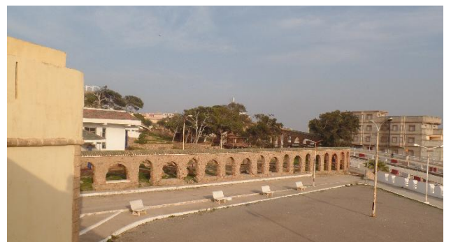
Figure 26 : photo de clôture entre le parc et le fort /source : Auteur
