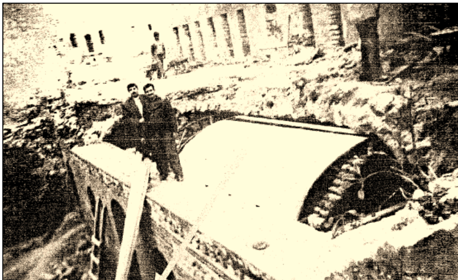
Figure 59 : Reconstruction de la voute photo prise par le bureau d'étude ARTEC
