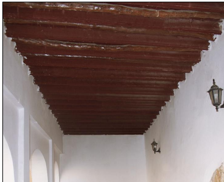
Figure 61 : 5planché en bois et rondins achevé ; photo prise par l'auteur du mémoire
