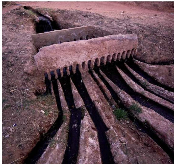
Figure 22: Système en peigne pour le partage de l'eau au niveau d'une foggara à Timimoun. Photos : Adolphe L. (2011).
