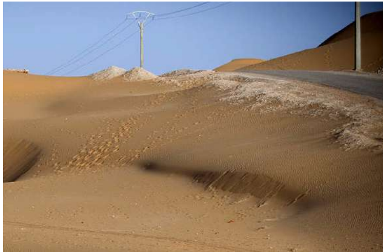
Figure 113: tas de remblais localisés au niveau de la route reliant Timimoun à Talmine (70 km à l'ouest de Timimoun). Photo Auteur, 2012
