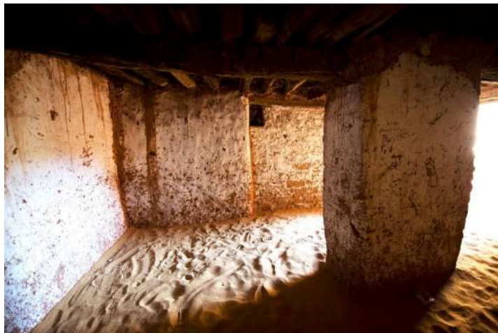
Figure 27: Vue sur l'intérieur d'une maison à piliers au ksar de Tasfaout. Photo Adolphe L., 2011.
