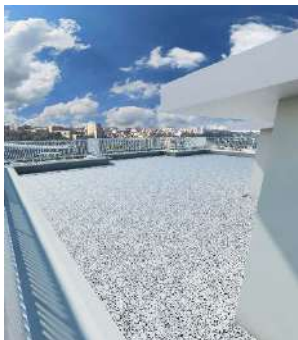
Figure 178 : Le revêtement par du granito pour la terrasse
