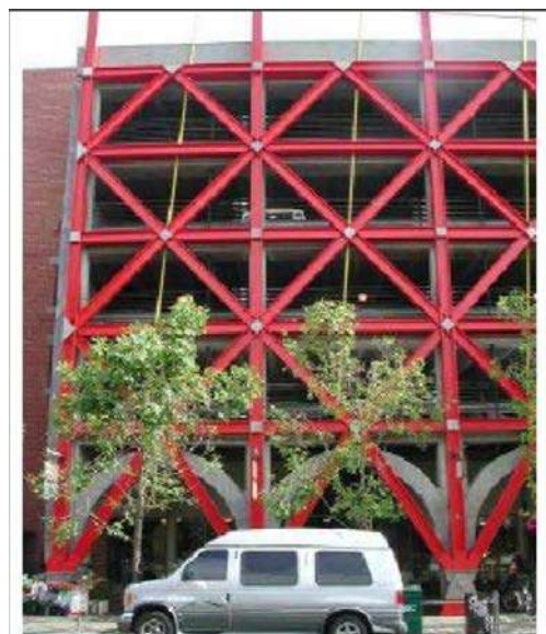
Figure 65 : Ajout de Palée de contreventement Source : (ATTARI, 2013)
