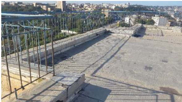
Figure 179 : l’étanchéité qui couvre le revêtement Photo prise décembre 2015
