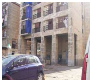
Figure 149 : système en portique
