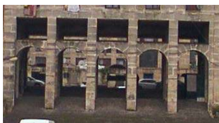
Figure 150 : des poteaux avec des arcs Photo prise décembre 2015
