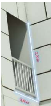
Figure 199 : porte fenêtre du séjour
