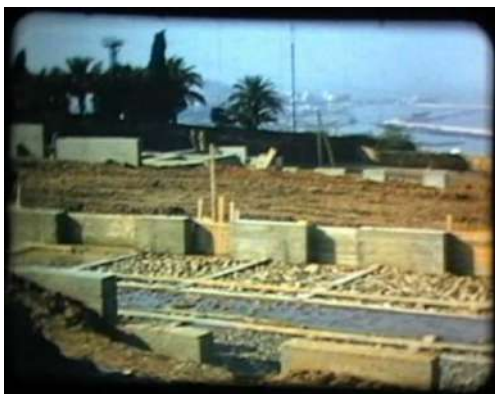
Figure 215 : vue sur les fondations source : (Stéphane Gruet, 1953)
