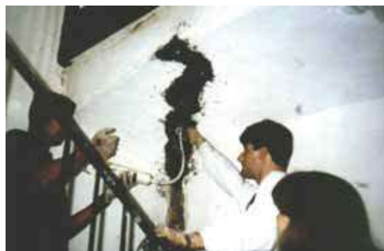
Figure 48 : la technique d'injection Source : (Xavier CASANOVAS, 2007)
