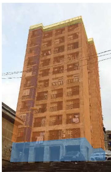
Figure 195 : façade Nord- Est Photo prise décembre 2015
