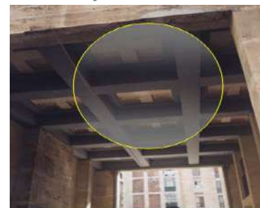
Figure 148 : les planchers à armature croisés
