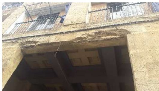
Figure 152 : poutre en béton armé Photo prise décembre 2015
