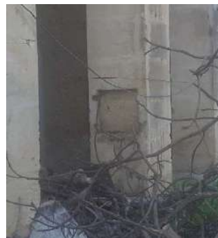
Figure 219 : Des cloisons en briques et le mur périphérique en pierre source : (Stéphane Gruet, 1953)
