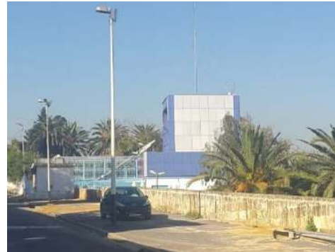
Figure 140 : recouvrement du locale de la téléphérique par de l'allicouband (20) Photo prise décembre 2015
