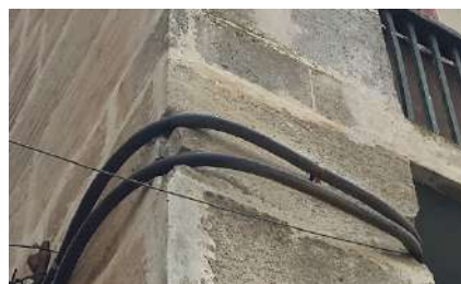
Figure 262 : risque de chute d'une pierre a couse du câble d'électricité (pierre et joint endommagés) Photo prise décembre 2015
