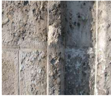
Figure 37 : La pollution entraîne avec le temps la production d'une couche noirâtre (Le sulfin) qui bouche les pores des pierres et l'empêche de respirer. Source : (JB Blom, Caroline Fogliani & DAC, Avril 2009)
