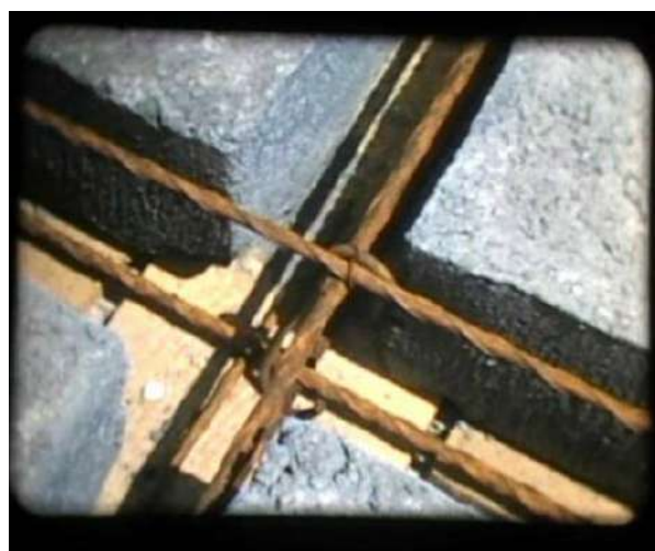
Figure 234 : le ferrailage entre les marmites Source : (Stéphane Gruet, 1953)
