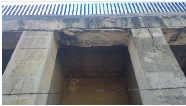
Figure123 : Poutre pour l'espace extérieur(7) Photo prise décembre 2015
