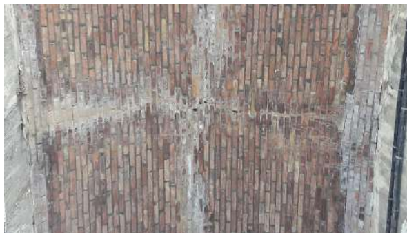
Figure 115: fissure au niveau de la voute en berceau (1) photo prise décembre 2015
