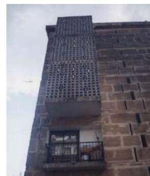
Figure 147 : la construction en maçonnerie de pierre
