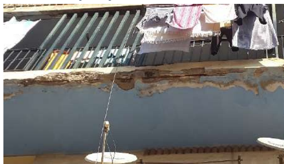
Figure 119 : des brises de soleilles en état dégradé (4). Photo prise décembre 2015
