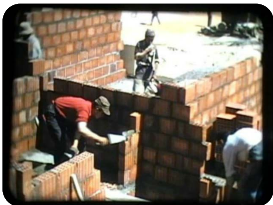
Figure 218 : Des cloisons en briques source : (Stéphane Gruet, 1953)
