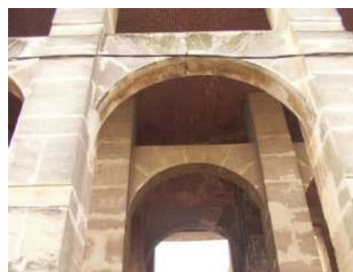
Figure 153 : des arcs en pierre Photo prise décembre 2015
