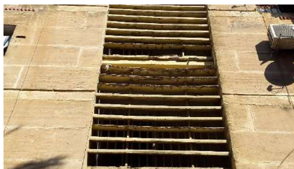
Figure 121 : dégradation qui touche le bas du plancher plain en béton armé (l'apparition de l'acier) (4) Photo prise décembre 2015
