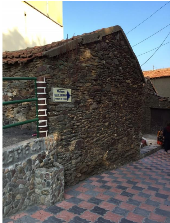
Figure 36 maison avec mur en pierre, village Boumessoud, (source : auteur).
