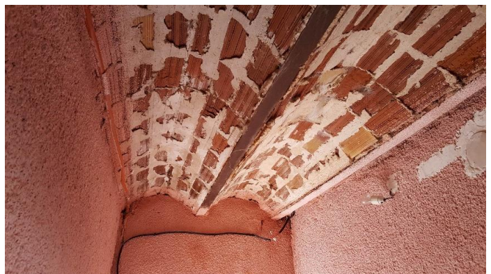
Figure 43 Photo du plancher en voutain de briques pleines du premier niveau de notre cas d'étude (source : auteur).
