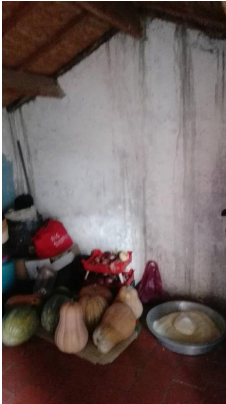
Figure 80: Vue intérieure de la chambre de stockage (source auteur)
