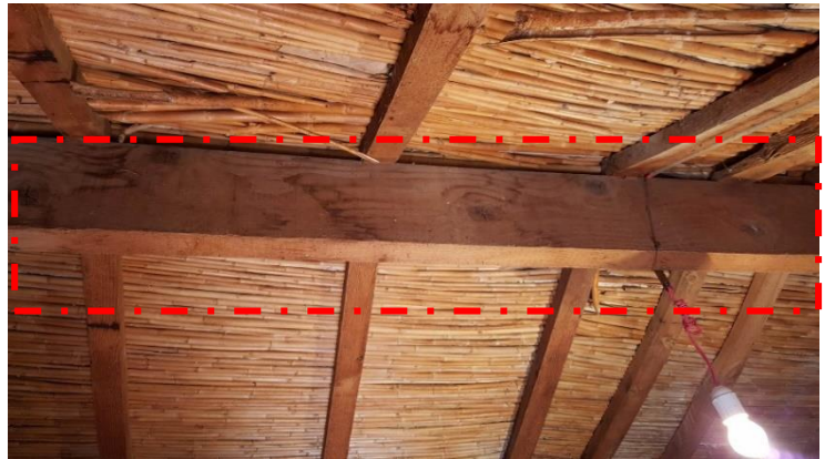
Figure 62: Photo représentant la Charpente en bois dans la pièce des provisions, (source : auteur)
