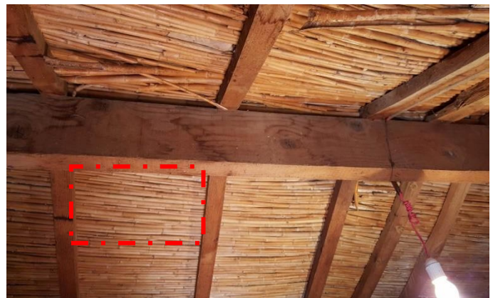
Figure 64: : Photo représentant les roseaux de la toiture dans la pièce des provisions, (source : auteur)
