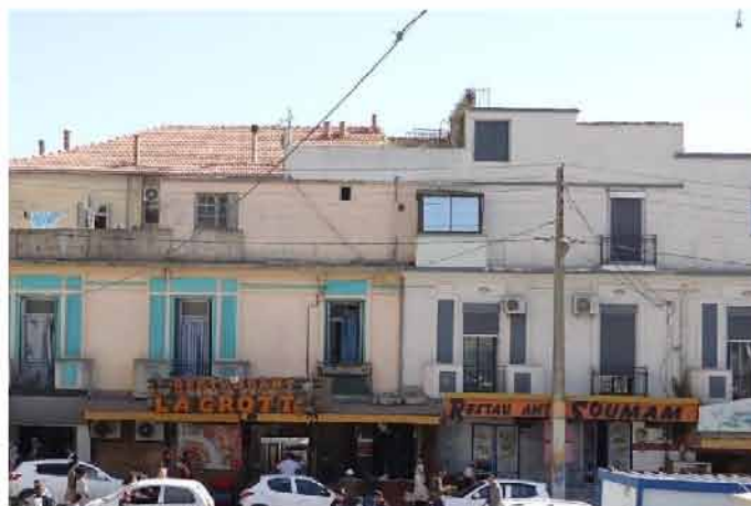
Figure 37 : Vue sur la façade commerciale - au sud du Park Mall - (Auteur, 2017)
