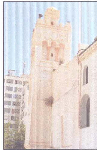
Fig 73 : L'état actuel du minaret, 15/09/2016. Source : Auteur
