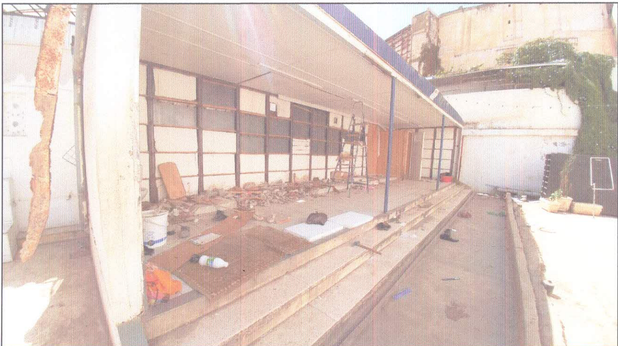
Fig 84 : L'extension de la mosquée Ali Betchine - L'emplacement des cabinets préfabriqués qui ont été démolis, 15/09/2016. Source : Auteur.
