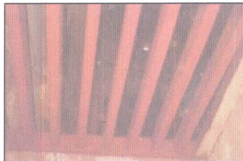
Fig 75 : Les planchers reconstitués de la salle de prière. Source : La DARQ
