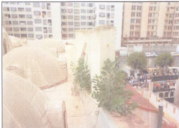
Fig 42 : Prolifération d'arbuste sur la terrasse, 2001. Source : Atelier 3D dimensions
