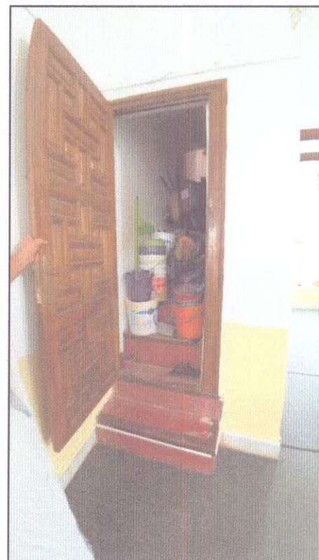
Fig 83 : Les escaliers du minaret bloqué, 15/09/2016. Source : Auteur.
