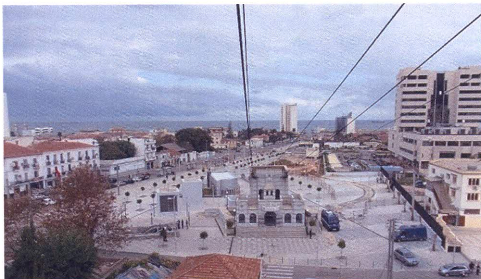
Figure 17 - Le Pôle Multimodal de Fusillés (vue plongeante d'ensemble)
