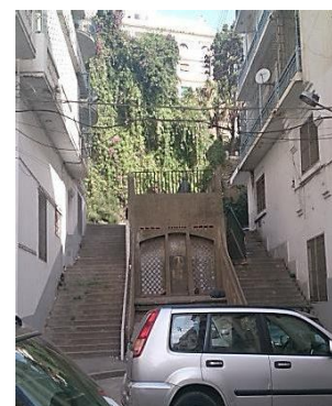
Fig. 88 : Rue à escalier entre l'immeuble n°87 et 85 boulevard Mohamed V.
