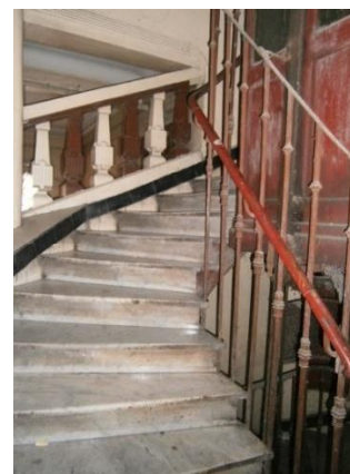
Fig. 101 : Escalier de l'immeuble. Source : Photo de l'auteur.
