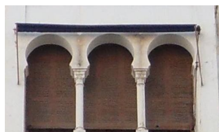
Fig.128 : Fenêtre à triple arcature au niveau de la saillie de l'immeuble n°15 avenue Sayed El Ouali. Source : Photo de l'auteur
