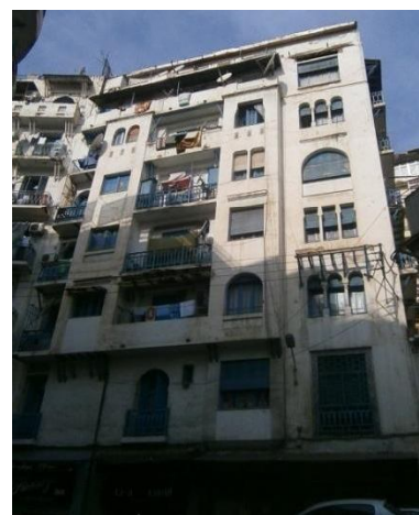
Façade sur l'avenue Sayed El Ouali
