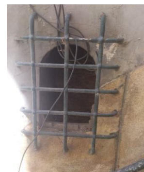
Fig. 125: Fenêtre protégée par une grille. Source : Photo de l'auteur
