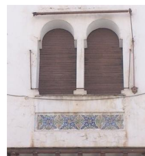
Fig.127 : Fenêtres géminées en arc plein cintre outrepassé. Immeuble n°15 Sayed El Ouali. Source : Photo de l'auteur.
