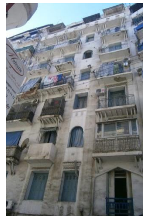
Façade sur l'avenue Sayed El Ouali
