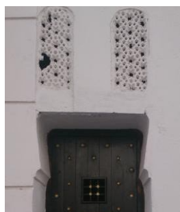
Fig.132 : Claustras surmontant la porte de service de l'immeuble n°95 boulevard Mohamed V.
