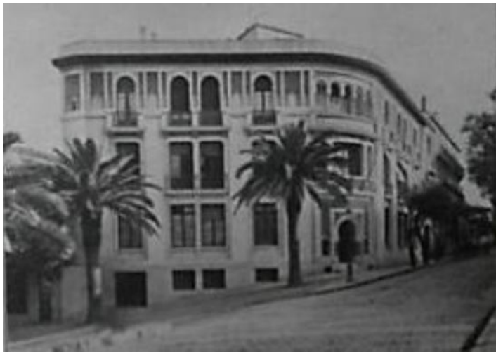
Fig. 70: Immeuble de la société « Standard Oil », rue Victor Hugo. Source : Revue Chantiers nord-Africains, Juillet 1933.
