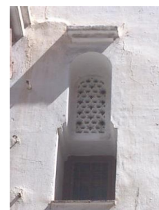
Fig. 133: claustras surmontant une fenêtre dans l'immeuble n°15 avenue Sayed El Ouali. Source :
