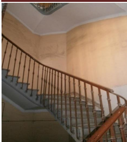
Fig.105 : Escalier de l'immeuble n°95 boulevard Mohamed V. Source : Photo de l'auteur.
