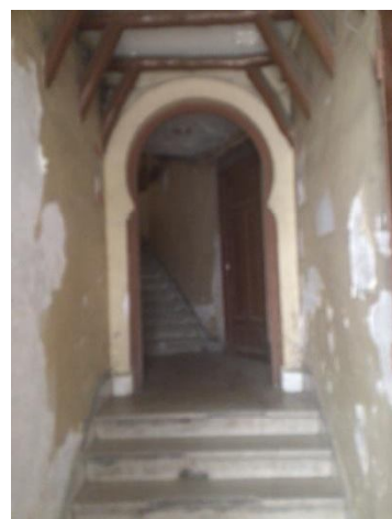
Fig. 99 : Accès au palier de desserte. Source : Photo de l'auteur
