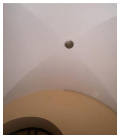
Fig. 120: le plafond voûté du hall d'entrée de l'immeuble n°15 avenue Sayed El Ouali. Source : Photo de l'auteur
