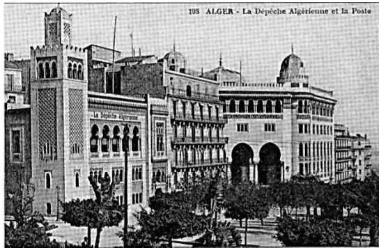
Fig. 67 : Immeuble de la dépêche algérienne et la grande poste.
