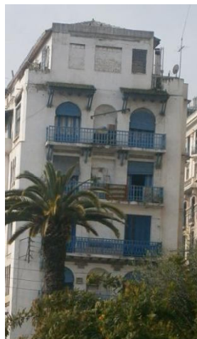
Façade sur l'intersection
