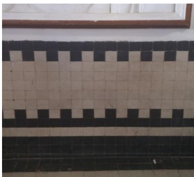
Fig.96: Revêtement mural du hall d'entrée. Source : Photo de l'auteur
