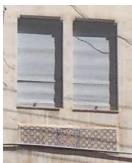
Fig. 126: Fenêtres géminées à degrés. Immeuble n°27 Sayed El Ouali. Source : Photo de l'auteur.
