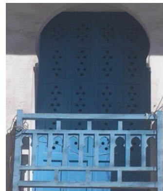
Fig. 130: Persienne en bois ouvragé dans l'immeuble n°97 boulevard Mohamed V. Source : Photo de l'auteur
