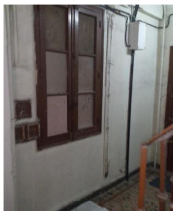
Fig. 103: Ouverture de la cage d'escalier sur courette. Source : Photo de l'auteur.
