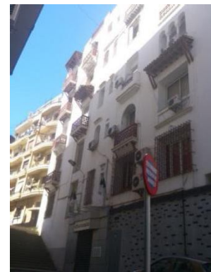
Façade sur Si Salah Mniout
