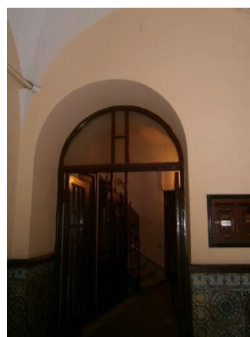
Fig. 100 : Accès au palier de desserte. Source : Photo de l'auteur
