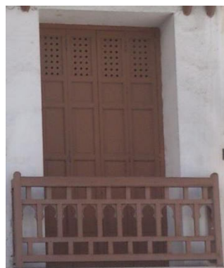
Fig. 129: Persienne en bois ouvragé dans l'immeuble n°15 avenue Sayed El Ouali. Source : Photo de l'auteur
