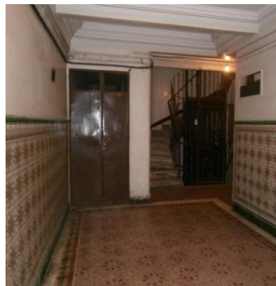
Fig. 98: Hall d'entrée de l'immeuble n°91 boulevard Mohamed V. Source : Photo de l'auteur
