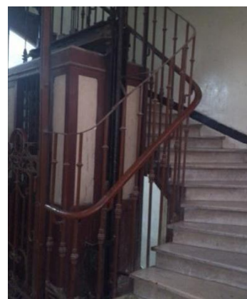
Fig.104 : Escalier de l'immeuble. Source : Photo de l'auteur.
