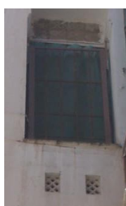
Fig.135 : claustras soulignant les fenêtres. Source : Photo de l'auteur
