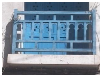
Fig.140: Garde-corps en bois ouvragé. Source : Photo de l'auteur.
