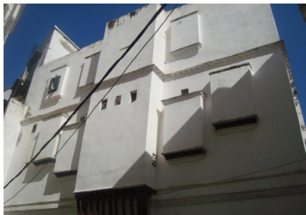
Fig.94 : Élément de composition de la façade extérieure de la maison de la Casbah. Le qbou et les niches en encorbellement. Source : Photo de l'auteur.
