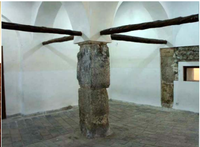
Photo 30: Appuis du sous-sol en pierre de taille de remplissage. (Source : auteur 2013).
