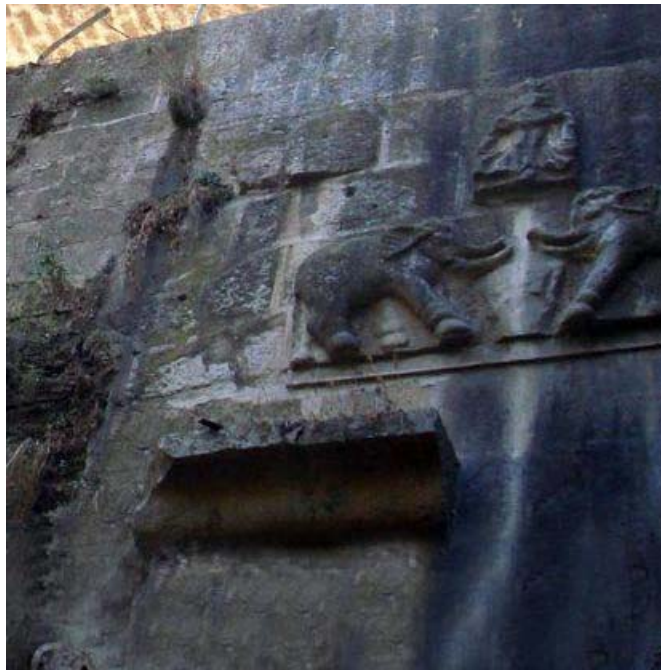
Photo 37: Éléments de réemploi au niveau du pont d'El Kantara. (Source: www. Contantinefree.com )
