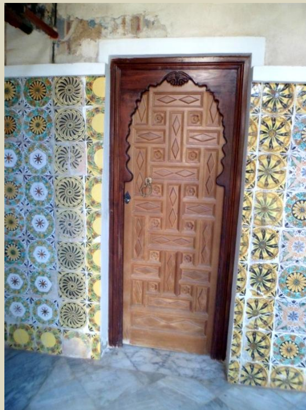
Carreaux de céramique utilisés au palais d'une grande hétérogénéité car de diverses provenances. (Source : auteur 2012)
