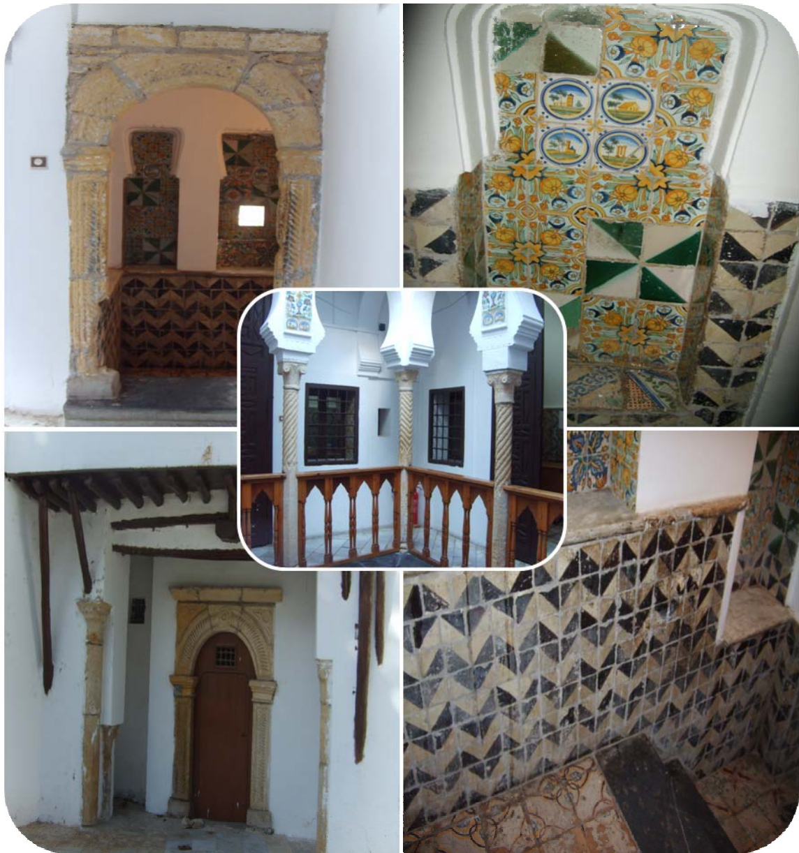
Photo 12: Vue des éléments architectoniques de remploi dans la maison du centenaire. (Source : Auteur 2011)
