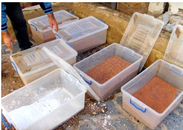
Photo 16: Recyclage des briques et éléments en terre cuite ou séchée en gravats. Chantier de restauration de la citadelle d'Alger (Source : auteur 2011)
