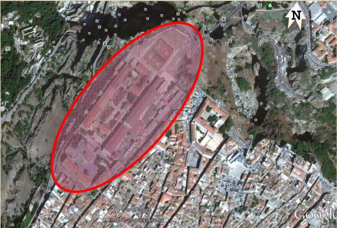
Figure 24: Localisation et délimitation de la caserne de la Casbah. (Source : vue de Google Earth 2012)
