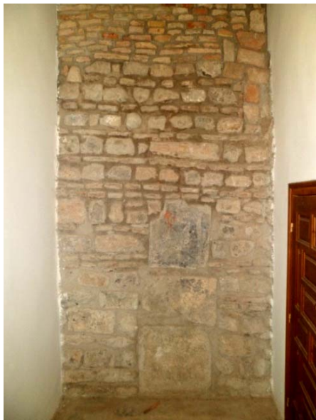
Photo 29: Appareillage d'un mur au niveau du palais avec pierre de taille de remplissage. (Source : auteur 2013).
