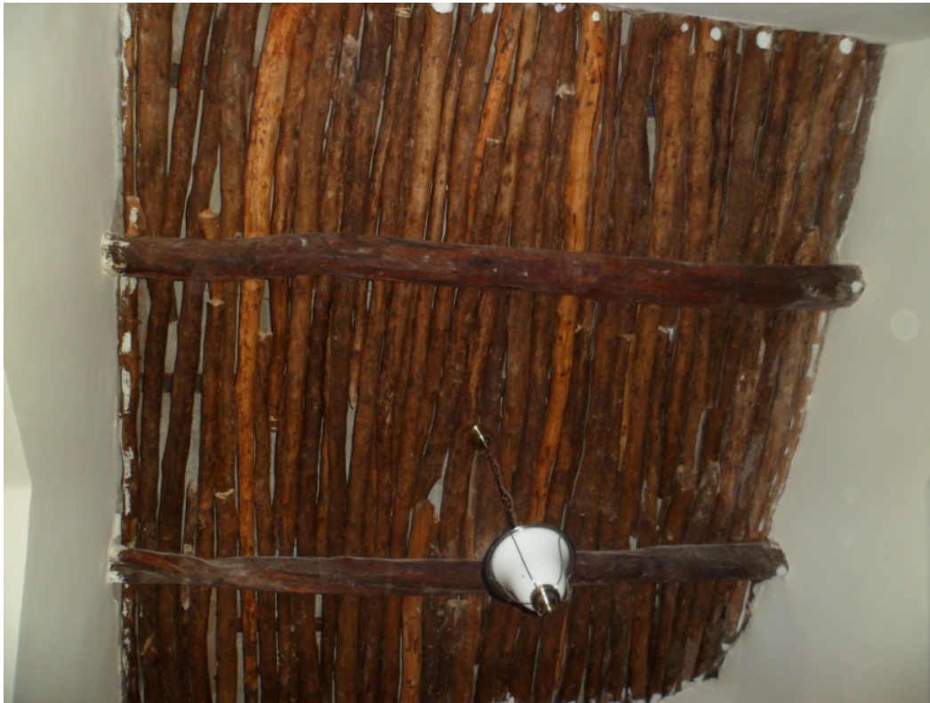
Photo 35: Réutilisation des rondins de thuya comme revêtement esthétique au plafond du sous-sol . (Source : Auteur 2012)
