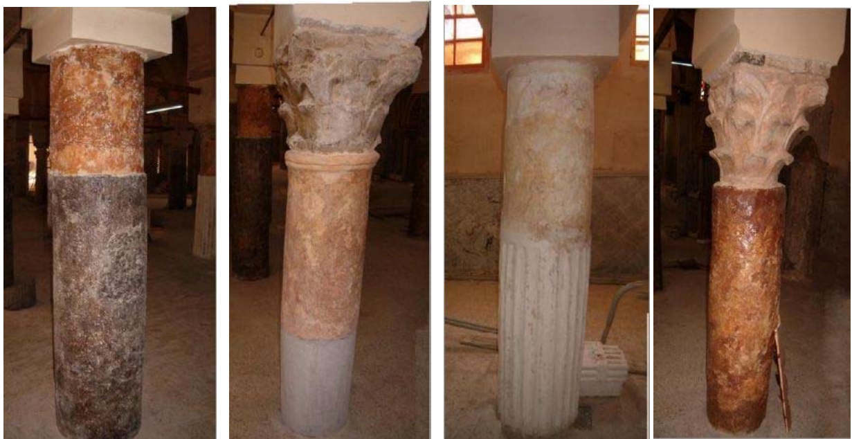
Figure 20 : Colonnes de la grande mosquée de Constantine lors d'une opération de restauration : on distingue parfaitement l'hétérogénéité des futs de colonnes et des chapiteaux de remploi. (Source : M.Kheroutou 2012)
