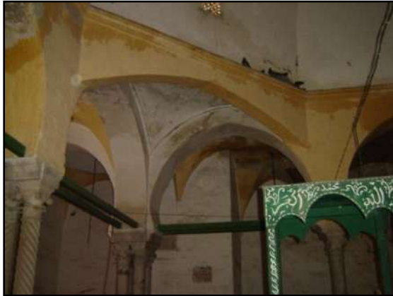
Fig. 113 : Transition au niveau de la coupole, mosquée du Dey : triangle sphérique. (Source : auteur).
