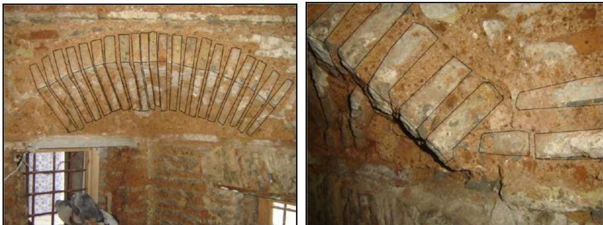
Fig. 140 : Trompe du mausolée Sīdī Muḥamad al-Sharīf . (Source : auteur, décembre 2010).
