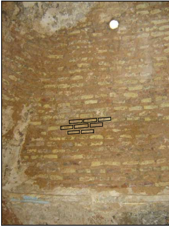
Fig. 143 : Structure du pan, briques posées en boutisse, coupole du bain des Aghas. (Source : auteur, juillet 2010).
