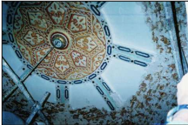
Décor de la grande coupole, rosace en plâtre, et arêtes en carreau de céramique.
