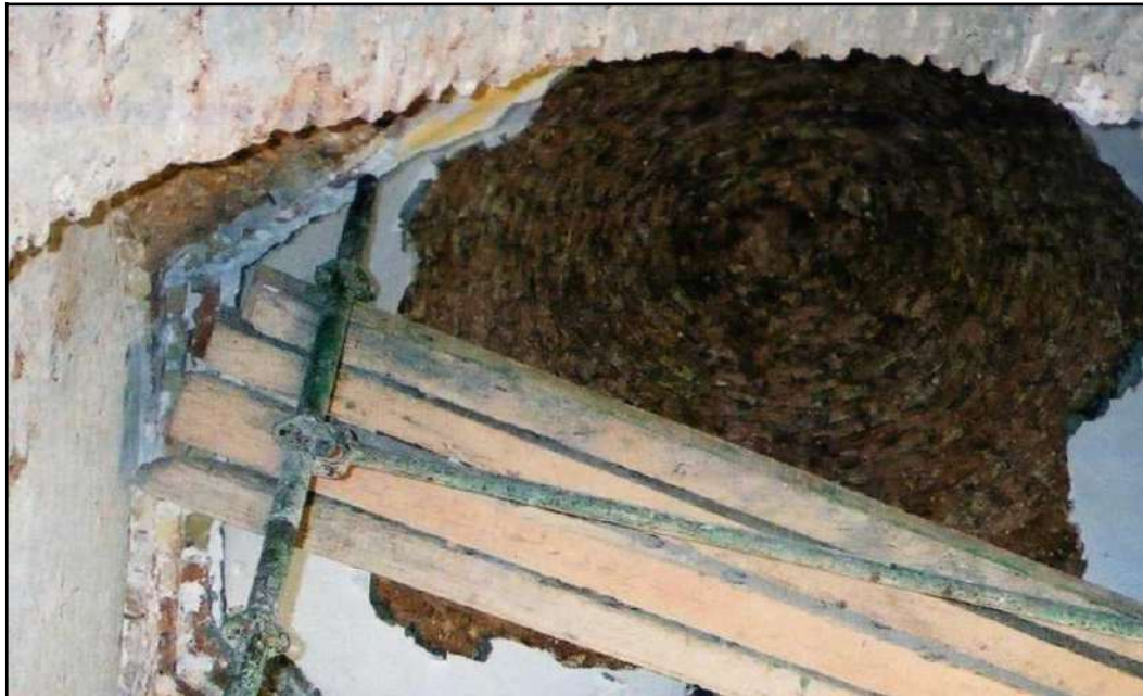
Fig. 180 : Coupolette, mosquée 'Alī Bidjnīn. (Source : bureau d'étude Atelier 3D, juin 2001).
