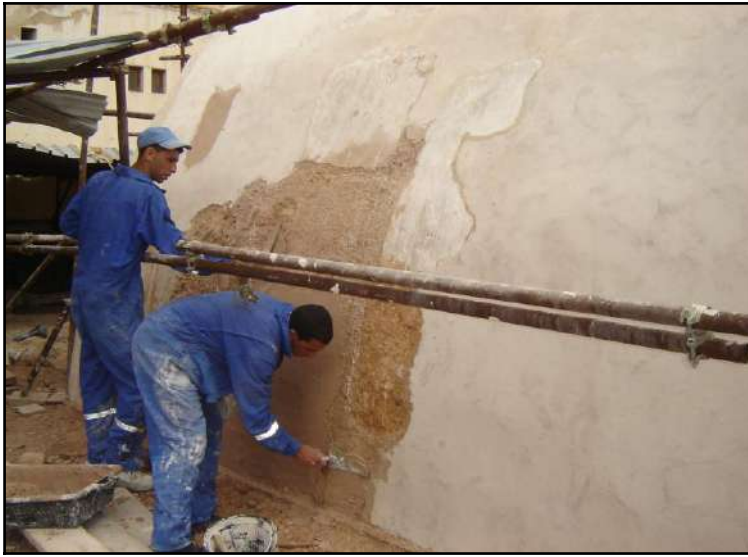
Fig. 161 : Restauration de la grande coupole, mosquée du Dey, été 2010.
