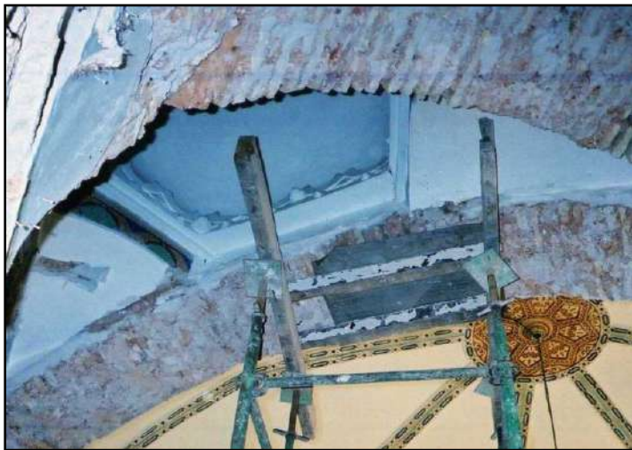
Fig. 112 : La transition au niveau de la grande coupole de la mosquée ' Alī Bidjnān . La surface triangulaire résultante comprend des coupolettes hexagonales. (Source : bureau d'étude Atelier 3D, 2001).
