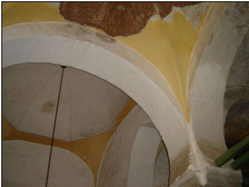
Fig. 101 : Pendentifs triangulaires, mosquée du Dey. (Source : auteur, juillet, 2010).
