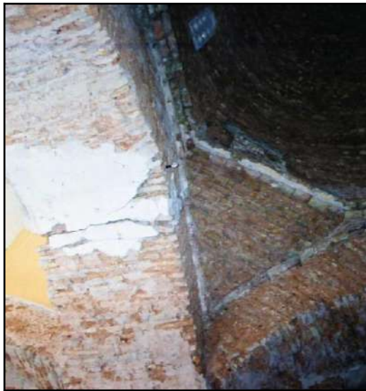
Fig. 139 : Raccordement par des pendentifs, coupolette, mosquée 'Alī Bidjnīn . (Source : bureau d'étude Atelier 3D, juin 2001).
