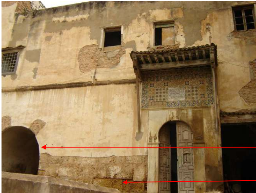
Fig. 131 : Mur porteur de la mosquée du Dey à la Citadelle.
