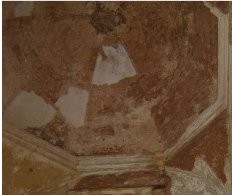
Fig. 202 : Coupolette nord « E », mosquée du Dey.
