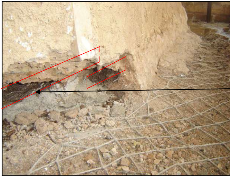
Fig. 145 : Les rondins incorporés dans l'assise d'une petite coupole, mosquée du Dey à la Citadelle d'Alger.
