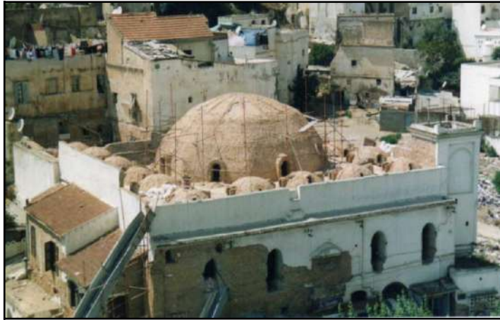
a-Grande coupole entourée de coupolettes, mosquée ' Alī Bidjnīn '. (Source : bureau d'étude Atelier 3D, juin 2001).
