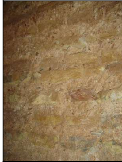
Fig. 156 : L'appareillage dit à l'anglaise de la grande coupole, mosquée du Dey.
