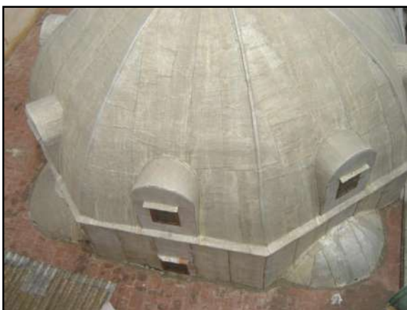
Fig. 119 : Coupole sur tambour octogonal, mosquée al-Safir .
