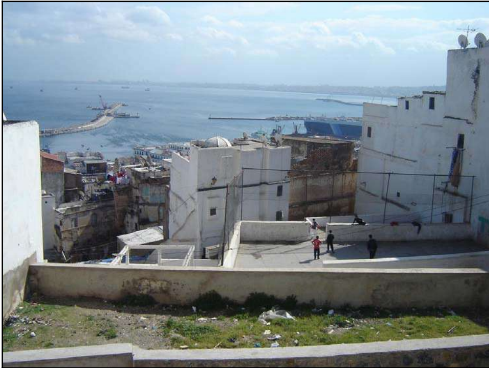
Fig. 20 : Coupole d'un minzah , 3 rue N'Fissa, Casbah d'Alger. (Source : auteur, juillet 2010).
