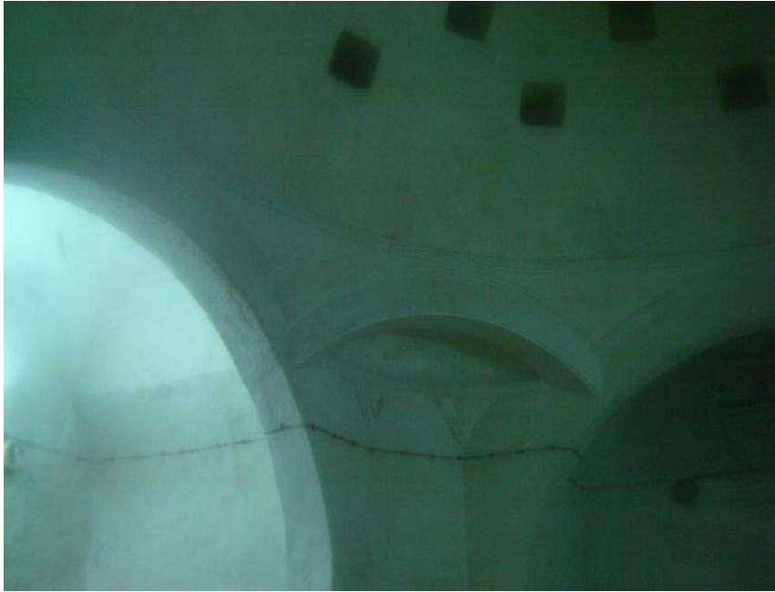
Fig. 61 : Coupole hémisphérique, hammam Sīdna . (Source : auteur, juillet 2010).
