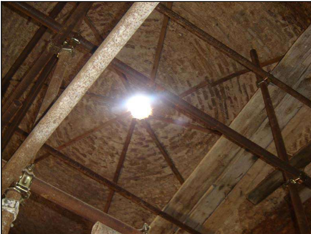
Fig. 150: Assises circulaires, grande coupole de la mosquée du Dey. (Source : auteur, juillet 2010).
