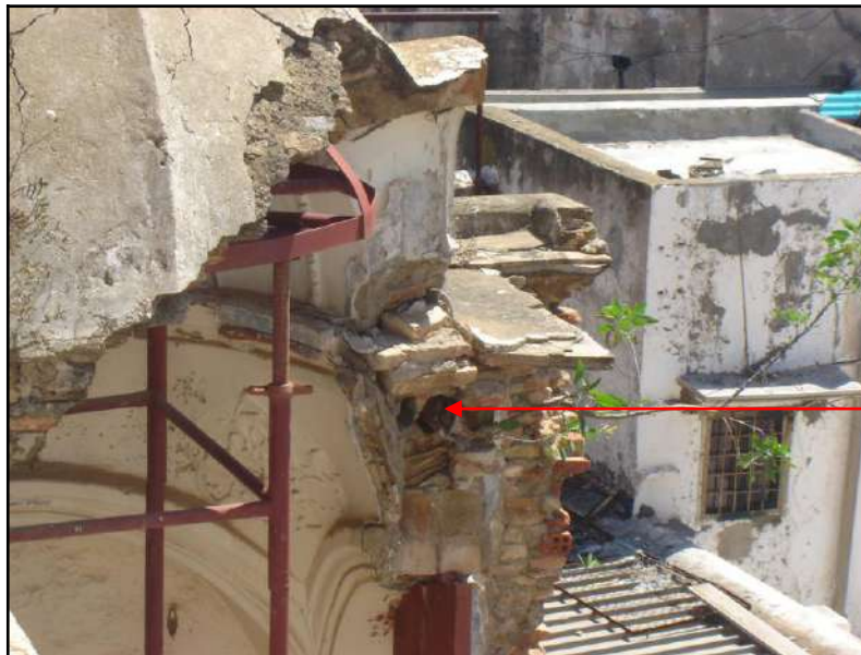
Fig. 146 : Emplacement des rondins en bois, petite coupole d'une pièce supérieure dans une maison à patio, sise, 5, Impasse des Frères Bachara, Casbah d'Alger.
