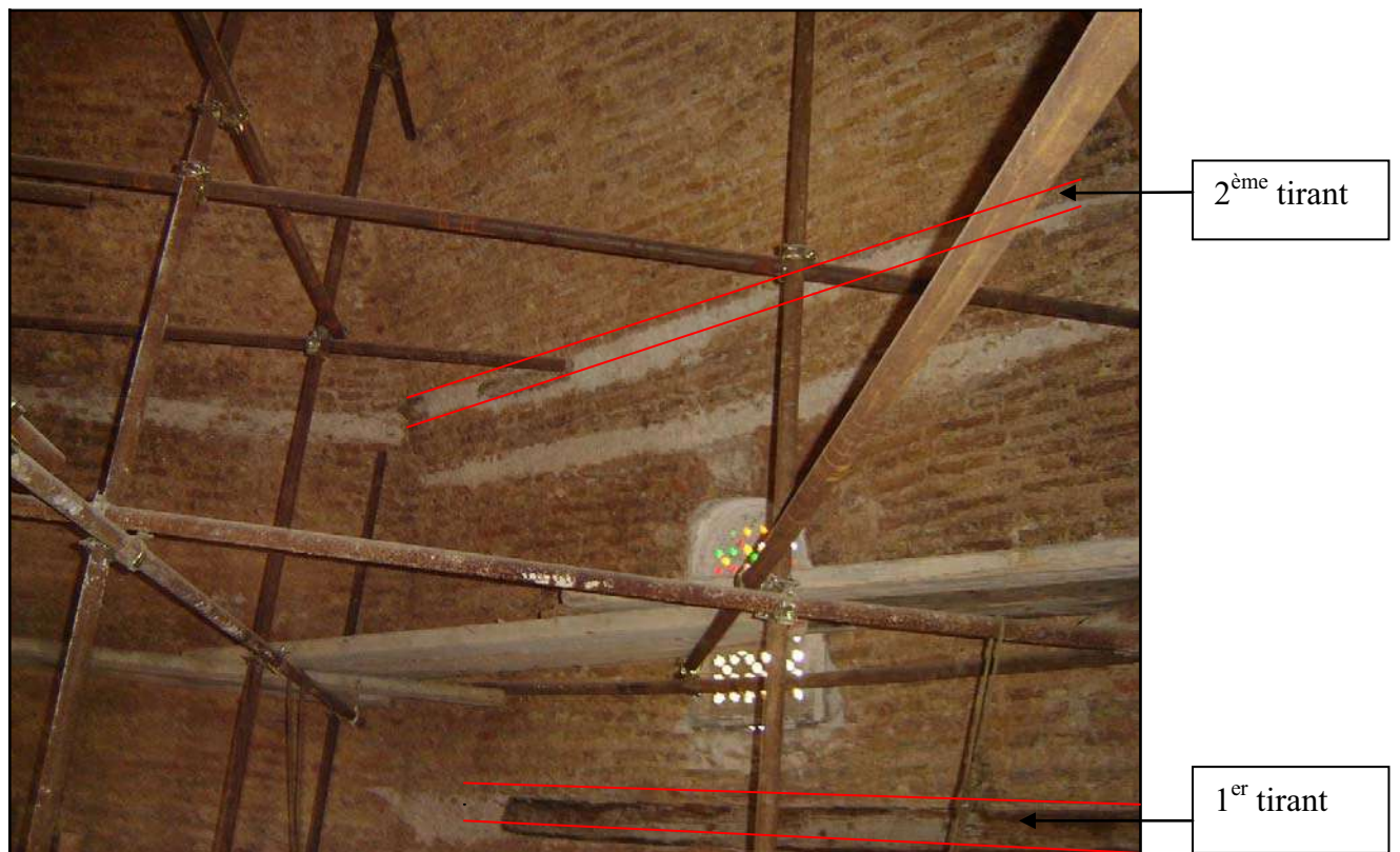
Fig. 160 : Insertion d'une deuxième rangée de tirant au-dessus des fenêtres. (Source des deux figures : auteur, juillet 2010).
