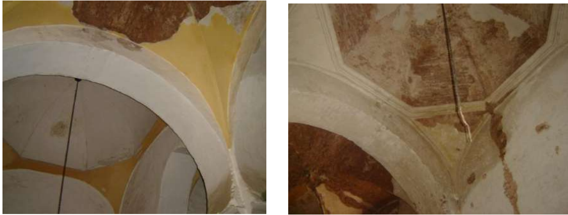
Fig. 205 : Coupolette « F » avant et après décapage des enduits, mosquée du Dey.
