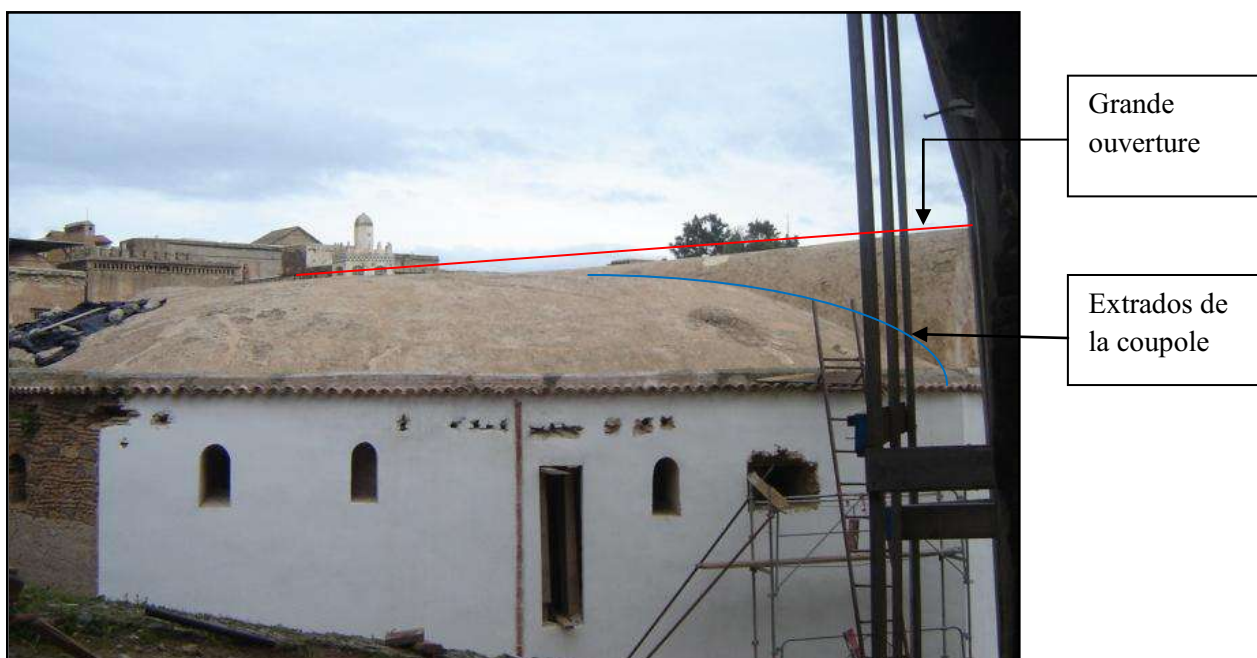
Fig. 35 : Photographie de la coupole surbaissée de la poudrière Citadelle d'Alger. (Source : auteur, juillet, 2010).
