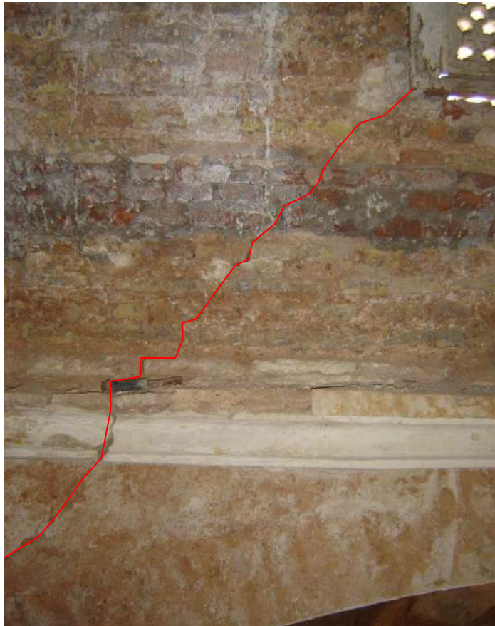
Fig. 184. a : Pan Est, fissure de gauche, grande coupole de la mosquée du Dey. Fissure à 45°, ouverte entre 3 et 4mm, elle démarre de la fenêtre, traverse la corniche et l'écoinçon au-dessus de l'arc.
