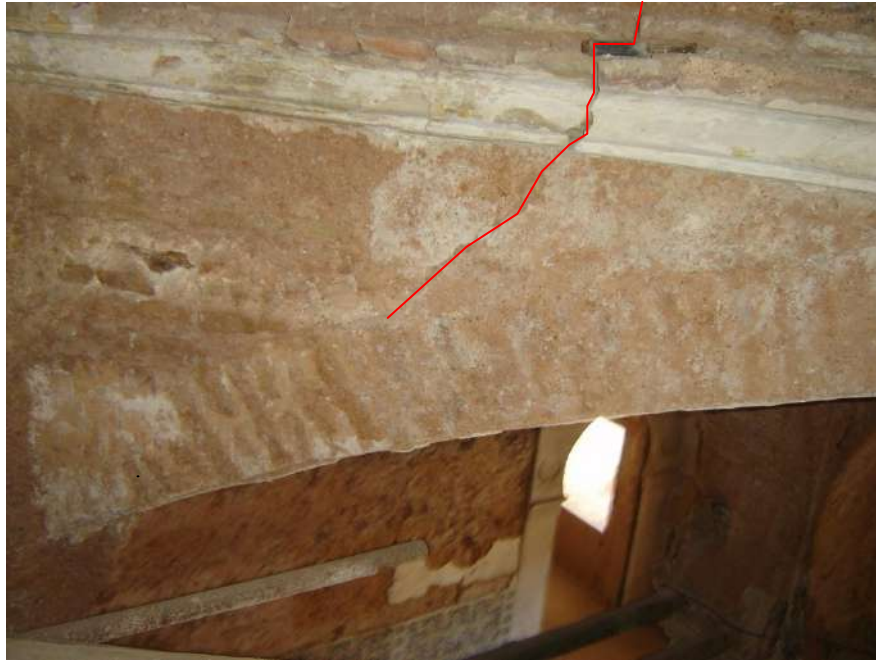
Fig. 184 b : Pan Est, fissure de gauche, grande coupole de la mosquée du Dey. La fissure s'arrête au niveau de l'écoinçon, l'arc est intact, il bloque la lézarde. Le changement dans la disposition des briques entre l'écoinçon et l'arc n'a pas laissé la fissure continuer.
