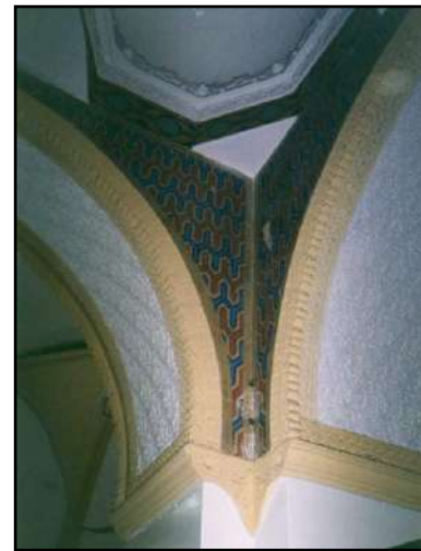
Fig. 112 : La transition au niveau de la grande coupole de la mosquée ' Alī Bidjnān . La surface triangulaire résultante comprend des coupolettes hexagonales. (Source : bureau d'étude Atelier 3D, 2001).
