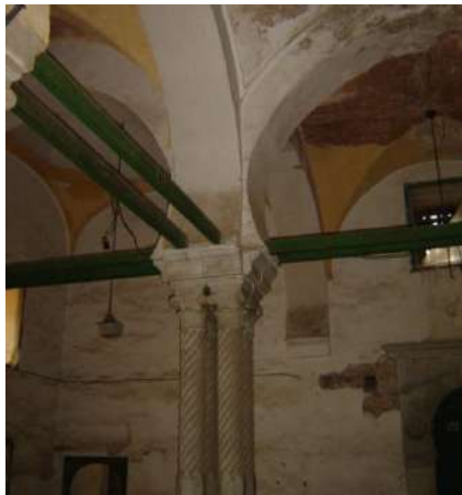
Fig. 174 : Légèreté des supports de la coupole centrale, mosquée du Dey.
