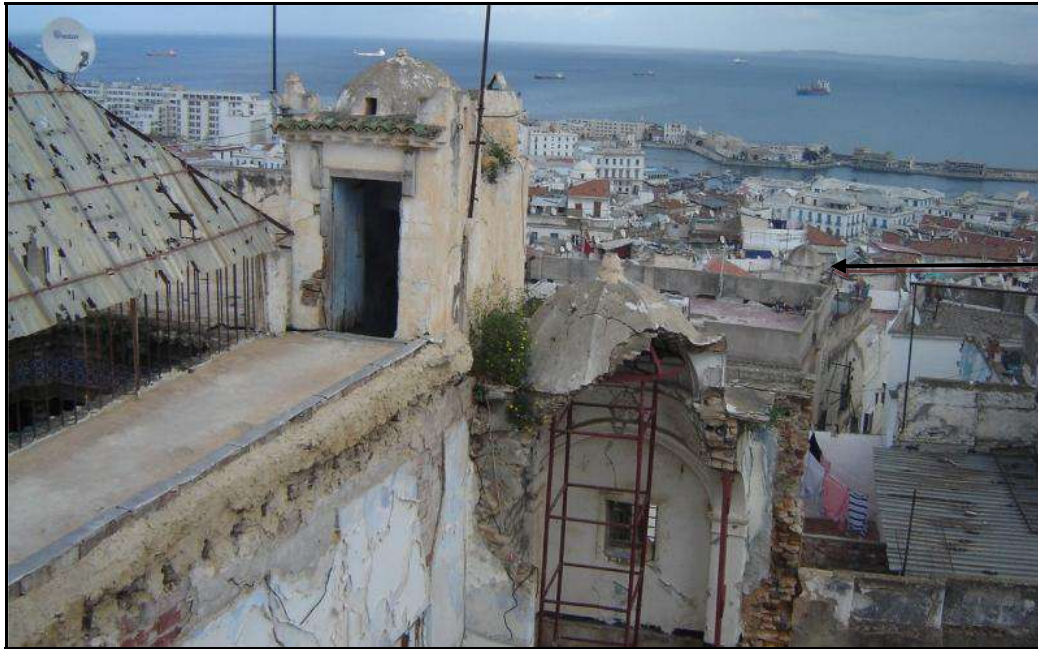
Fig. 17 : Vue à partir d'une terrasse à la Casbah, maison, sise, 5 Impasse des Frères Bachara.
