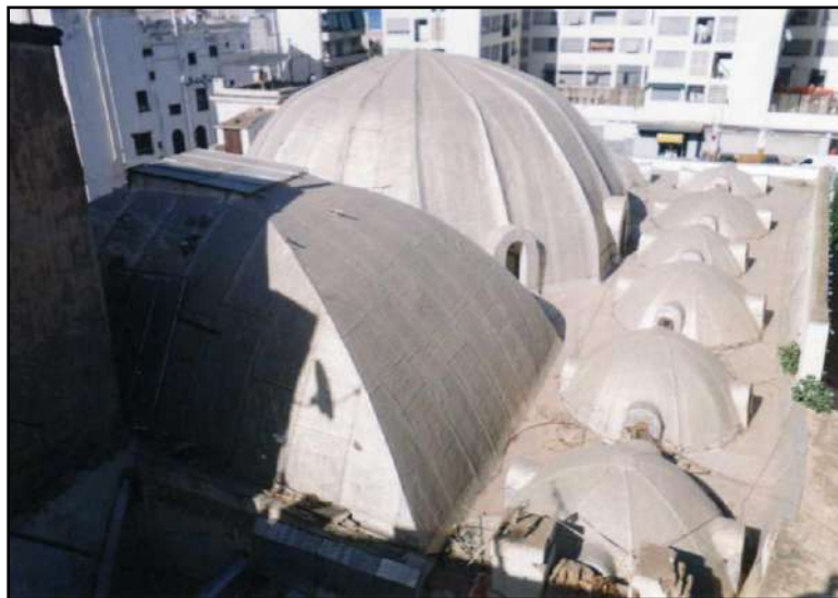
Fig. 98 : Vue d'ensemble, mosquée 'Alī Bidjnīn. (Source : bureau d'étude Atelier 3D, 2001).
