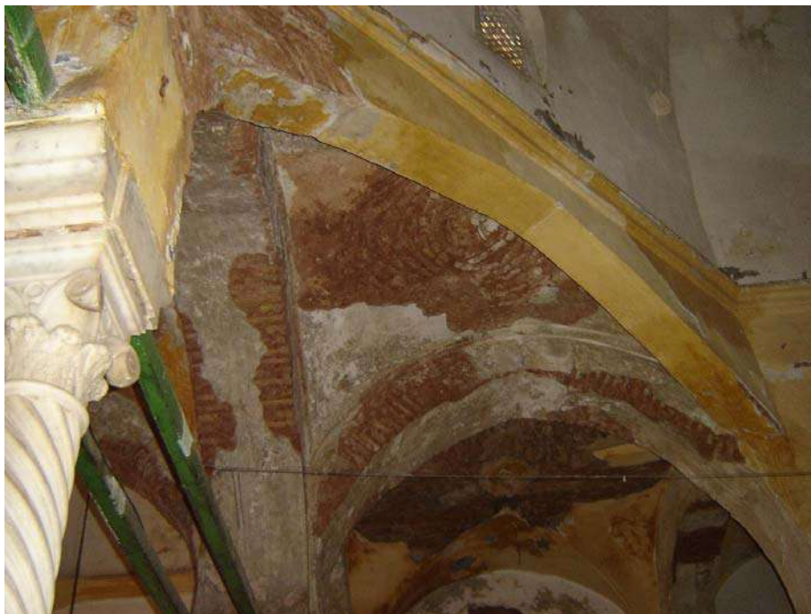
Fig. 169 : Système de transition à trois arcs, stabilisant l'angle de la calotte. (Source : auteur, juillet 2010)
