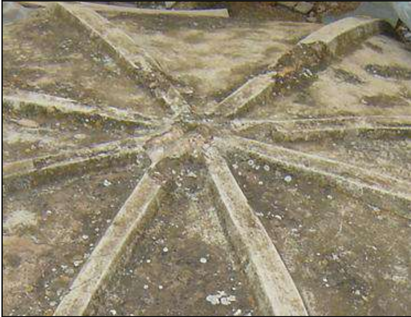
Fig. 154 : La liaison entre les nervures externes, coupole du bain du Harem, Citadelle d'Alger. (Source : auteur, juillet 2010).
