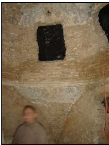
Fig. 125 : Pendentifs du bain des Aghas, posés sur des murs porteurs.
