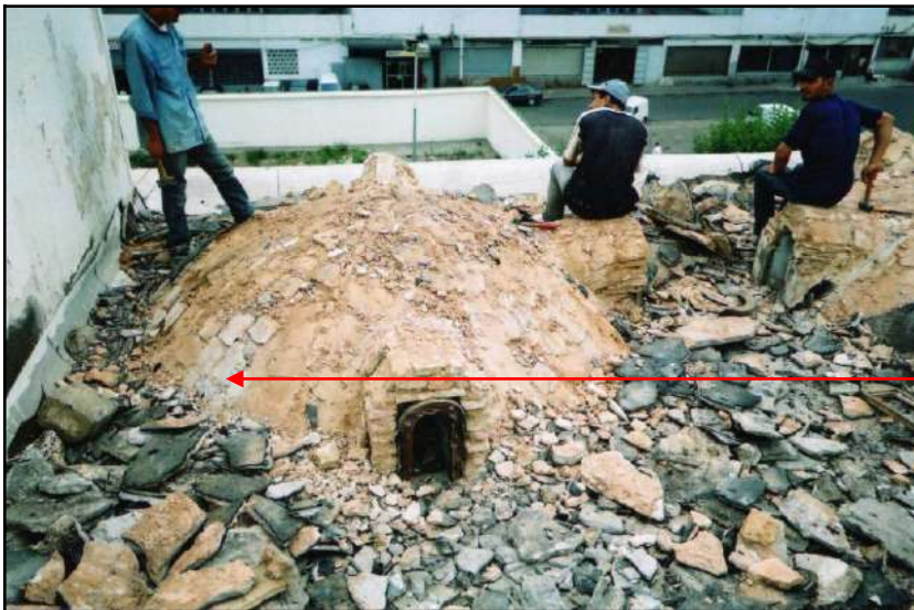
Fig. 155 : Couverture extérieur en brique des coupolettes de la mosquée 'Alī Bidjnīn. (Source : bureau d'étude Atelier 3D, juin 2001).
