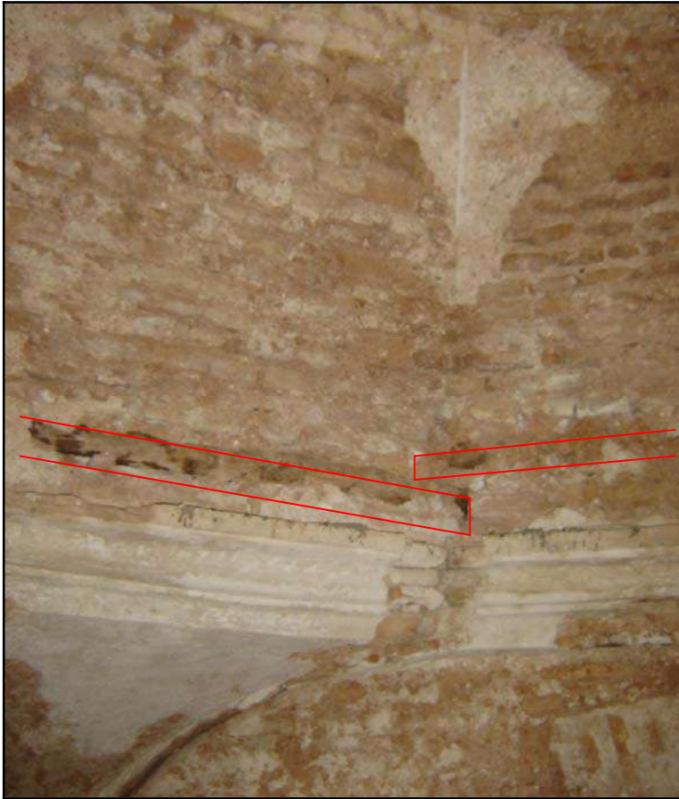
Fig. 147 : Chevauchement des rondins en bois entre deux pans de coupole. (Source : auteur, juillet 2010).
