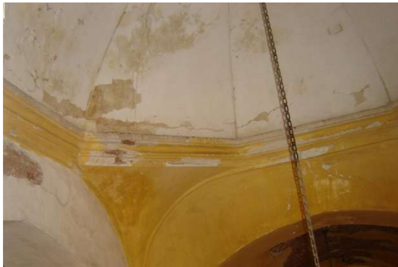
Fig. 203 : Coupolette nord avant décapage des enduits, mosquée du Dey.
