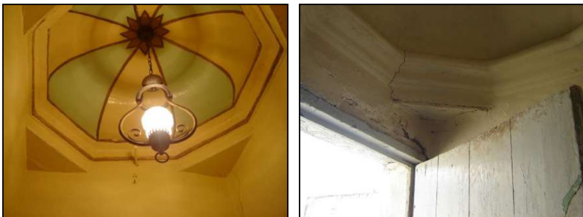
Fig.129 : Pendentif horizontal, maison située au 1 Impasse Saïd Amara, Casbah d'Alger. (Source : auteur, juillet 2010).
