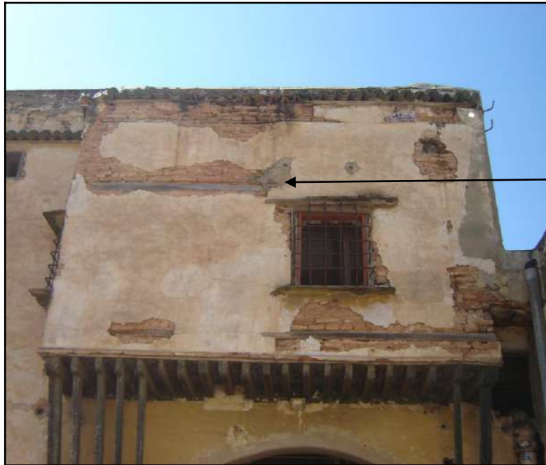
Fig. 133 : Mur mixte brique rondin en bois, palais du Dey à la Citadelle.
