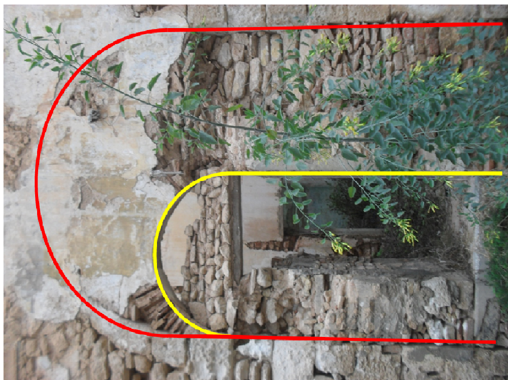
Ph 29. Les traces de l'arcade en pierre noyée dans le mur ajouté par les ottomans. (S. Hassam)
