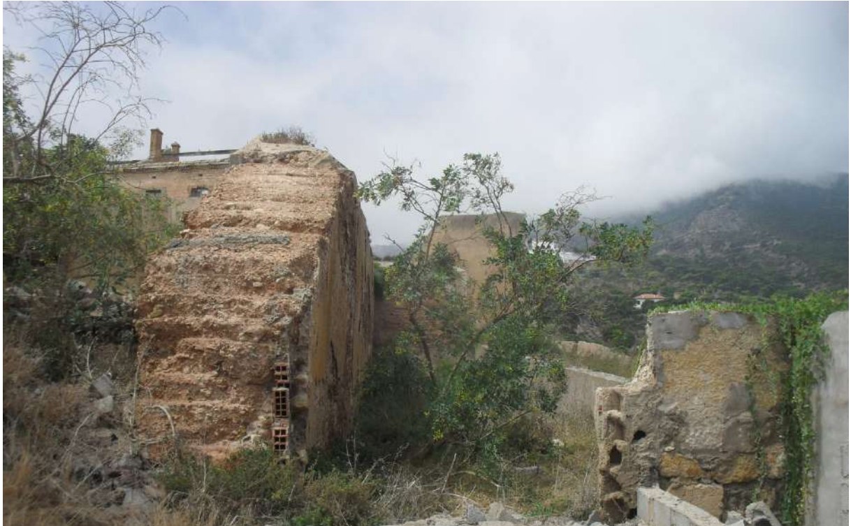
Ph 20. Trace d'une muraille en pisé. Partie haute de la Citadelle. Face Bastion Santa Isabel. (S. Hassam)
