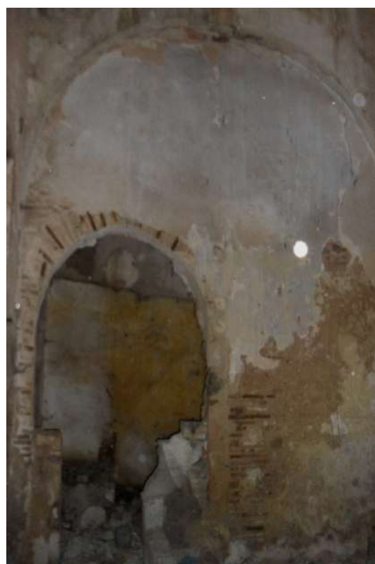
Ph 6. Vue sur l'arcade en pierre du bâtiment (A) noyée dans une paroi rajoutée par les Ottomans. (S. Hassam)
