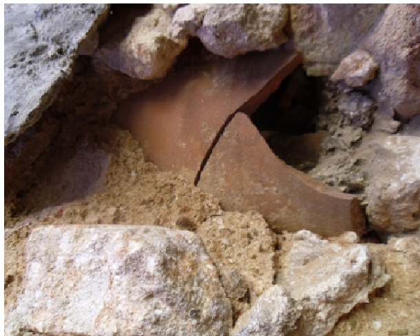
Ph 34. Canalisation des eaux pluviales noyée dans le mur Sud. (S. Hassam)
