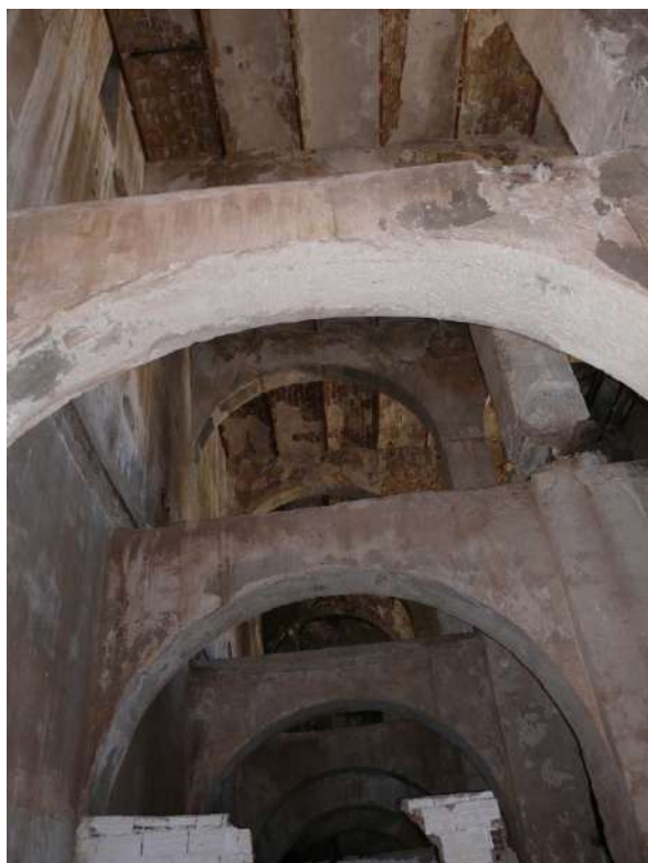
Ph 27. La couverture en poutrelles métalliques (IPN) et voûtaines en briques. (S. Hassam)
