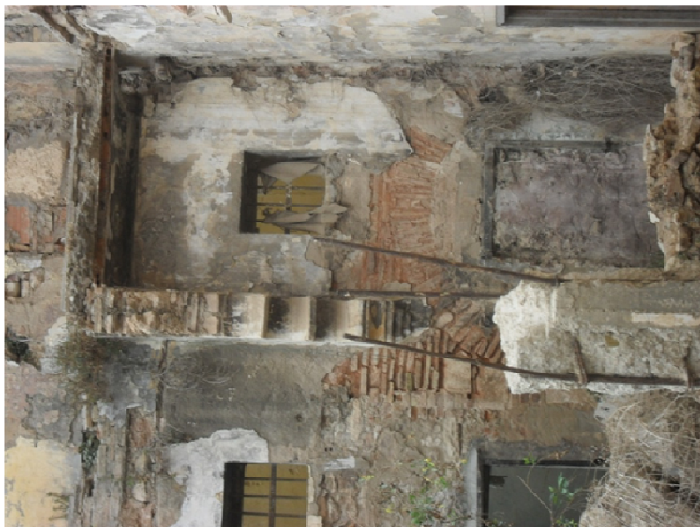
Ph 33. Façade Sud : une arcade noyée dans le mur, un arc polylobé endommagé et une partie du plancher de la galerie en voutain. (S. Hassam)
