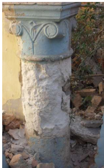
Ph 19. Colonne de l'arcade d'une des galeries. (S. Hassam)
