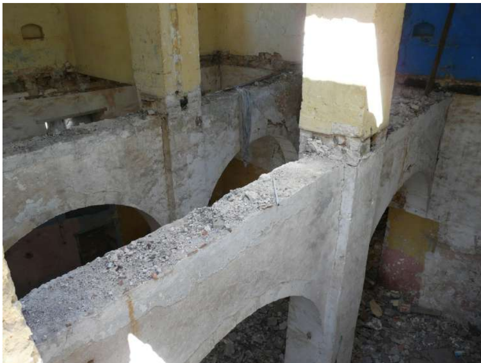
Ph 26. Vue du haut des arcades du Bâtiment (A). (S. Hassam)
