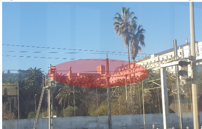
Figure 96 : vue du quartier prise sur la route moutonnaire. Photo prise le 02/12/2016.
