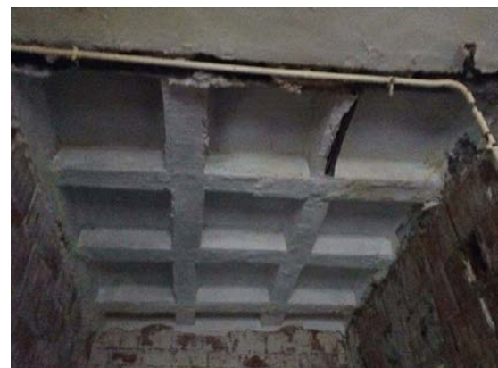
Figure 232 : vue prise dans le SDB sur le plancher Photo prise décembre 2015
