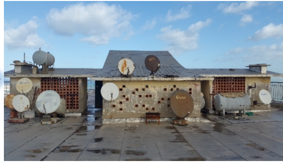
Figure 181 : la dalle pleine qui couvre les escaliers actuellement. Photo prise décembre 2015
