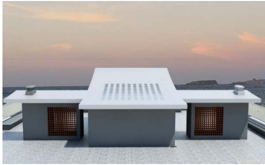
Figure 180 : la dalle pleine qui couvre les escaliers avant
