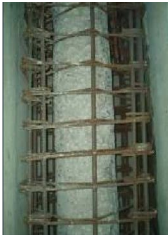
Figure 52 : Le ferrailage pour un chemisage Source : (Xavier CASANOVAS, 2007)
