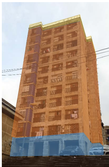
Figure 195 : façade Nord- Est Photo prise décembre 2015
