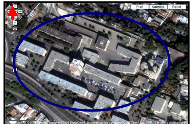
Figure 95 :Photo du quartier Diar el Mahçoul partie confort source : (Google earth, 2016)
