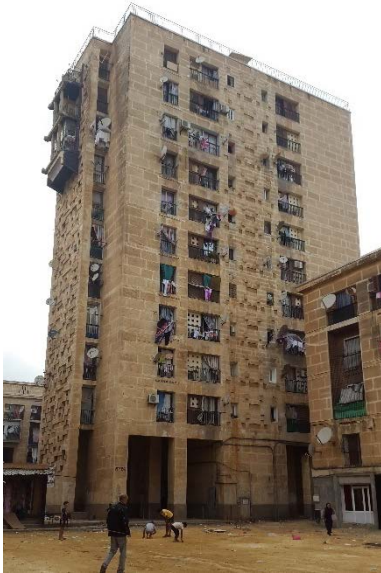
Figure 159 : vue sur le cas d'étude du côté Sud Photo prise décembre 2015
