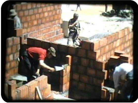
Figure 218 : Des cloisons en briques source : (Stéphane Gruet, 1953)
