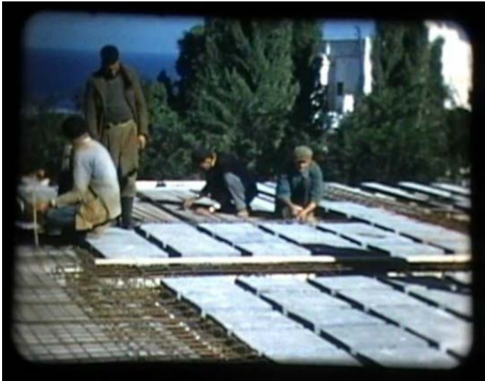
Figure 235 : le plancher lors de sa fabrication source :(Stéphane Gruet, 1953)
