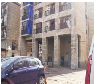
Figure 149 : système en portique
