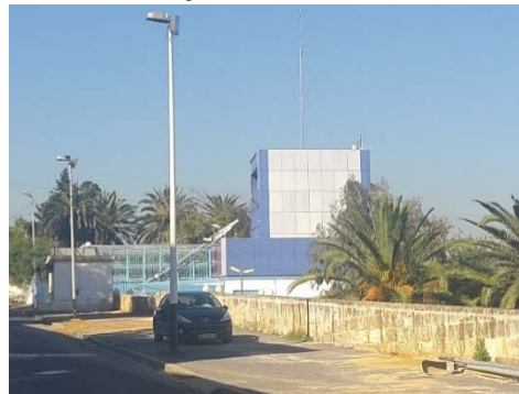
Figure 140 : recouvrement du locale de la téléphérique par de l'allicouband (20) Photo prise décembre 2015
