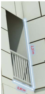
Figure 199 : porte fenêtre du séjour
