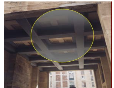
Figure 148 :les planchers à armature croisés
