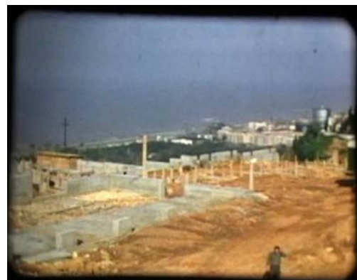
Figure 216 : vue sur fondation source : (Stéphane Gruet, 1953)
