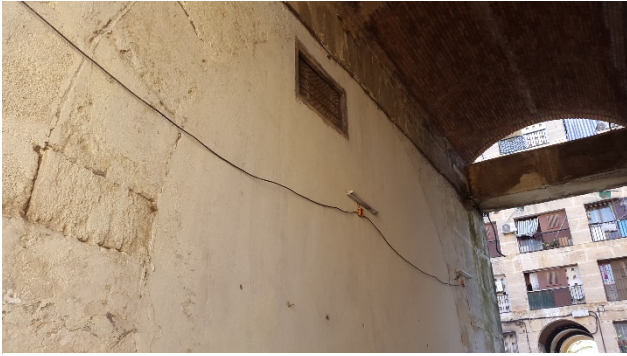
Figure 138 : la fermeture de la galerie afin de créer des boutiques pour les vendeurs (17)
