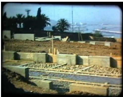
Figure 215 : vue sur les fondations source : (Stéphane Gruet, 1953)
