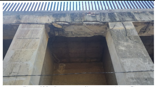
Figure123 : Poutre pour l'espace extérieur(7) Photo prise décembre 2015
