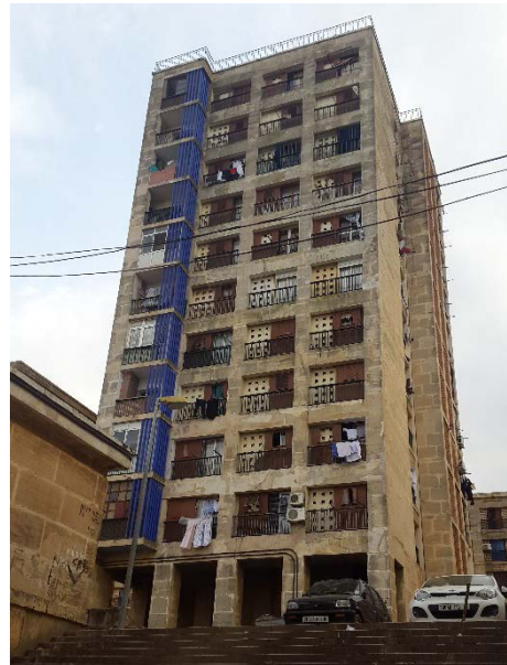
Figure 160 : vue sur le cas d'étude du côté Nord Photo prise décembre 2015
