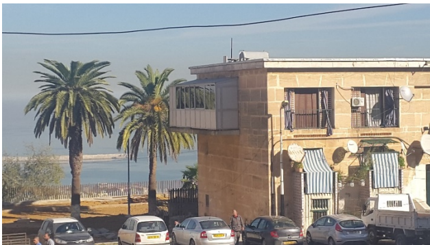
Figure 139 : le cloisonnement du balcon pour le faire renté à l'espace intime afin de l'utiliser comme loggia (19) Photo prise décembre 2015
