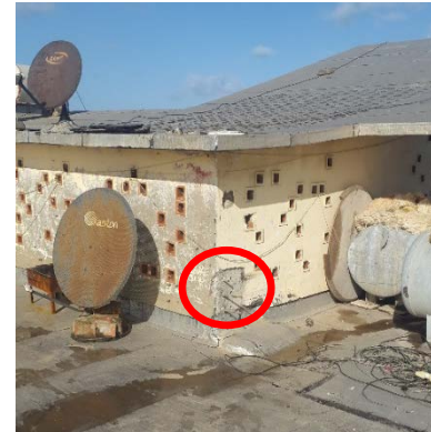
Figure 169 : détachement un élément décoratif au niveau de l'encorbellement
