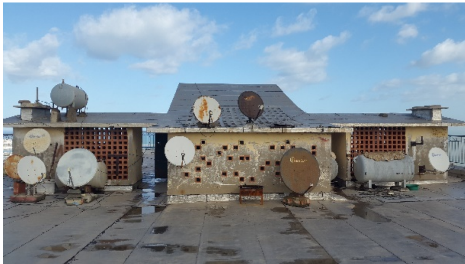
Figure 237 : le plancher translucide qui couvre les escaliers Photo prise décembre 2015
