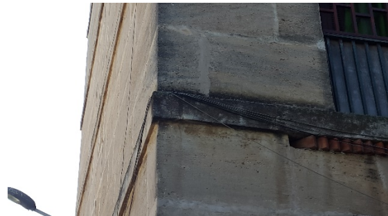
Figure 128 : le sulfite par La pollution apportée par l'eau de pluie(10) Photo prise décembre 2015
