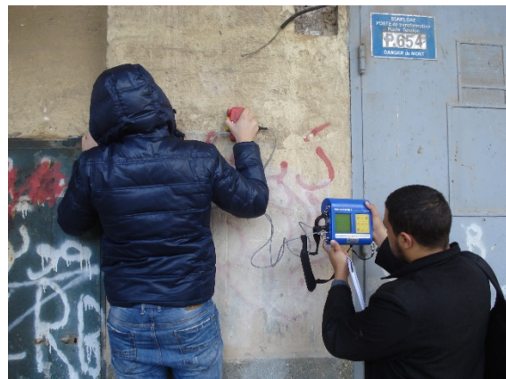
Figure 274 : les essais en utilisant le détecteur d'armature Photo prise décembre 2015
