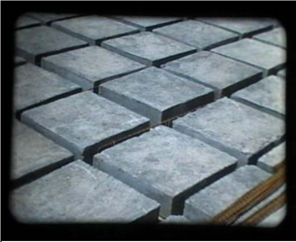
Figure 233 : le montage des marmites dans le chantier Diar El Mahçoul source :(Stéphane Gruet, 1953)
