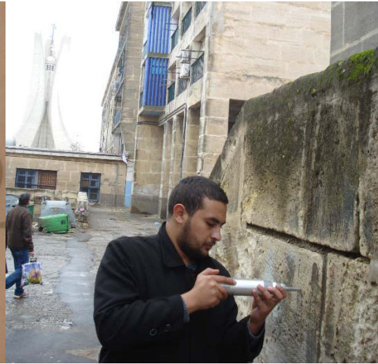
Figure 272 : les essais en utilisant le scléromètre Photo prise décembre 2015
