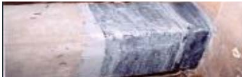
Figure 61 : Renforcement par les fibres de carbone Source : (ATTARI, 2013)
