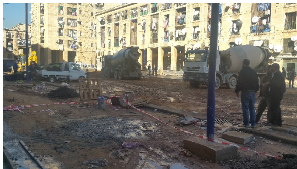
Figure 143 : photo de chantier en cours des travaux le 01/12/2015 (22)
