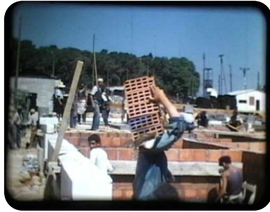
Figure 219 : Des cloisons en briques et le mur périphérique en pierre source : (Stéphane Gruet, 1953)
