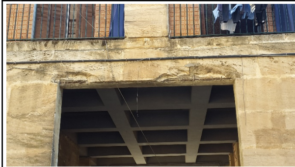
Figure 122 : poutre d'immeuble(6) Photo prise décembre 2015
