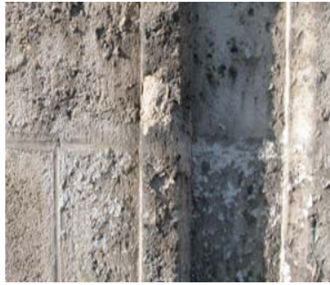
Figure 37 : La pollution entraîne avec le temps la production d'une couche noirâtre (Le sulfite) qui bouche les pores des pierres et l'empêche de respirer. Source : (JB Blom, Caroline Fogliani & DAC, Avril 2009)
