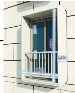
Figure 207 : porte fenêtre de la chambre
