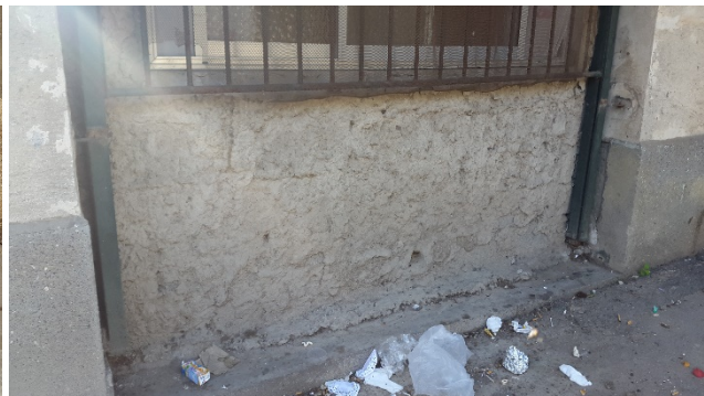
Figure 137 : remplacement du garde-corps en acier par un autre en brique (16) Photo prise décembre 2015
