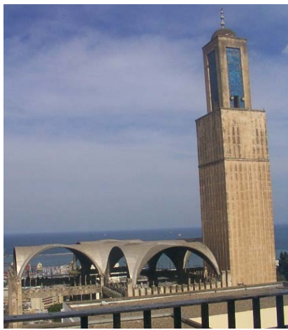
Figure 157 : les voutes d'arrête de la mosquée Photo prise décembre 2015
