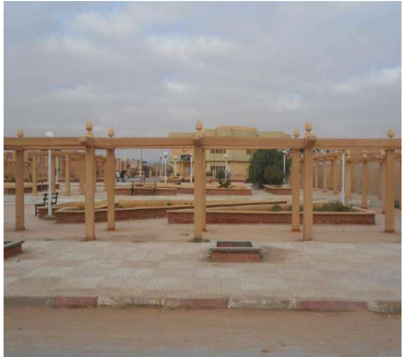
Figure 138 : Esplanade de rencontre, jonction entre la zone d'habitat et celle des équipements de la ville nouvelle de Bellil (Source : Sofrani K , mars 2016)
