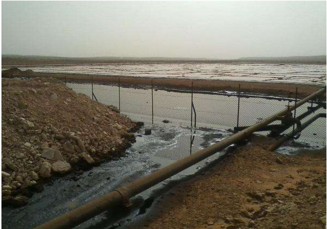
Figure 153 : Vue des puits-bourbiers de Hassi R'mel qui débordent
