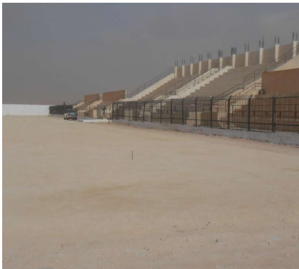
Figure 80: Projet de terrain de sport en cours de réalisation dans la ville de Bellil (Source : Sofrani K le 20 mars 2017)
