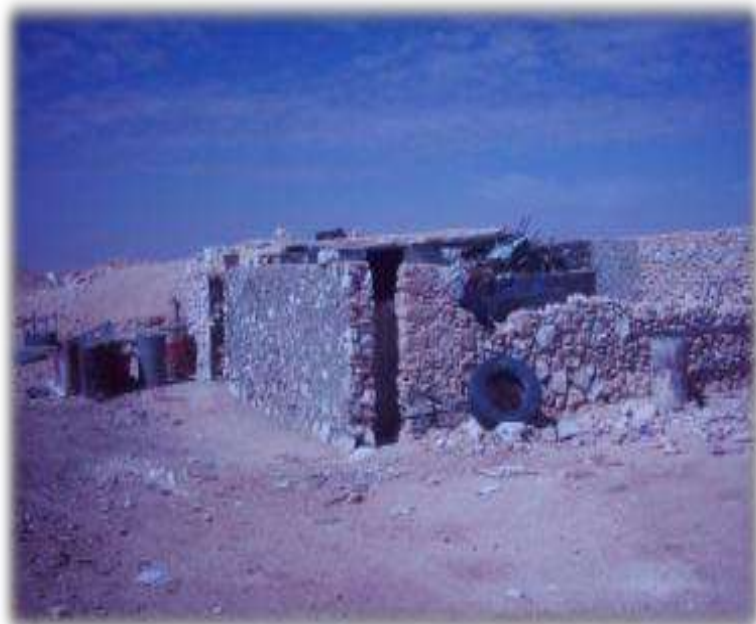
Figure 93 : La construction en pierre local avec un mortier de tuf et de ciment (Source : Sofrani K janvier 2009)
