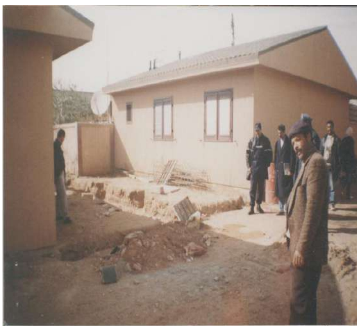
Figure 58 : extension informelle dans une résidence de fonction à Hassi R'mel (source : APC Hassi R'mel ).
