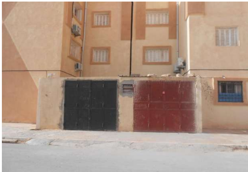
Figure 125: Construction d'un espace pour stationnement de voiture en occupant la voie publique (Source : Sofrani K, 22 mars 2017)
