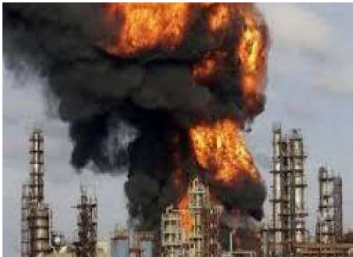
Figure 22 : L'incendie de l'usine GNL à Skikda du 14 février 2013 (Source : http://www.lematindz.net/news/11072-incendie-de-la-raffinerie-de-skikda-operation-assurance-de-sonatrach.html )
