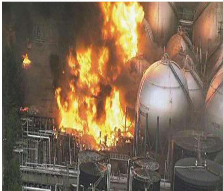
Figure 21: L'explosion de l'usine GNL à Skikda du 19 janvier 2004 (Source : http://www.liberte-algerie.com/environnement/ )
