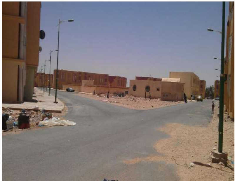
Figure 142 : L'impact du manque partiel des aménagements extérieurs sur l'hygiène et le désordre urbain (Source : Sofrani K , juin 2016)
