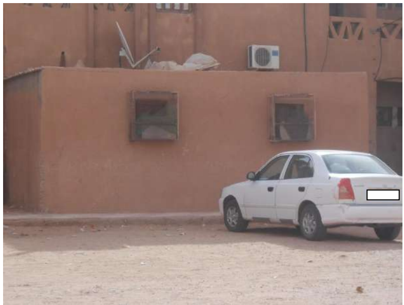
Figure 122: Rajout d'une pièce au logement en occupant La voie publique (Source : Sofrani K, 22 mars 2017)
