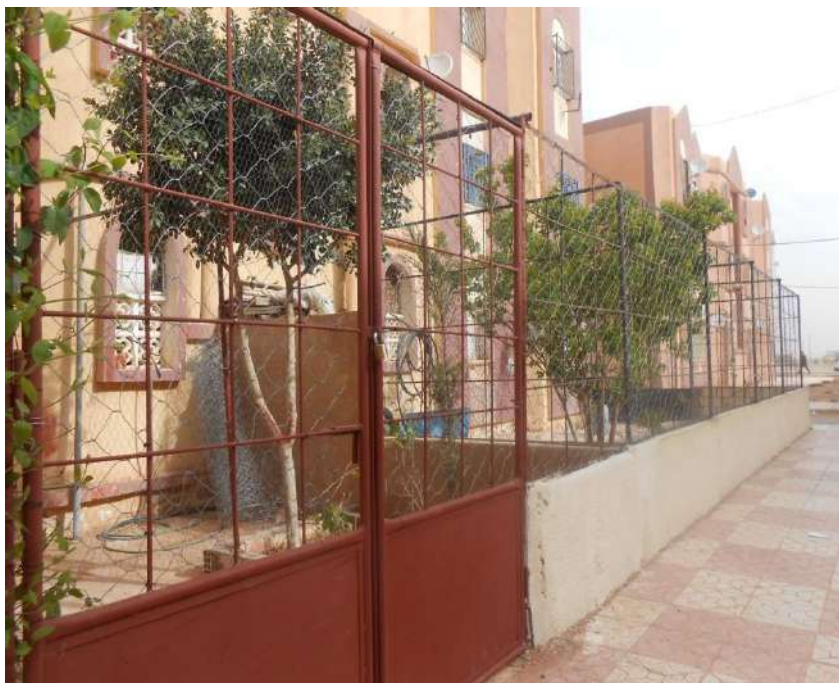
Figure 124 : Rajout d'une surface longeant la façade servant de jardin pour les habitants de l'immeuble (Source : Sofrani K , 22 mars 2017)
