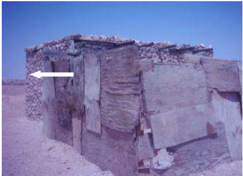
Figure 92 : Le passage progressif de la baraque en bois vers la construction en pierre (Source : Sofrani K janvier 2009)
