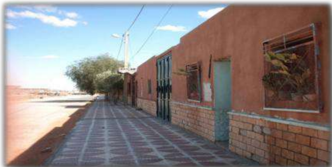
Figure 96 : Façade principale des 100 logements évolutifs – ville de Bellil (Source : Sofrani K , Juin 2009 )
