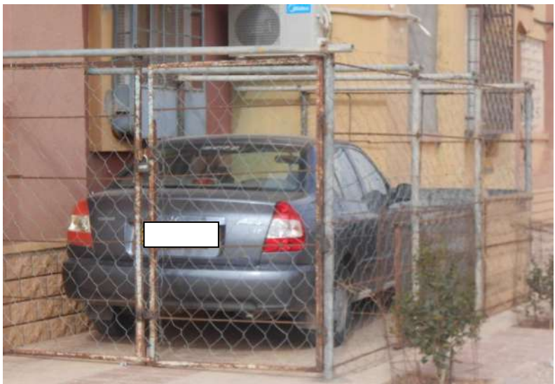
Figure 126 : Rajout d'un espace pour stationnement de voiture en structure métallique, en occupant la voie publique (Source : Sofrani K, 22 mars 2017)
