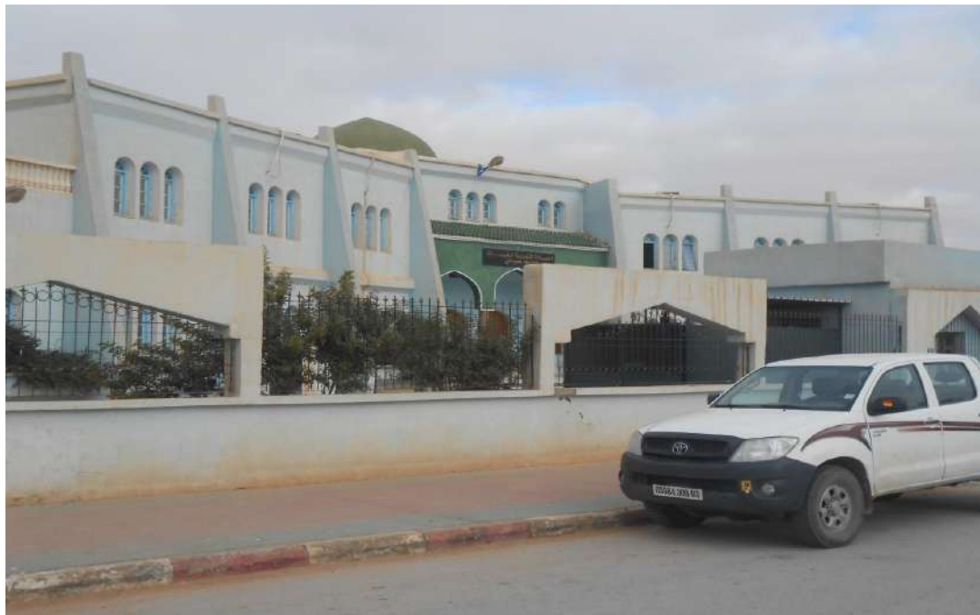
Figure 76 : La polyclinique de la ville nouvelle de Bellil (Source : Sofrani K le 01fevrier 2016)
