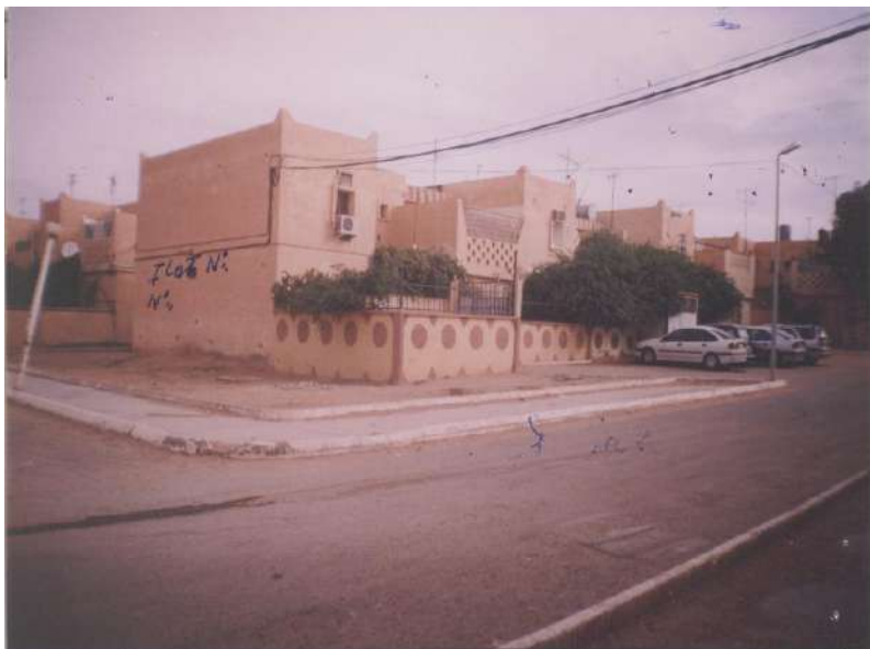
Figure 61 : Extension d'un logement semi collectif sur la voie publique à Hassi R'mel (Source : APC Hassi R'mel 2009).
