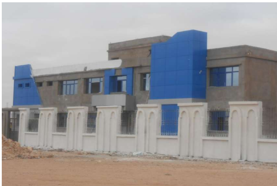
Figure 78 : projet du nouveau siège de sureté de la ville nouvelle de Bellil en phase d'achèvement (Source : Sofrani K le 01juin 2016)
