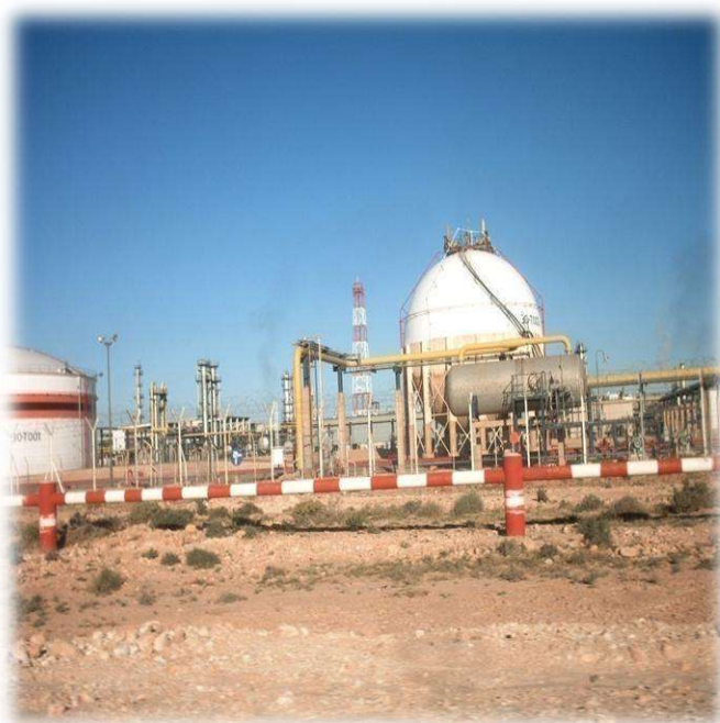
Figure 157 : Module 3 du pôle industriel de Hassi R'mel.
