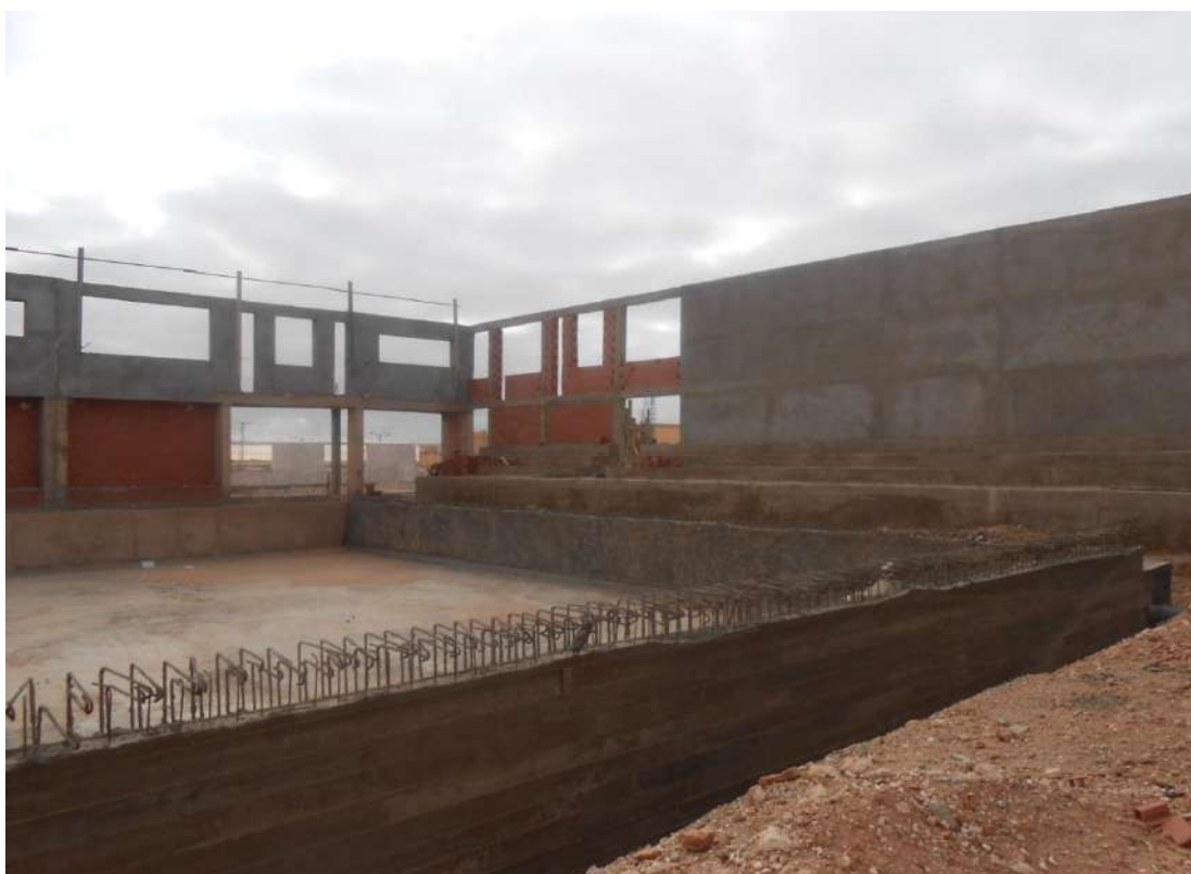
Figure79 : Projet de la piscine de la ville nouvelle de Bellil (Source : Sofrani K le 06 février 2016)
