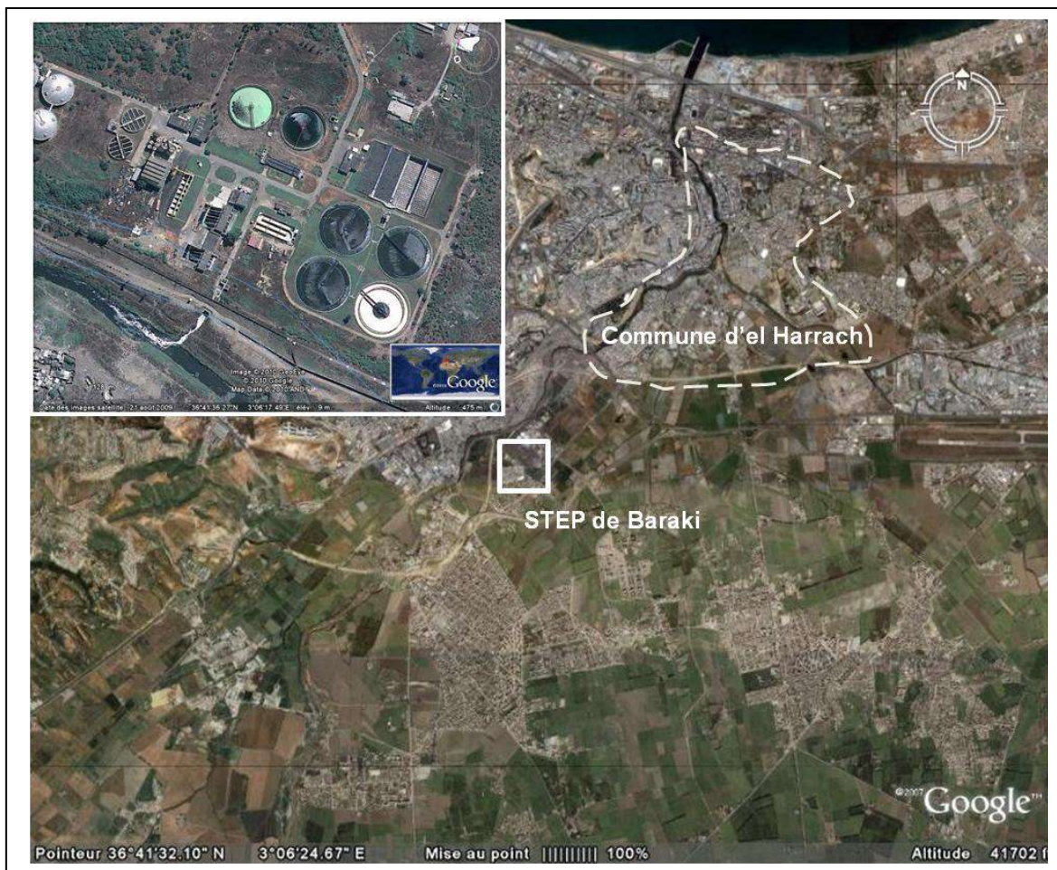
Photos aériennes 47-48: STEP de Baraki et rejets dans l'oued (Google Earth).
