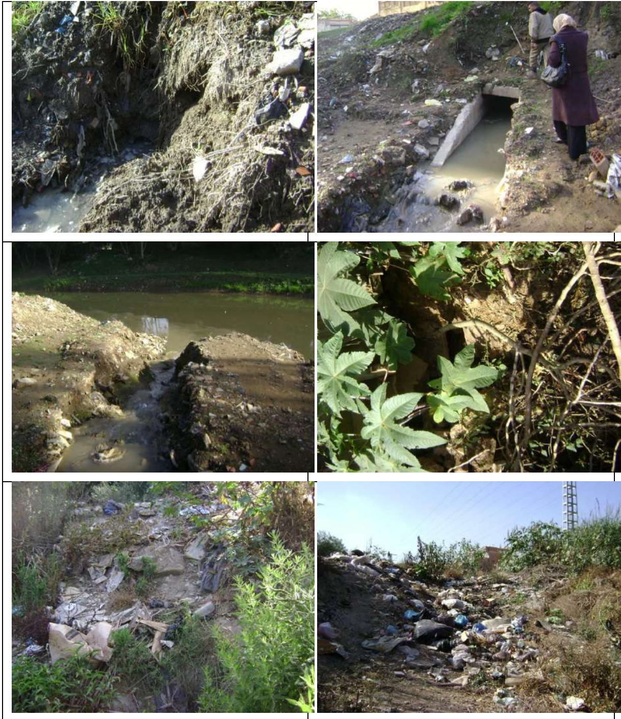
Photos 49-54: Rejets illicites d'eaux usées et de déchets dans l'oued et sur ses berges (Auteur, 2009-2010).
