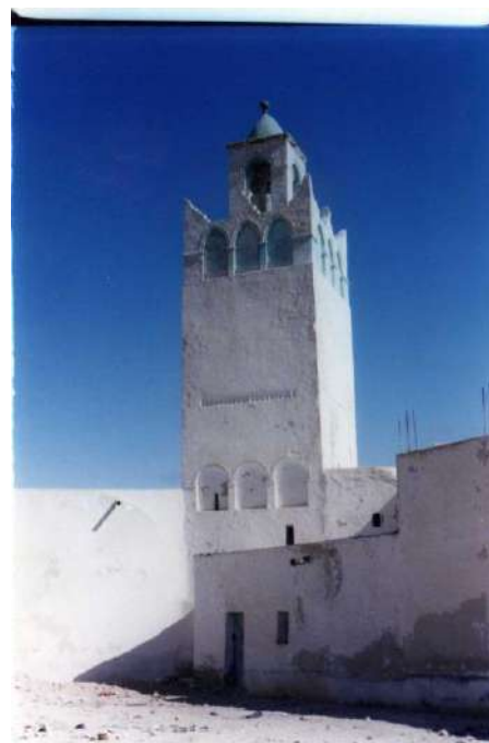
PH.30-Le minaret de la grande mosquée de Touggourt ; Photo : SELAMI / Date : 1994
