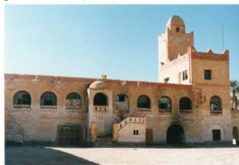
Façade est de la maison "RANOU", (photo SS, 2011)
