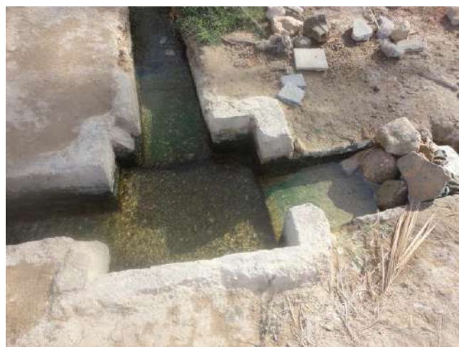
PH.02- Répartition des eaux par petits bassins Photo SELAMI, 2013
