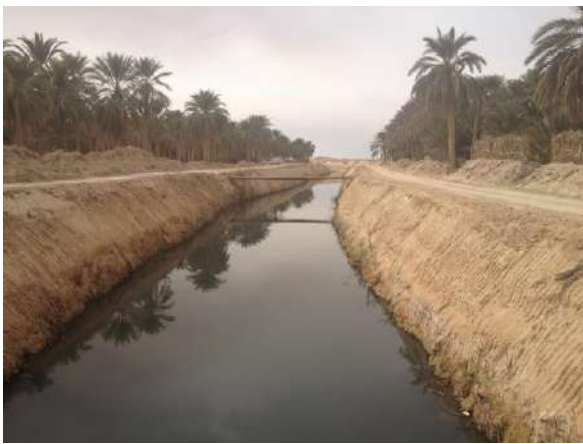
PH.03-Le canal de drainage principal Oued Righ Photo SELAMI, 2011
