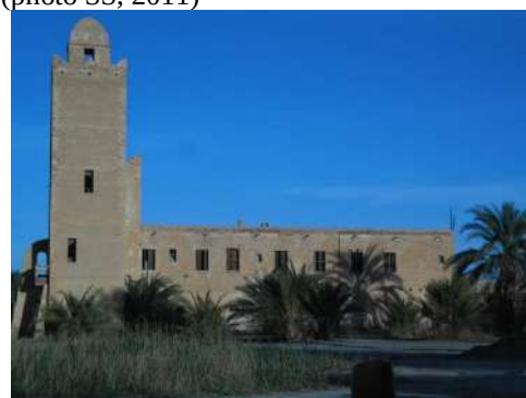
Façade ouest de la maison "RANOU",
