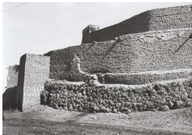
PH.09- La muraille de Témachine édifiée sur les troncs de palmiers (ancienne photo, source: association Schams, Témachine)
