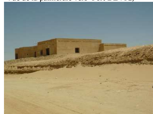
Angle sud-ouest (Photos SS, 2013)
