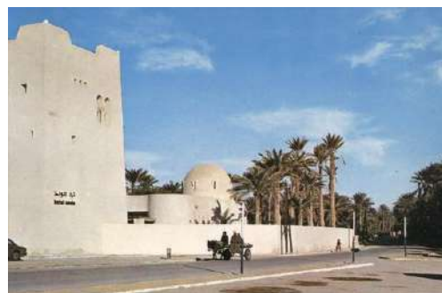
Hôtel des "Oasis"; Vue sur façade principale
