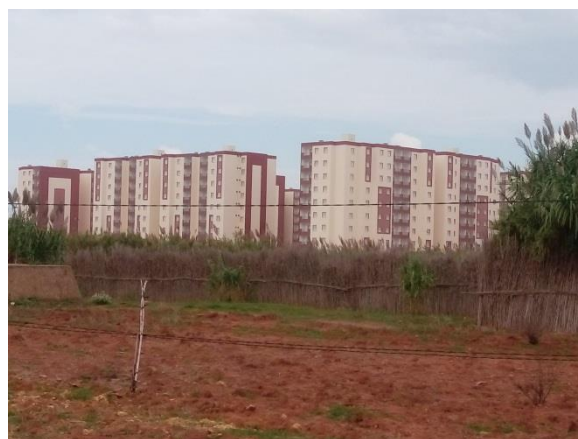
Figure 35. Réalisation de logements collectifs sur les terres agricoles de la commune d'Ain Benian (Source : auteur, prise le 02/10/2017)
