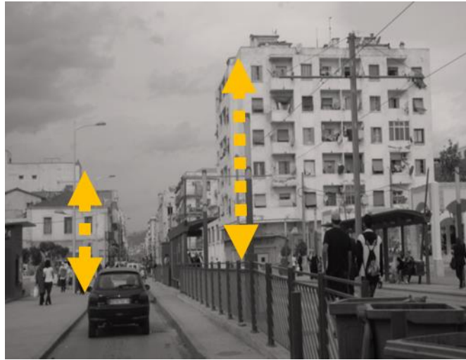
Fig34 : Photo de l'incohérence du gabarit au niveau de tripoli
