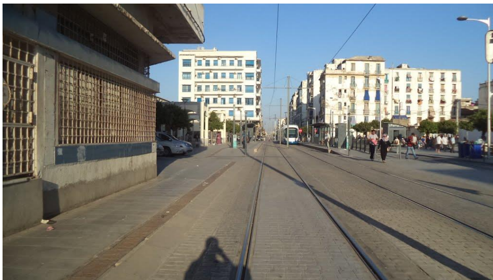
Fig43 : La ligne de tramway e long de la rue Tripoli
