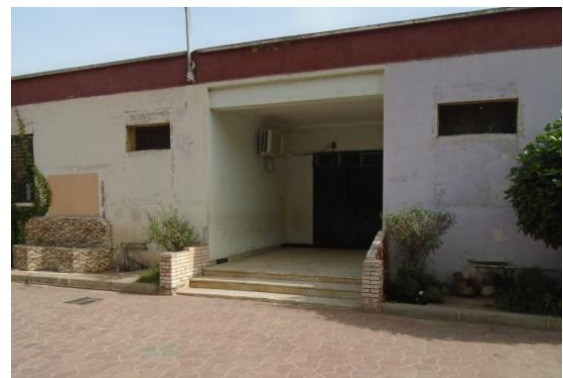
Figure 51. Accès du bloc « B » côté jardin - (L'auteur 2016)
