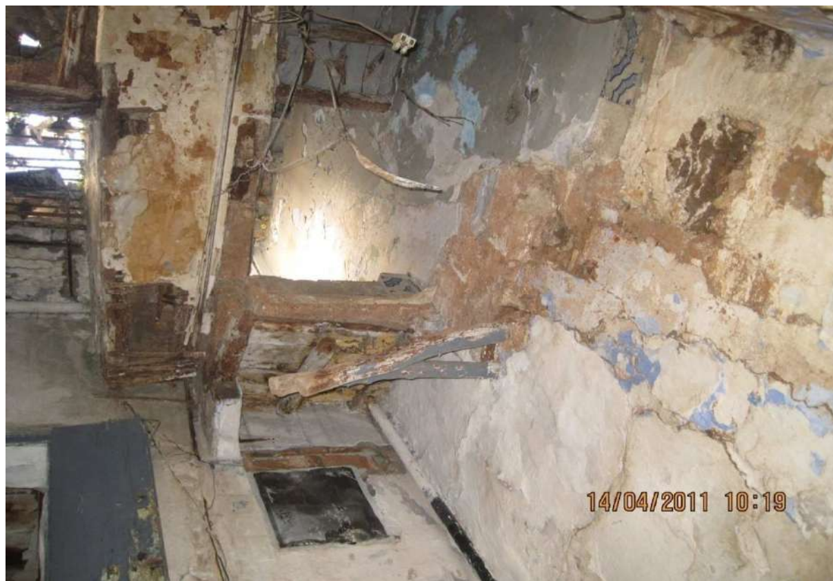
Photo 12 : le changement de direction de la structure d'estrade pour éviter l'arc de porte 252
