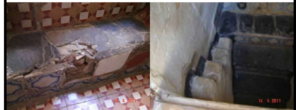
Le schiste des marches et la céramique des cotremarches
