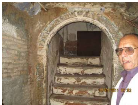
N° 31 rue Benghanif: les carreaux des marches.
