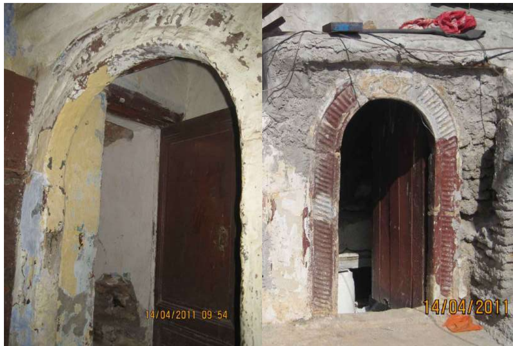
N°31 rue Benghanif: Chambranles en tuf
