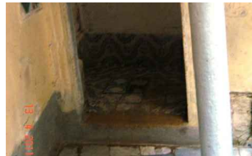
les carreaux de carrelage.
