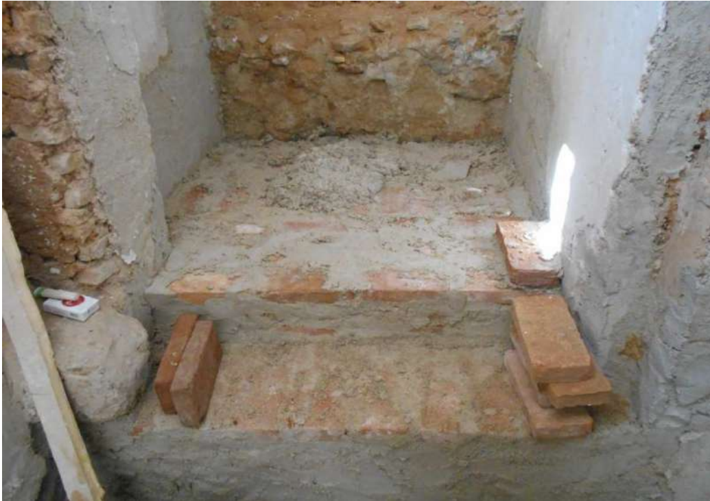
Photo 4 : la reconstruction en cours des marches en maçonnerie traditionnelle 221 .
