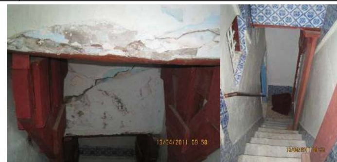
Vues sur les estrades de l'escalier.
