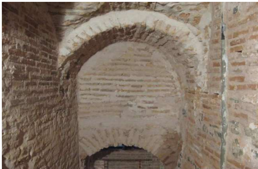
Photo 17 : La voûte en berceau de l'escalier du Hammam des janissaires 276 .
