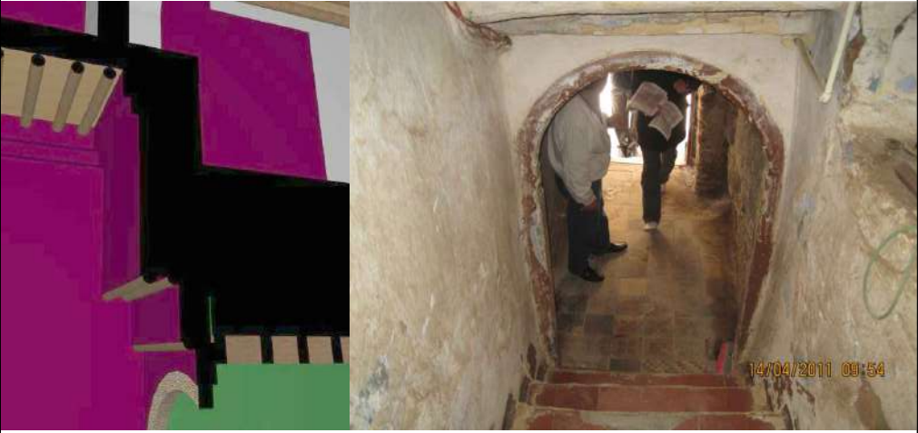
31 rue Benghanif :détail structurel .
