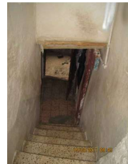
les revêtements de l'escalier.
