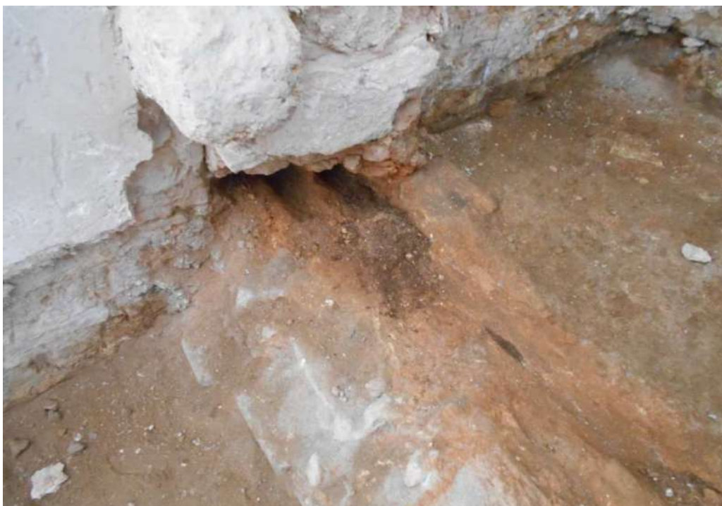
Photo 7 : Les traces des rondins de chainage trouvées au niveau du seuil de porte de l'escalier 224 .
