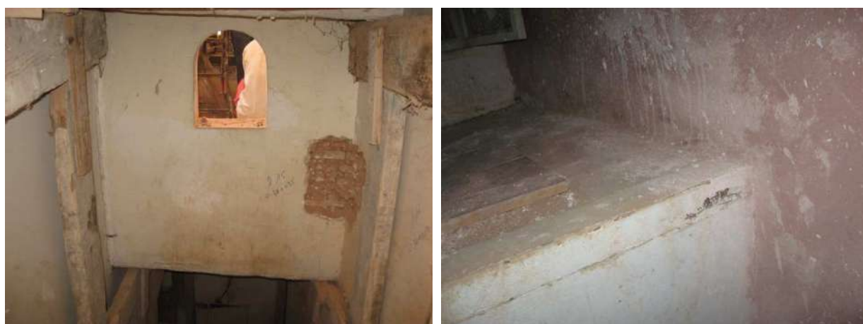
Photo 24 : La Seda de l'escalier de Djnen Lakhdar 293 .
