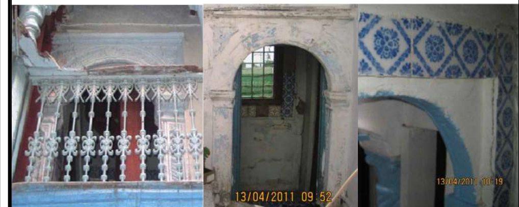
Chambranles des portes.
