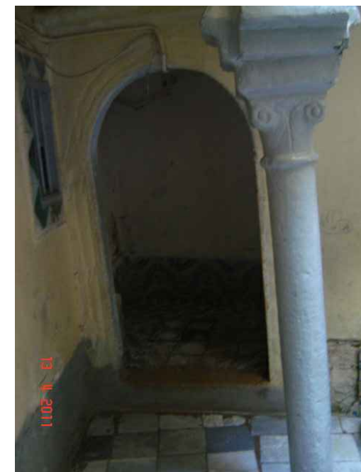
le chambranle du RDC.
