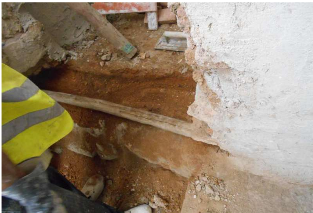
Photo 8 : La restitution en cours des rondins de chainage du seuil de porte de l'escalier 225 .
