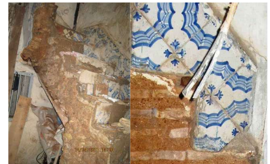
les carreaux des contre-marches et des plinthes.
