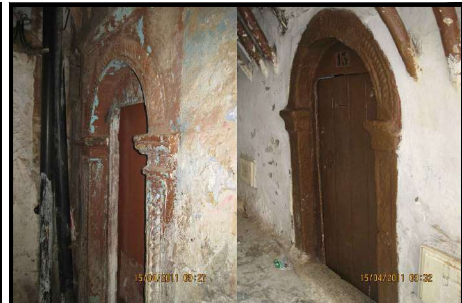
13 & 15 impasse des frères Belhimer. Façade Sud.
