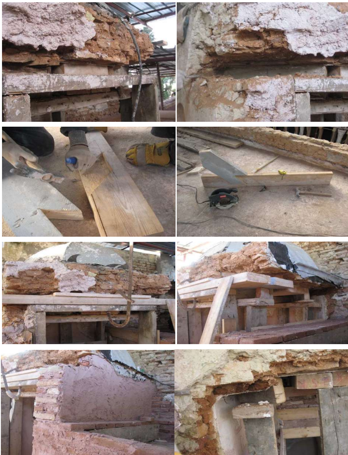
Photo 22 : Les différentes étapes de la restauration du volume de la sortie vers le Stah 289 .
