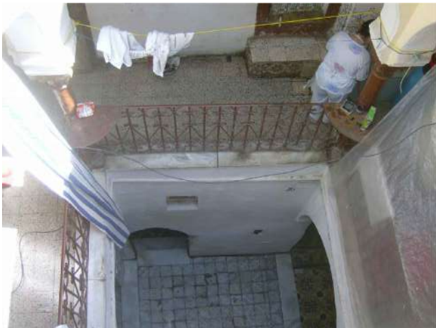
les revêtements de l'escalier.
