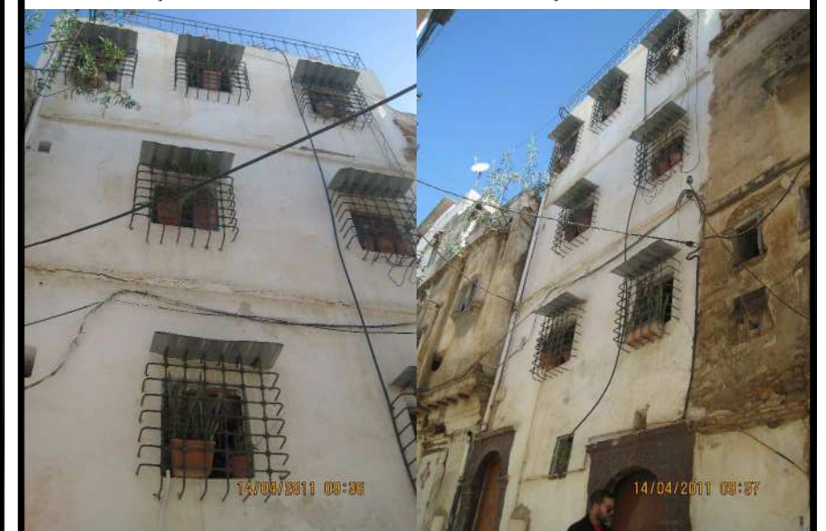
33rue Benghanif Façade Sud-Ouest
