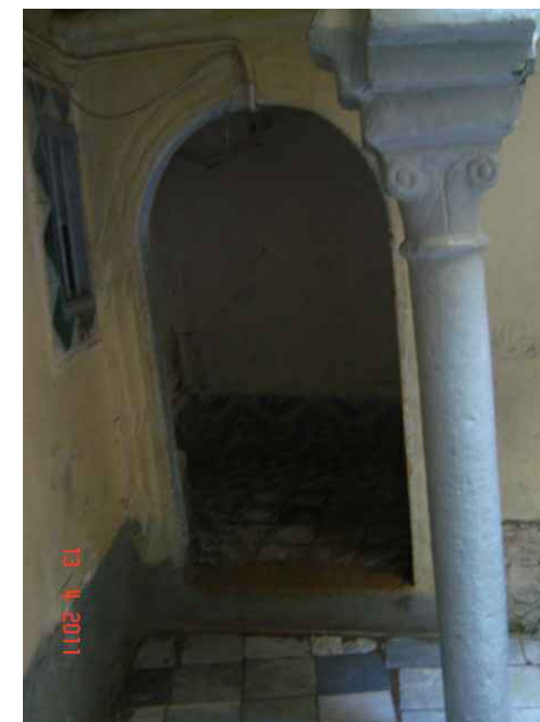
le chambranle du RDC.
