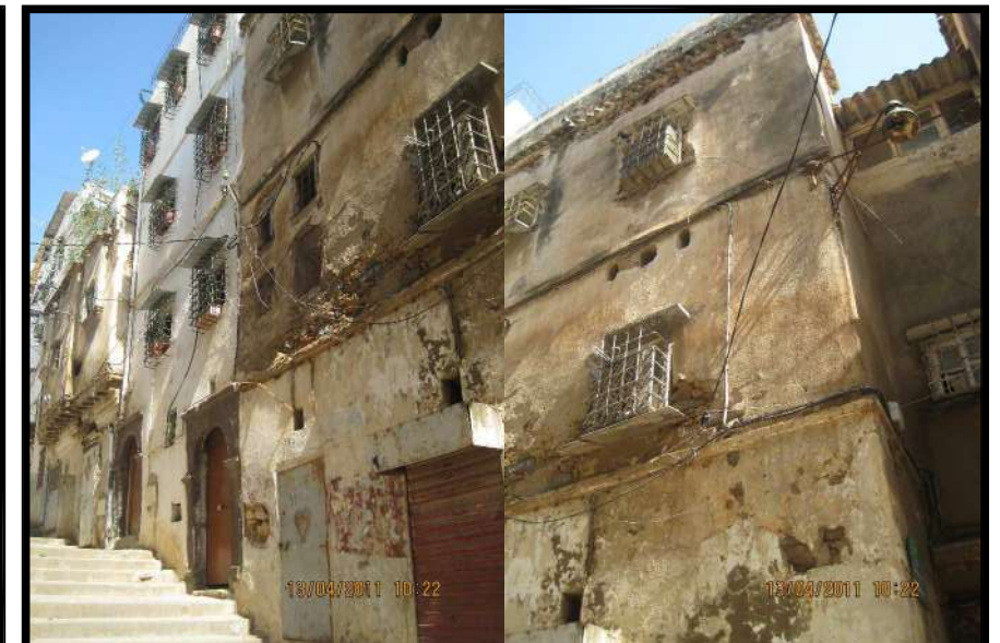
31/33 rue Benghanif Façade Sud-Ouest
