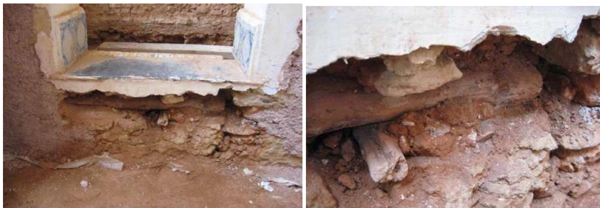
Photo 26 : Les rondins du seuil de la porte 295 .
