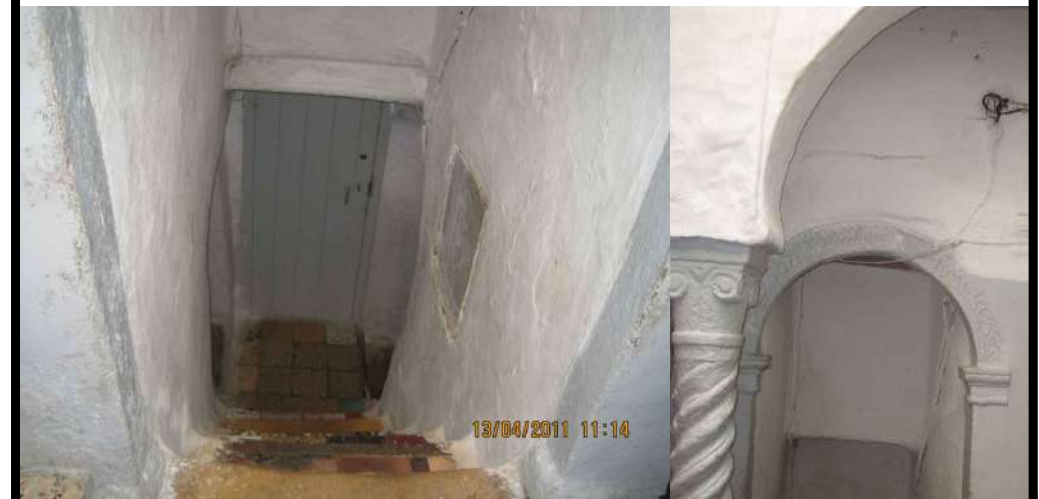
les carreaux des contremarches.
