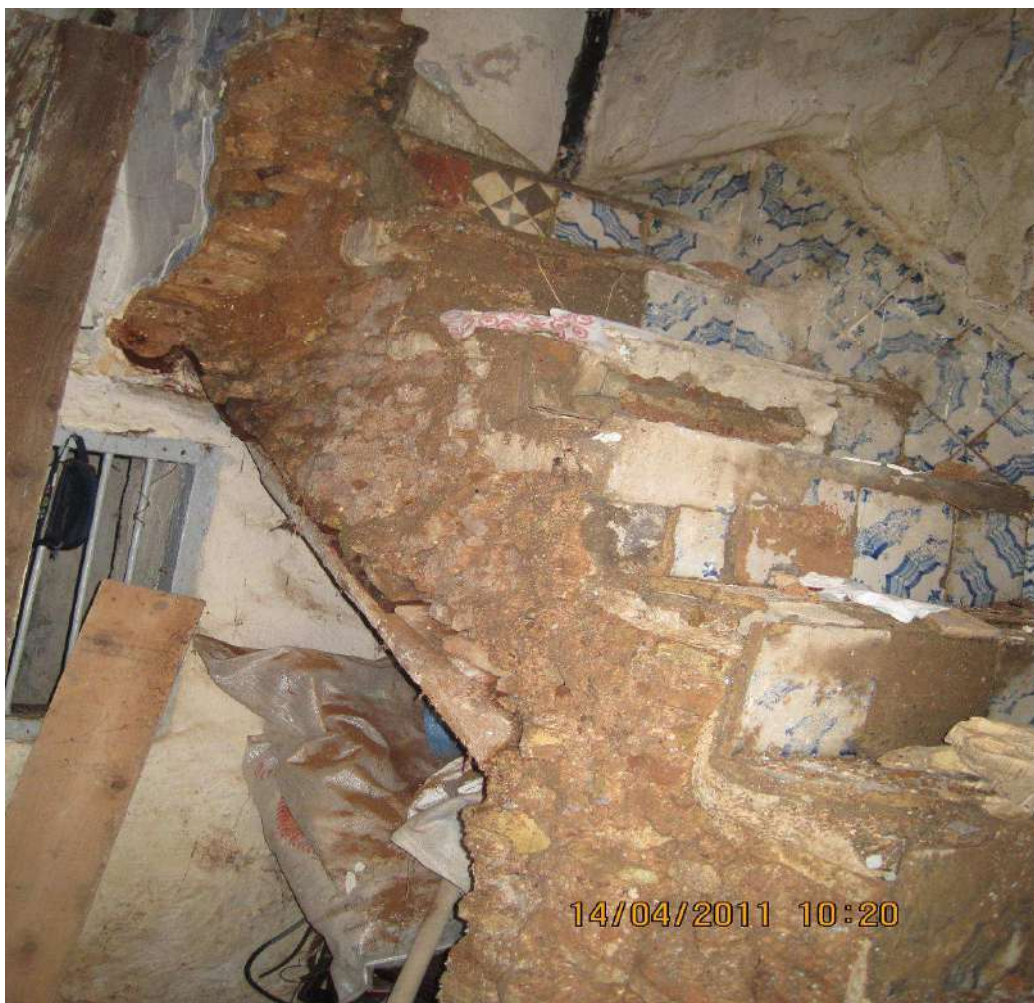
Photo 14 : Les rondins porteurs inclinés 262 .
