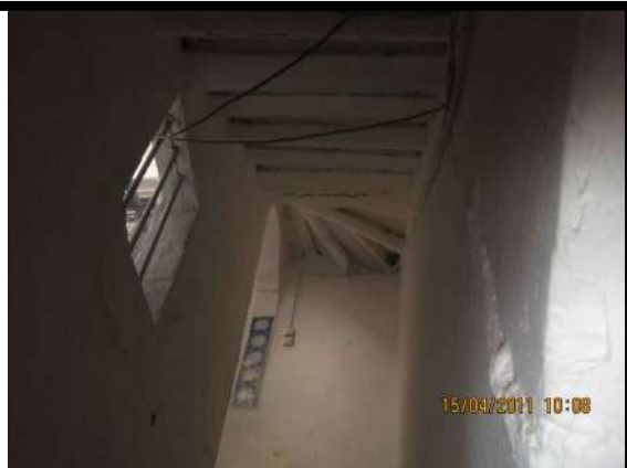
13 impasse des frères Belhimer : la structure du volume d'escalier .
