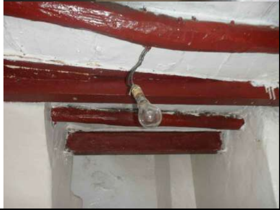
15 impasse des frères Belhimer : la structure du volume d'escalier .
