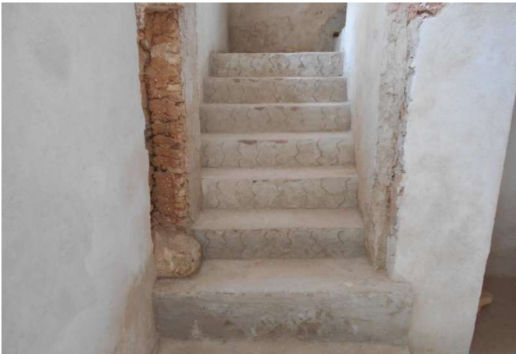
Photo 5 : les marches reconstruites en maçonnerie traditionnelle 222 .
