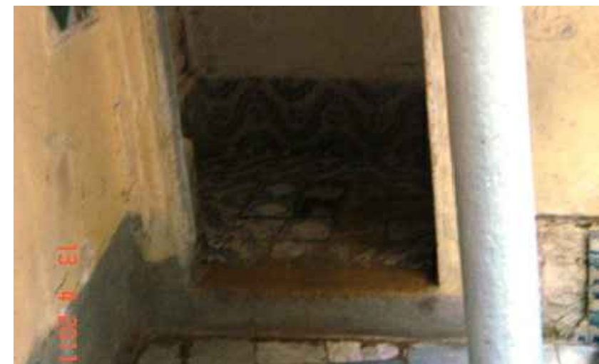
les carreaux de carrelage.
