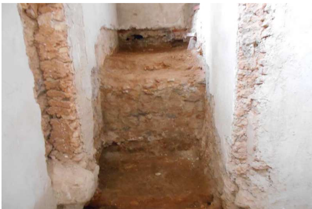
Photo 3 : L'escalier du Hammam des janissaires après la dépose du béton armé 220 .
