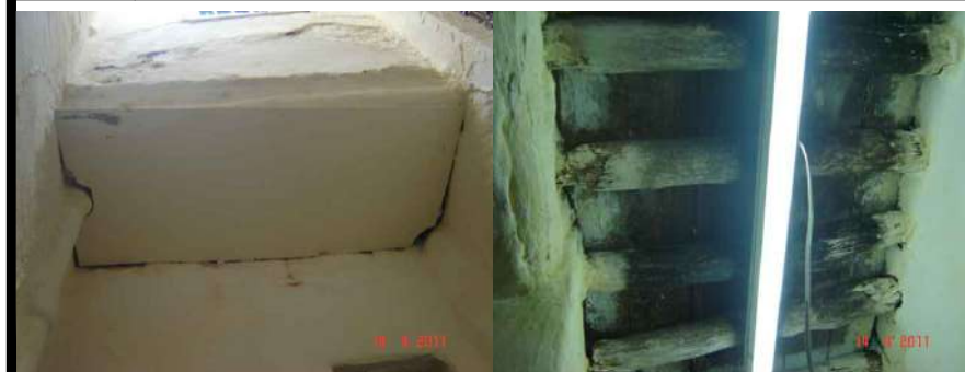
Vue sur le plancher du couloir .
