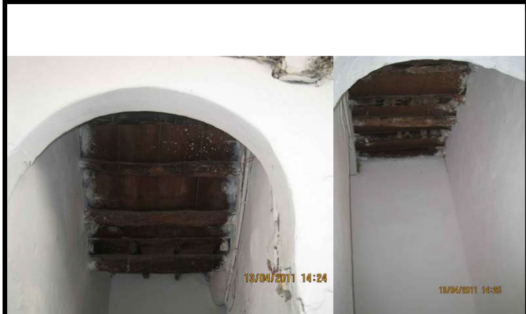
La structure du volume d'escalier.
