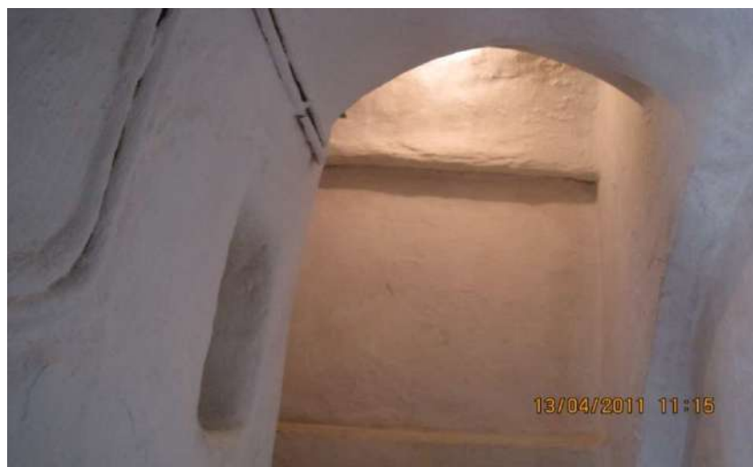
Photo 16 : Les arcs de décharge et le rondin porteurs des voûtes en berceaux 272 .
