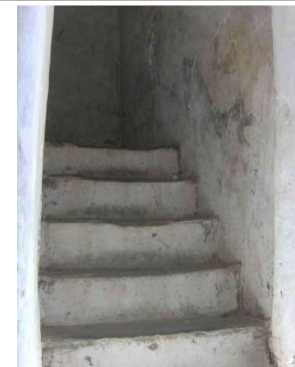
les revêtements de l'escalier.
