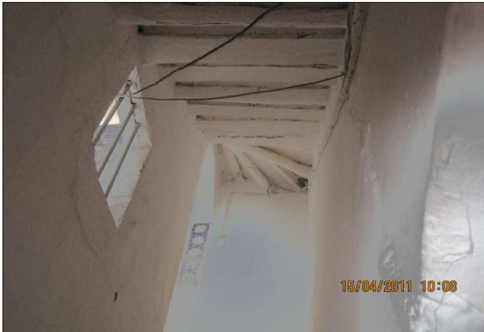
Photo 11 : structure mixte (solives: rondins) des estrades 246 .
