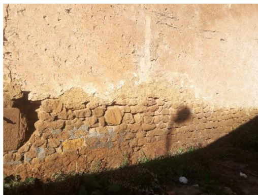
Figure 61: Murs extérieur (façade est, cour1).
