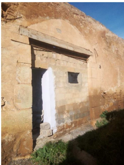
Figure 59: La fermeture de l'une des entrées principales de la cour 1 (façade est).
