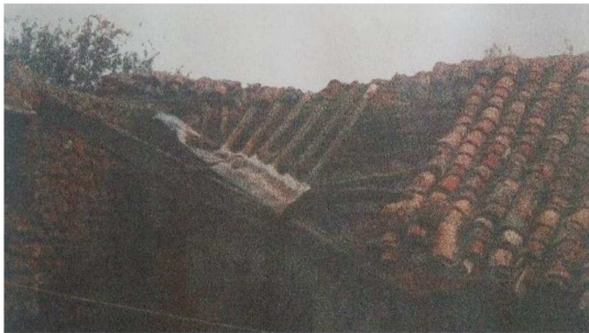
Figure 107: Disparition des tuiles, le coin nord-est, cour 1.
