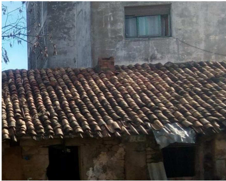
Figure 63: Tuiles demi circulaire.
