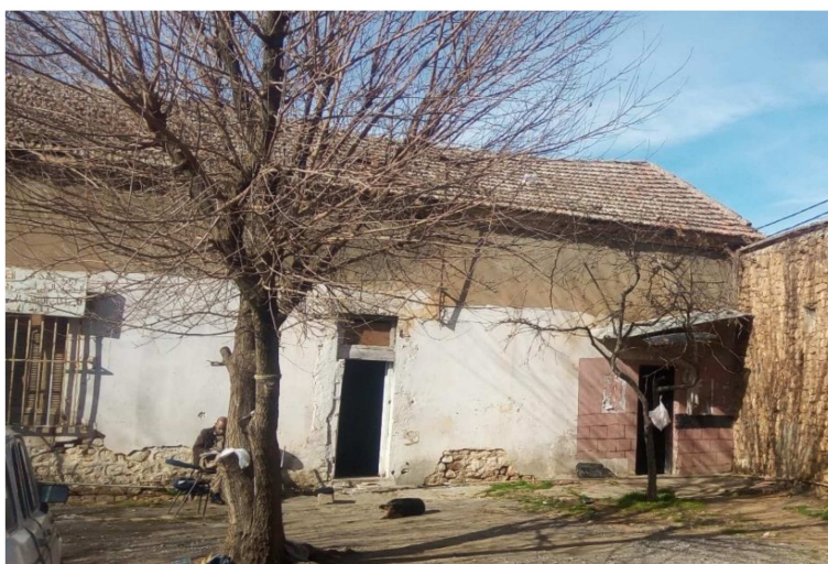
Figure 127: Utilisation du mortier à base du ciment, façade ouest, cour1
