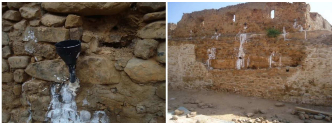
Figure 116: La cimentation par coulée, Bordj Hamza, Bouira, Algérie.
