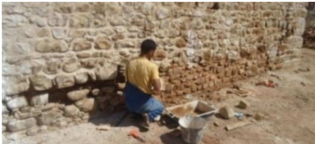
Figure 130: Application d'un mortier à base de chaux sur un mur en maçonnerie de moellon, Bordj Hamza, Bouira, Algérie.
