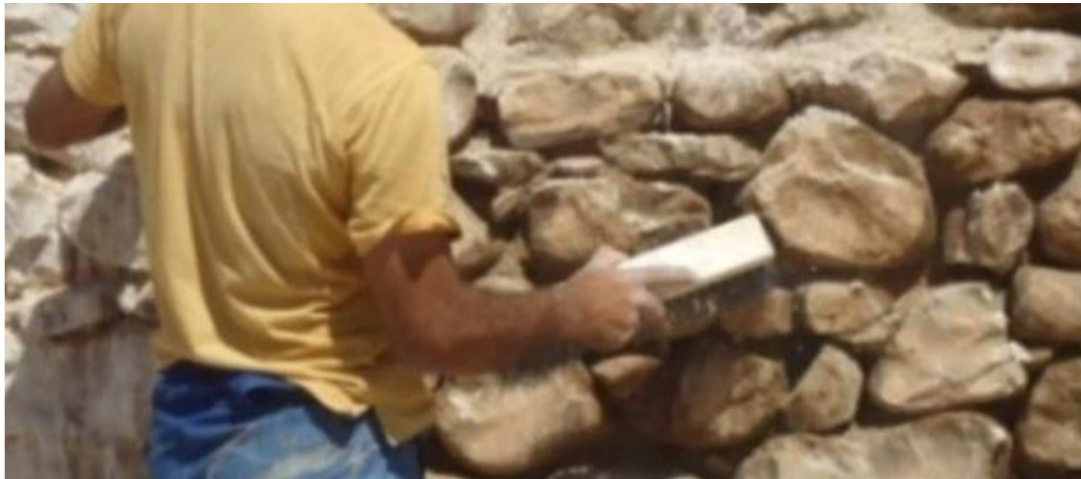
Figure 129: Frottage à la main des joints, Bordj Hamza, Bouira, Algérie.
