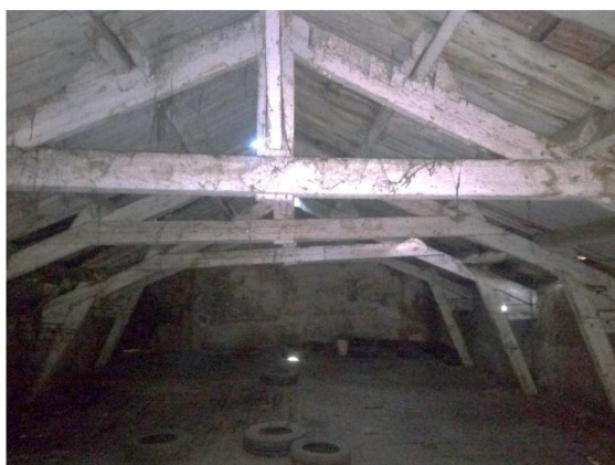
Figure 55: La ferme du comble.
