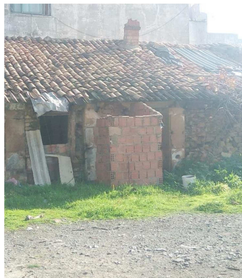
Figure 60: La construction d'une nouvelle pièce (la cour 1).
