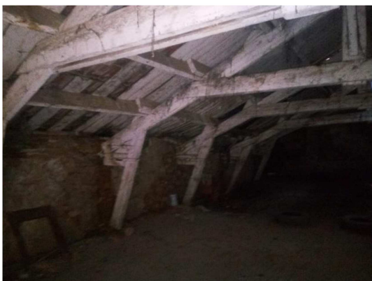
Figure 67: La ferme du comble.
