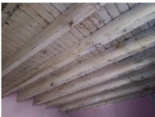
Figure 65: Plancher à la française.
