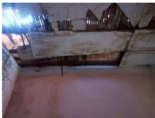
Figure 66: Plafonds de la partie ouest de la cour 2.
