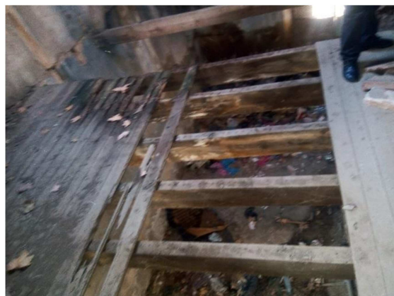
Figure 106: La disparition de quelques poutrelles et lames en bois.
