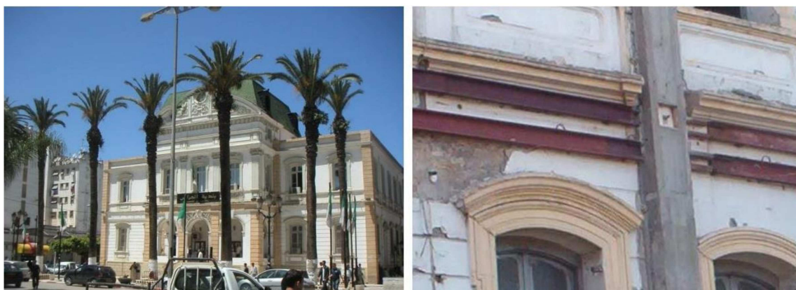
Figure 121: Consolidation par des tirants métalliques, la mairie d'El Harrach.
