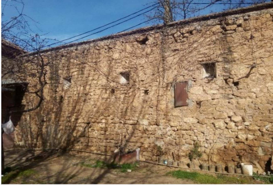
Figure 53: Le mur de la façade nord (vue de l'intérieur de cour 1).
