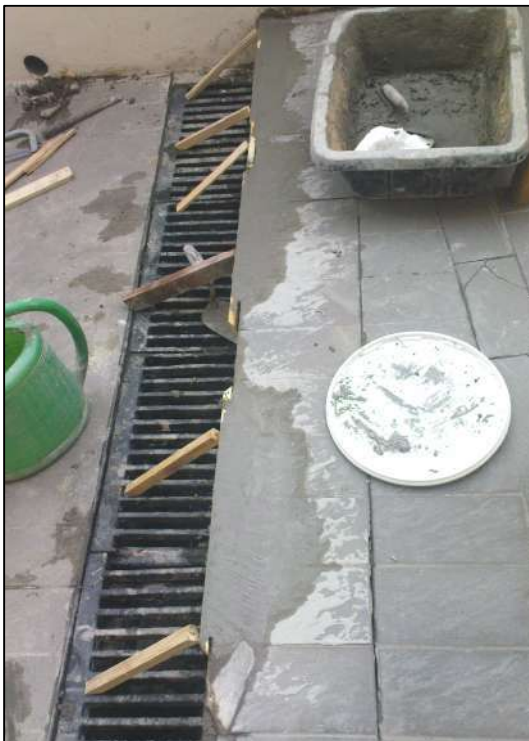
Fig. 45 : Comblement des zones effritées du sol 200
