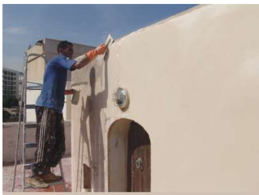
Fig. 38 : Badigeonnage au lait chaux 199
