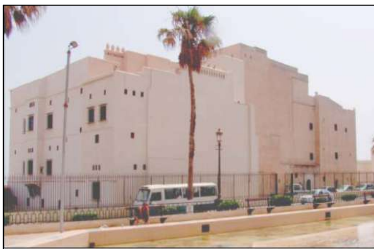
Fig. 3 : Aspect général du Palais des Raïs après restauration 7
