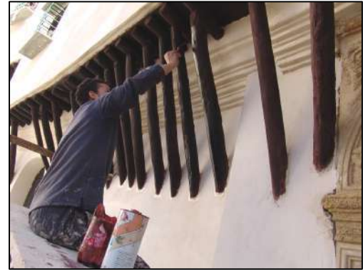
Fig. 55 et 56 : Travaux de peinture sur l'ensemble des éléments en bois et en ferronnerie
