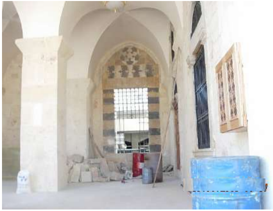
Fig. 6 : Travaux de maintenance de la Grande Mosquée des Omeyyades
