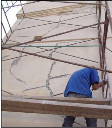
Fig. 31 et 32 : Détection de lézardes et effritement de l'enduit des façades Source : Photos prises en 2004 par les services de préservation du Palais des Raïs 194
