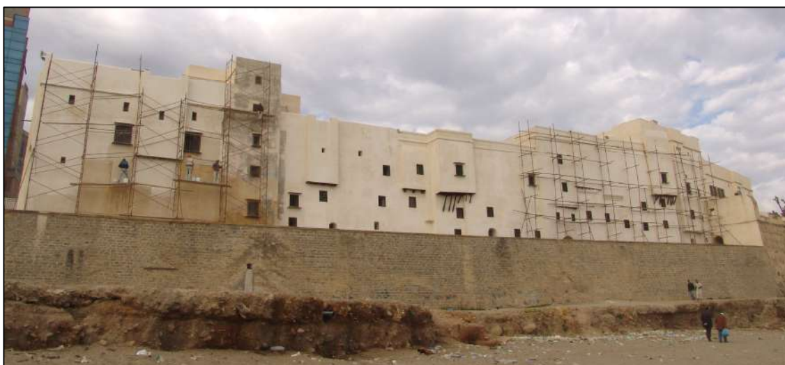
Fig. 40 : Nettoyage et badigeonnage de la façade extérieure
