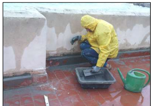
Fig. 46 et 47 : Comblement de zones effritées de la terrasse
