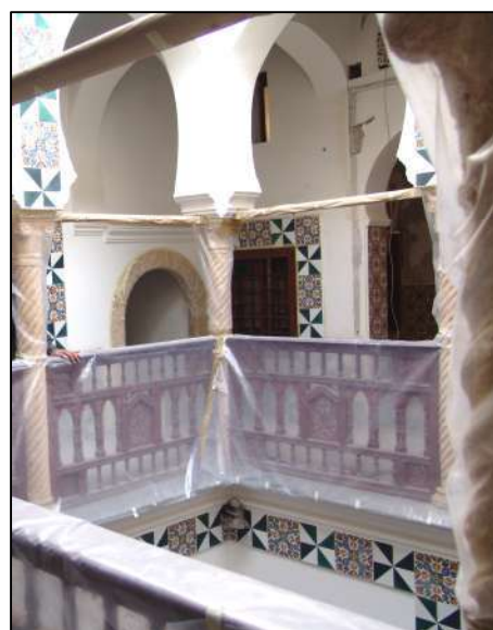
Fig. 36 et 37 : Protection de la boiserie et des colonnades d'un film protecteur adhésif lors de l'entretien des murs, Palais 17 198
