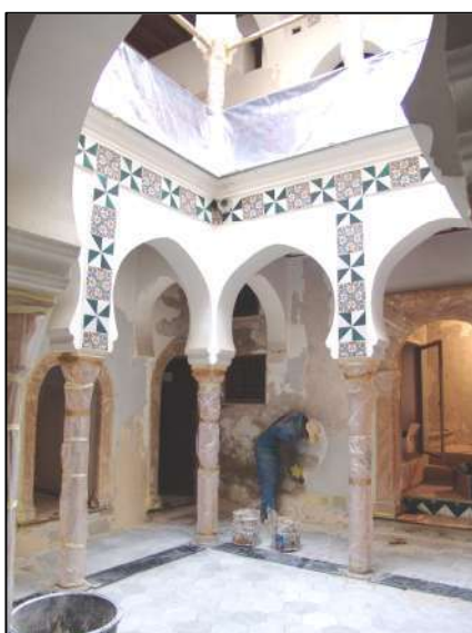
Fig. 36 et 37 : Protection de la boiserie et des colonnades d'un film protecteur adhésif lors de l'entretien des murs, Palais 17 198
