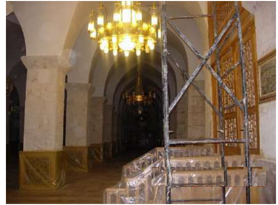
Fig. 7 : Protection des boiseries d'un film protecteur en plastique pendant les travaux de maintenance
