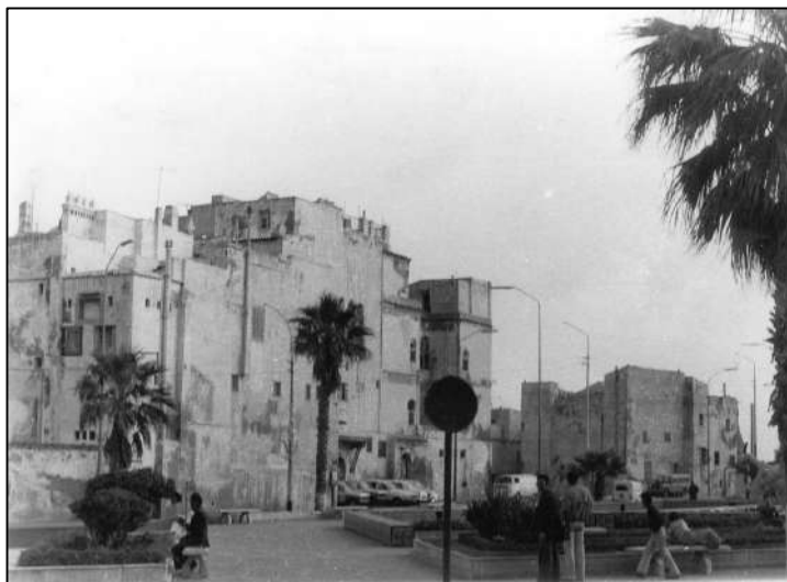
Fig. 2 : Aspect général du Palais des Raïs avant restauration
