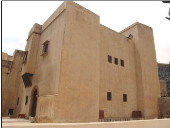
Fig. 33 et 34 : Salissures au niveau des façades 195
