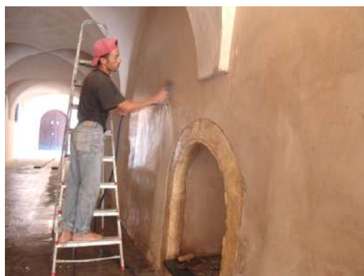
Fig. 39 : Nettoyage des façades à l'eau
