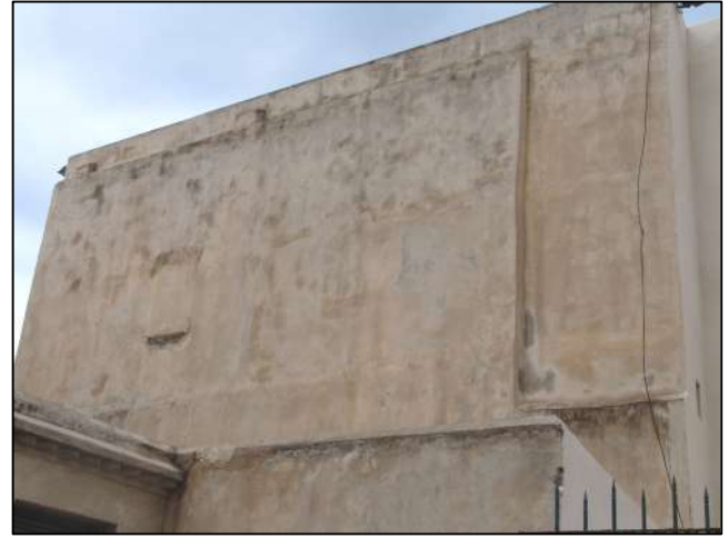
Fig. 31 et 32 : Détection de lézardes et effritement de l'enduit des façades Source : Photos prises en 2004 par les services de préservation du Palais des Raïs 194
