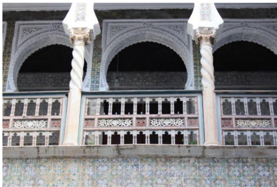
Fig. 27 : Balustrade en bois, Dar Aziza. Source : cliché personnel
