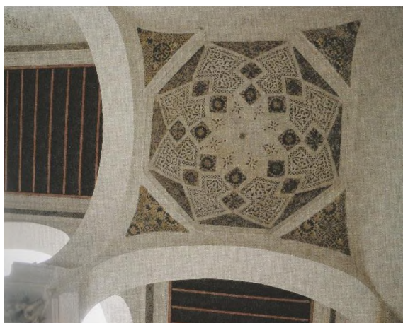
Fig. 29 : Coupole à l'angle de la galerie d'étage, Dar Aziza
