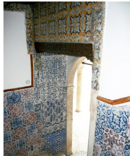
Fig. 62 : Utilisation de plusieurs types de faïence au niveau de l'escalier (Dar Hassen Pacha) Source : (BENOUNICHE. N ; 2012, p 478)
