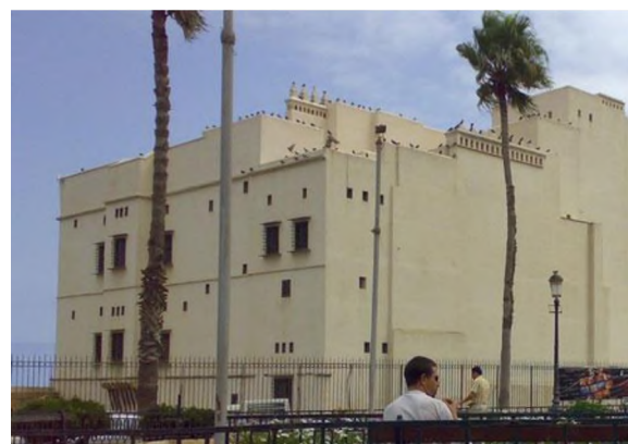
Fig. 15 : Palais 18, complexe du bastion 23 Source : cliché personnel
