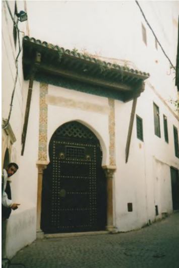
Fig. 20 : La porte d'entrée du palais Mustapha Pacha, Source : cliché personnel
