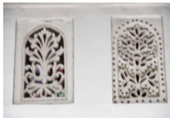
Fig. 30 : Claustras au-dessus d'une porte, Dar Aziza
