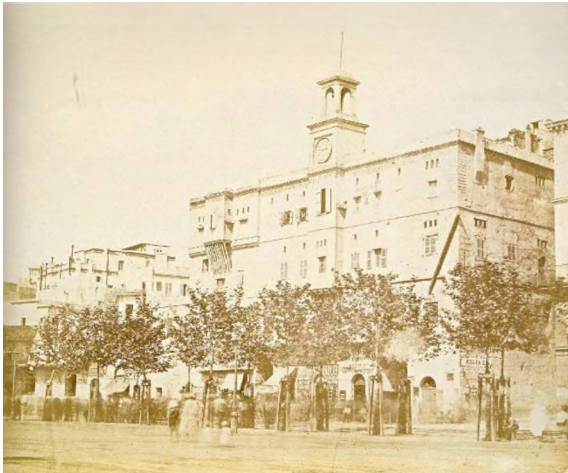
Fig. 12 : Le palais des Deys (Dar Essoltan) Source : ALLOULA. M ; 2001, p 70
